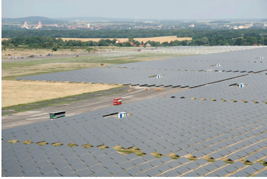
Şekil 3.12 Doğrudan Şebekeye Bağlı Bir Güneş Tarlası (Waldpolenz Güneş Tarlası, Almanya)
