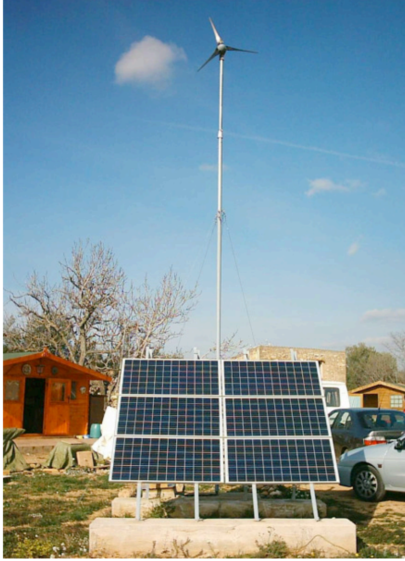
Şekil 3.18 Hibrit bir fotovoltaik sistem
