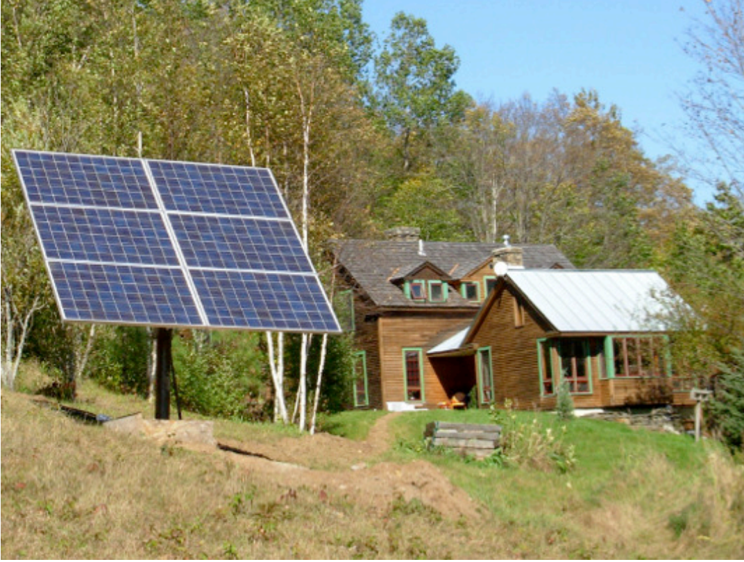
Şekil 3.14 Şebekeden bağımsız bir fotovoltaik sistem uygulama örneği
