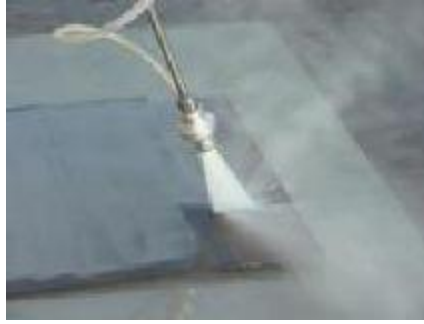
Şekil 8.1 Su jeti raspası ile yüzey temizleme uygulaması
