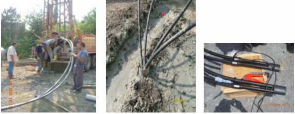
Şekil 8. 15 YYEE DTKIP Toprak devresinin sondaj ve yerleştirme çalışmaları [50]
