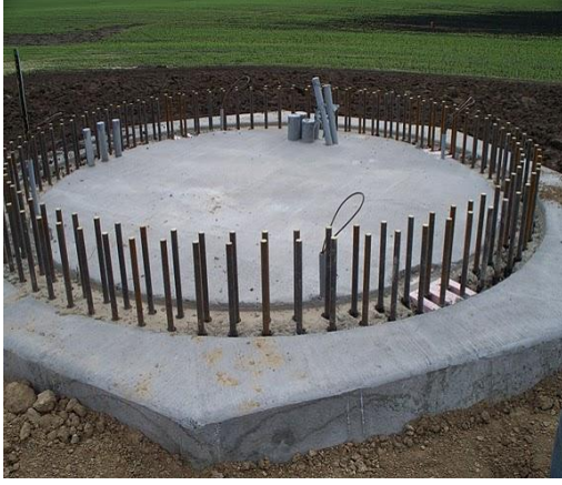
Şekil 4.25 Rüzgar türbini temel sistemi [62], [63]
