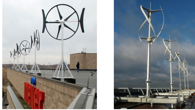
Şekil 4.21 (a) Seri bağlanmış olan nano fiber takviyeli polimerden yapılan yatay eksenli rüzgar türbini (b) Karbon-fiberglas Darrieus tipi rüzgar türbinleri [59]
