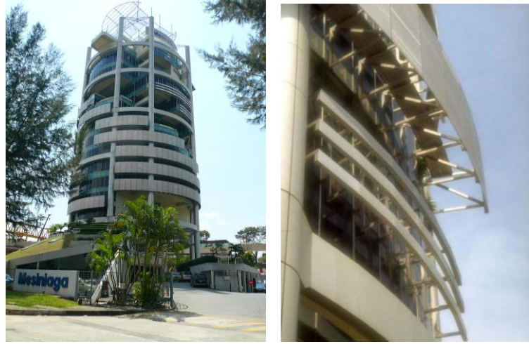
Şekil 7.6 Manera Mesiniaga Binası ve güneş kırıcıları [153]
