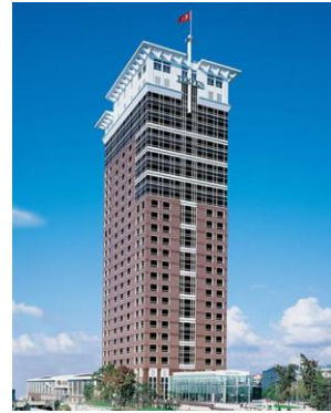
Tekfen Tower-İstanbul Füme üzeri güneş + ısı kontrol
