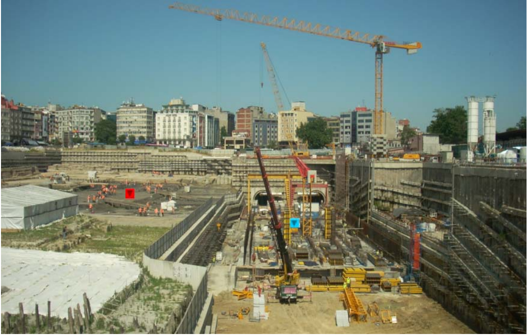
Şekil 4.21 Namık Kemal Caddesi'nden doğuya doğru görünüş, 2010 (Aydoğdu, Y., 2010) ■ Metro Kazı Alanı ■ Marmaray arkeolojik kazı çalışması biten inşaat alanı
