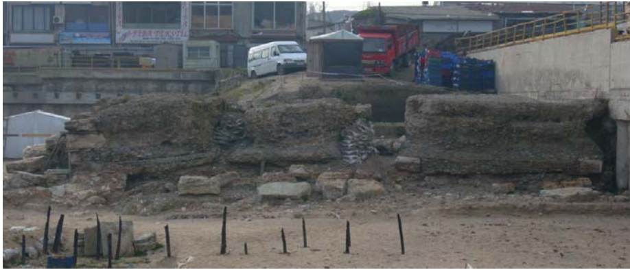
Şekil 4.37 Metro kazı alanı batı taraftaki iskele (Aydoğdu, 2011)
