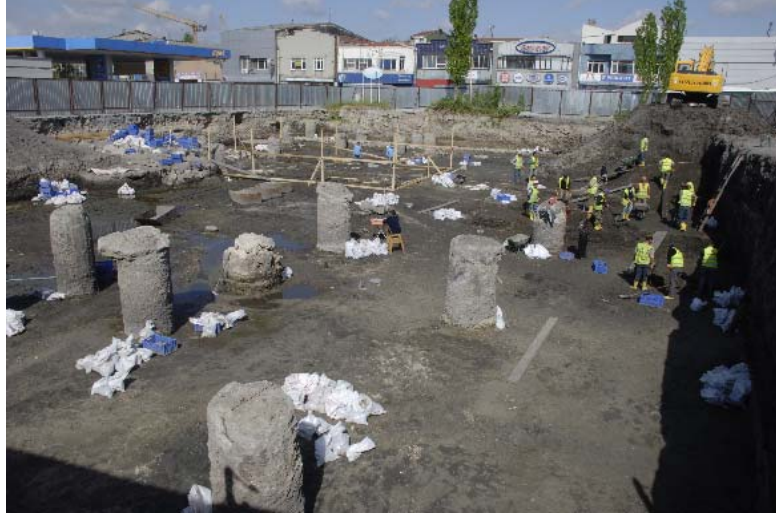
Şekil 4.73 Yenikapı trafo proje alanının genel görünümü (Köşker [188])
