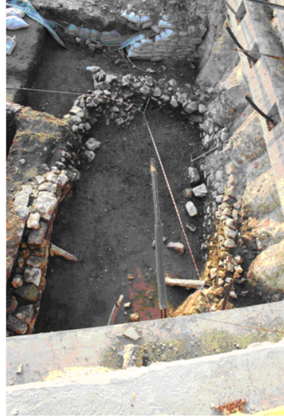
Şekil 4.79 Yenikapı Metro alanındaki yapıya çakılan beton kazıklar (Aydoğdu, Y., 2008)
