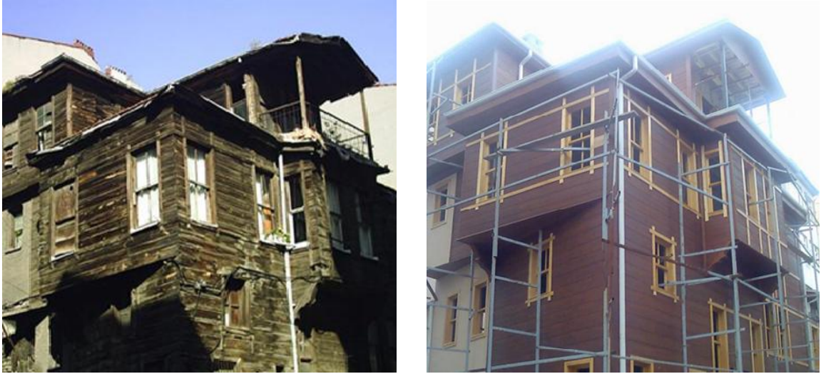
Şekil 5.5 Fatih İskenderpaşa'daki bir evin restorasyon öncesi ve sonrası hali [87]
