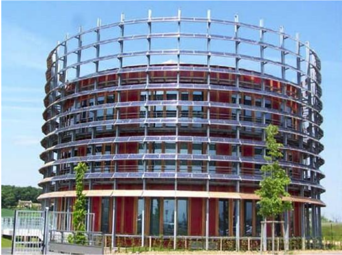
Şekil 5.12 SDED Ofis Binası [25]
