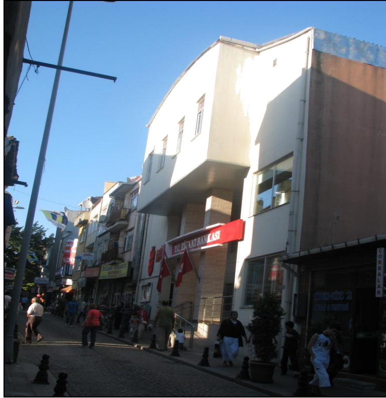
Fotoğraf 4.7 İstasyon Caddesi üzerinde bulunan kilise arsası üzerine inşa edilen iş merkezi (S. Sayar arşivi)
