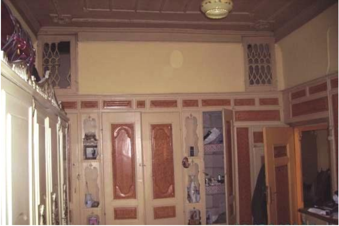
Şekil 4. 31 Kürtüncü Evi ahşap tavan ve duvar kaplamaları
