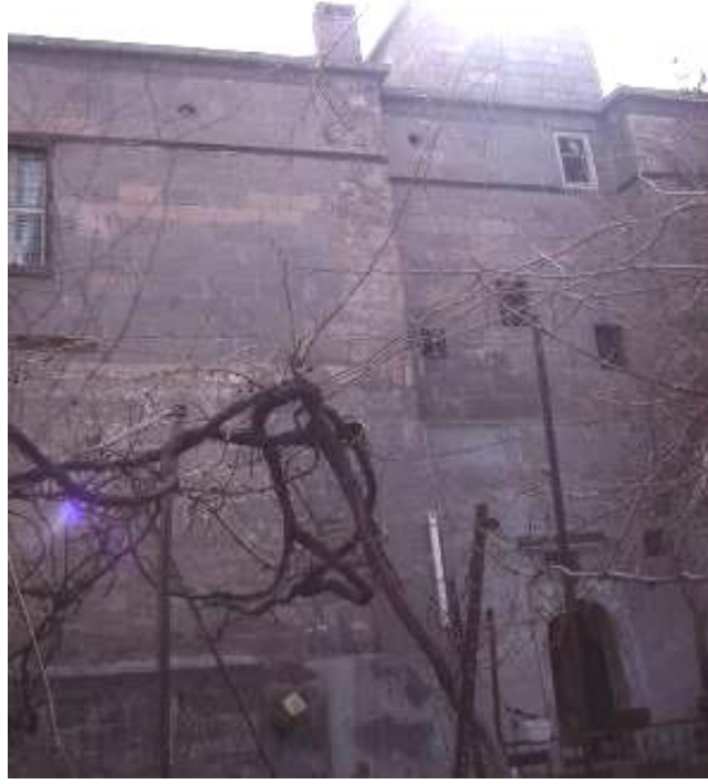
Şekil 4. 14 Kürtüncü Evi yan cephe (kuzey cephesi)
