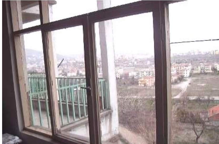
Şekil 4. 17 Muhdes birinci kat penceresi ve betonarme balkonu
