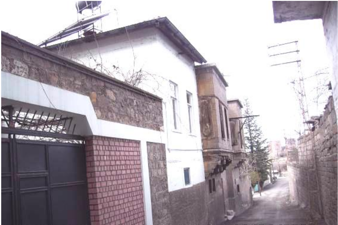
Şekil 4. 26 Kürtüncü Evi bitişik komşu yapı ile ön cephesi
