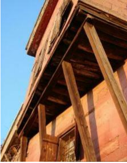
Şekil 3. 32 Talas geleneksel konutlarında ahşap kullanımı
