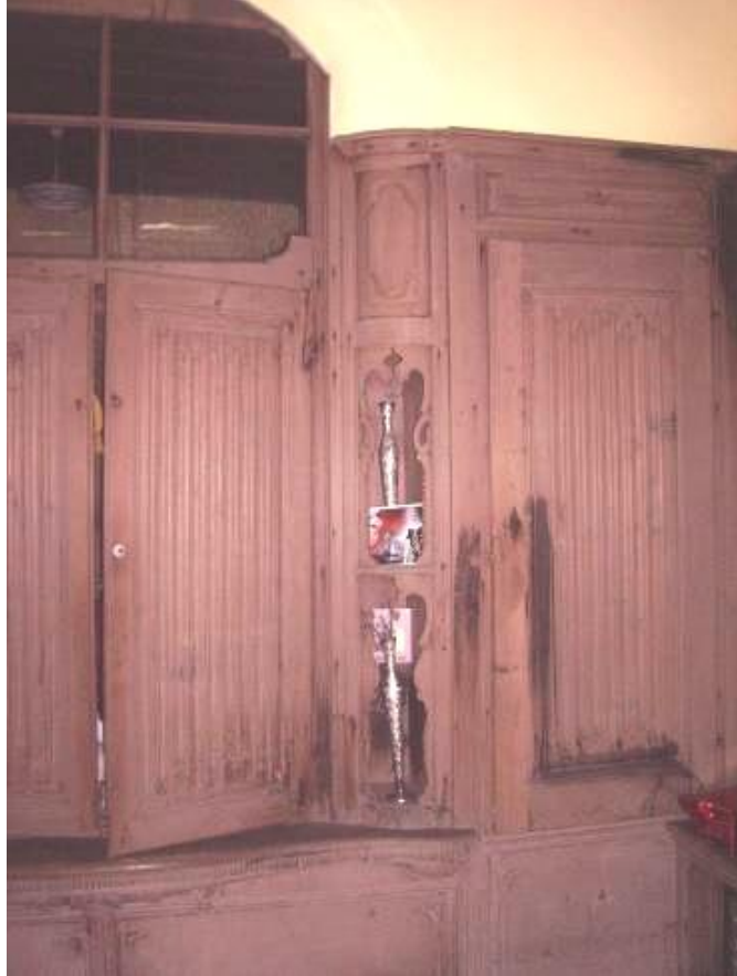
Şekil 4. 35 Kürtüncü Evi ahşap duvar kaplaması ve ahşap dolap
