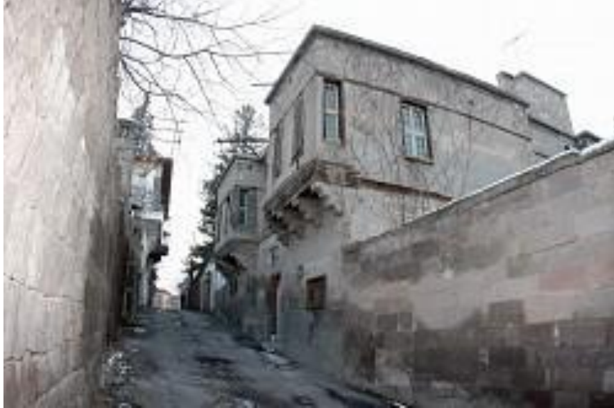
Şekil 4. 12 Kürtüncü Evi ön cephe (doğu cephesi)
