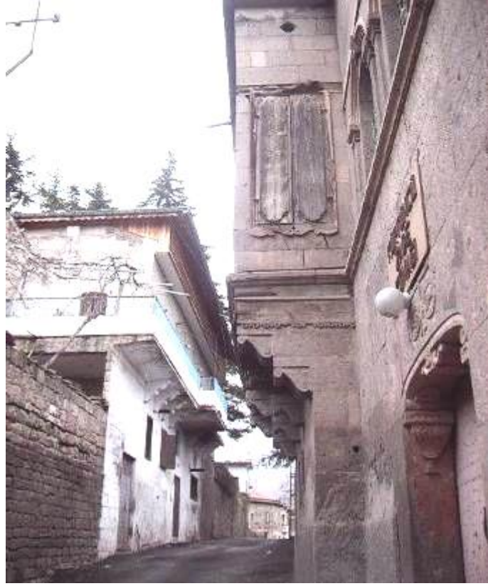
Şekil 4. 29 Kürtüncü Evi ahşap kepenkleri
