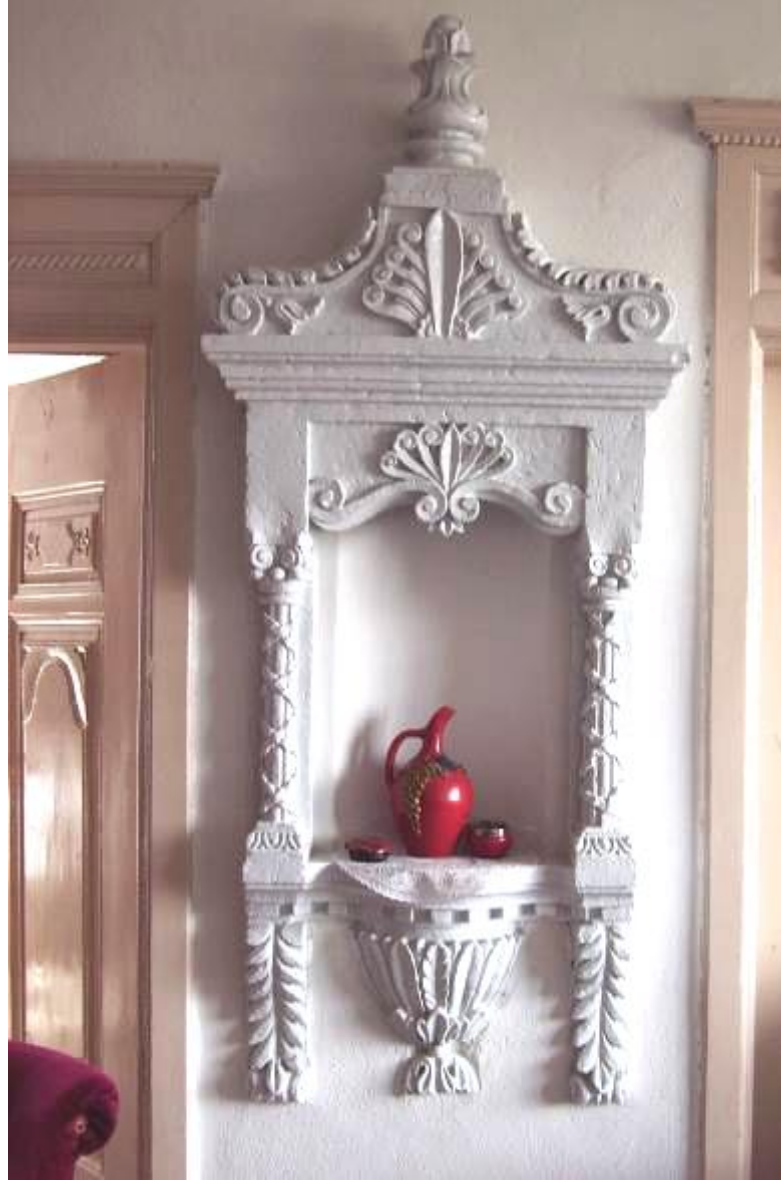
Şekil 4. 33 Kürtüncü Evi birinci kat aydınlatma nişi
