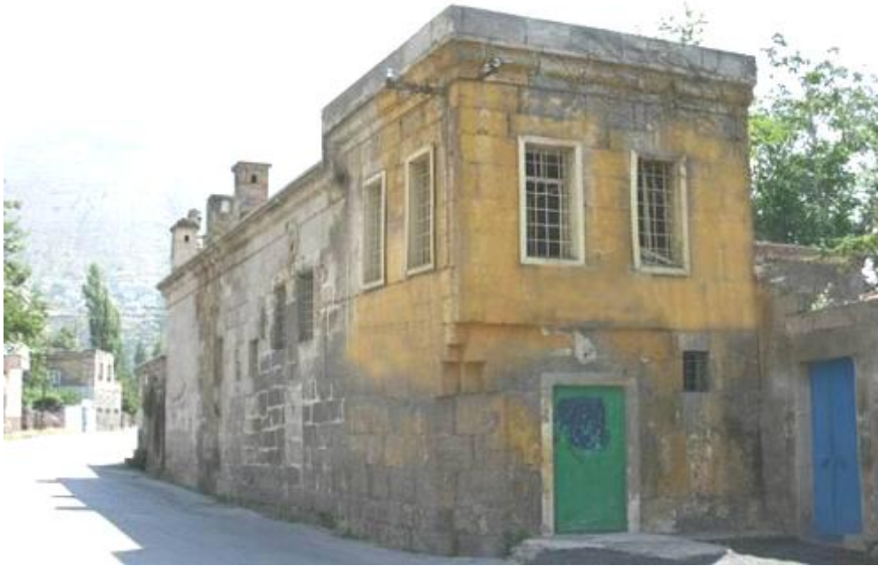
Şekil 3. 19 Talas'ta zemin kat sokak cephesi sağır geleneksel konut örneği
