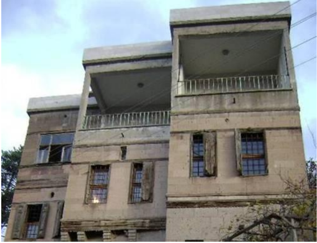
Şekil 4. 34 Kürtüncü Evi muhdes balkon ve muhdes teras çartı
