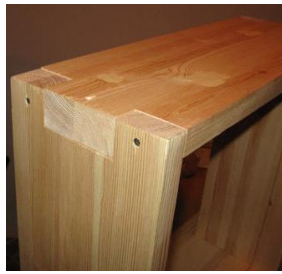
Şekil 3. 72 Pencere çerçevesinin (kör kasanın) birleşimi [215]
