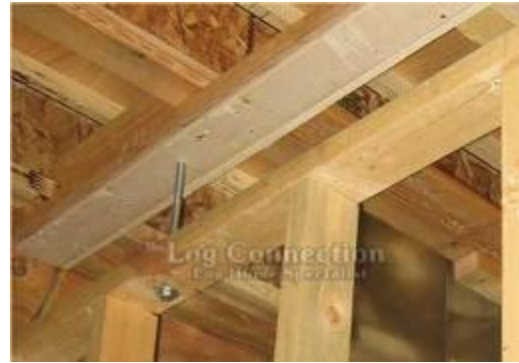
Şekil 3. 95 Çerçeve duvarla üstteki lata arasında bağlantıyı sağlayan vida [51]
