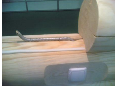
Şekil 3. 120 Esnek kablo borusunun kütük içinde açılmış delikten geçirilmesi [233]
