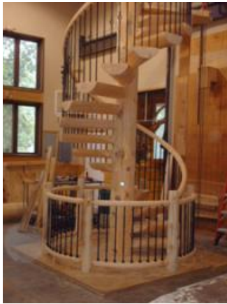
Şekil 3. 174 Basamakları yarım kütüklerden oluşan dönel merdiven resimleri [264], [265]
