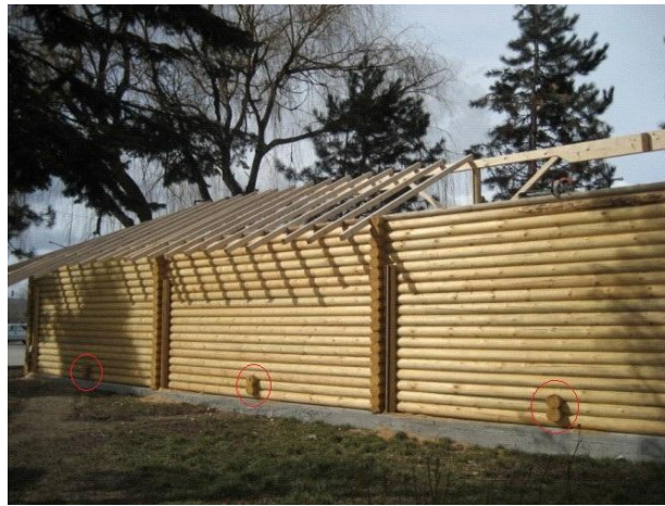
Şekil 3. 60 Kütük duvarda boy birleşiminin şasırtmalı olarak yapılması [41]
