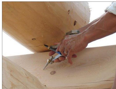
Şekil 2. 13 “Scriber” ile köşe geçmesinin belirlenmesi [48]
