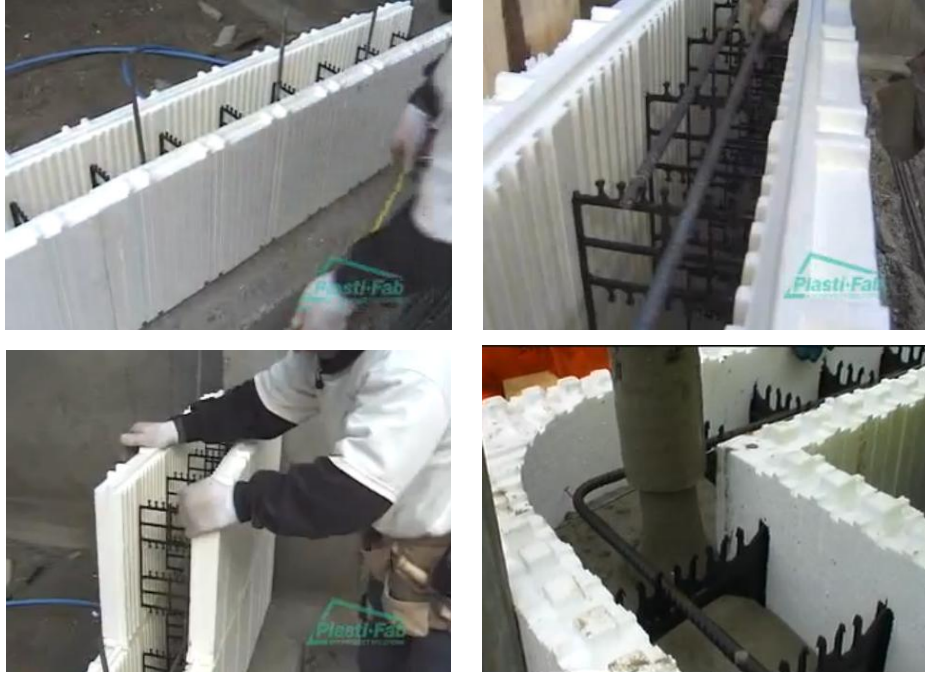
Şekil 3. 9 Yalıtımlı beton kalıpları ile duvar yapım aşamaları [138], [139]
