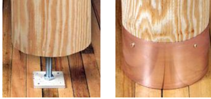
Şekil 3. 56 Dikmenin altına yerleştirilen ayar vidasının gizlenmesi [210]
