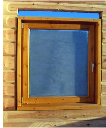
Şekil 3. 77 Pencere boşluğunda çerçeve ve buna monte edilen kasa-kanat sistemi [73]
