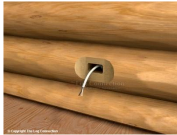
Şekil 3. 124 Priz için kütükte açılan yuva [221]
