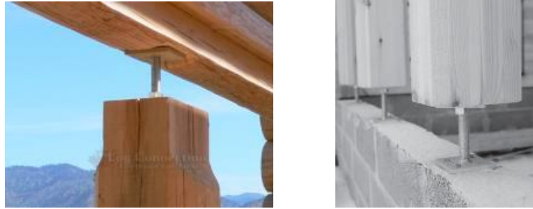
Şekil 3. 36 Dikmenin üstüne ve altına yerleştirilen ayar vidaları [193], [16]
