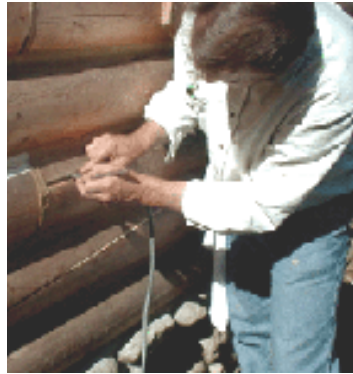
Şekil 2. 41 Kütük yüzeyindeki çatlağa dolgu fitili yerleştirilmesi [84]
