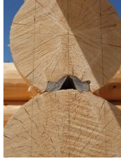
Şekil 3. 111 Kütük birleşiminde mineral yün conta kullanımı [223]
