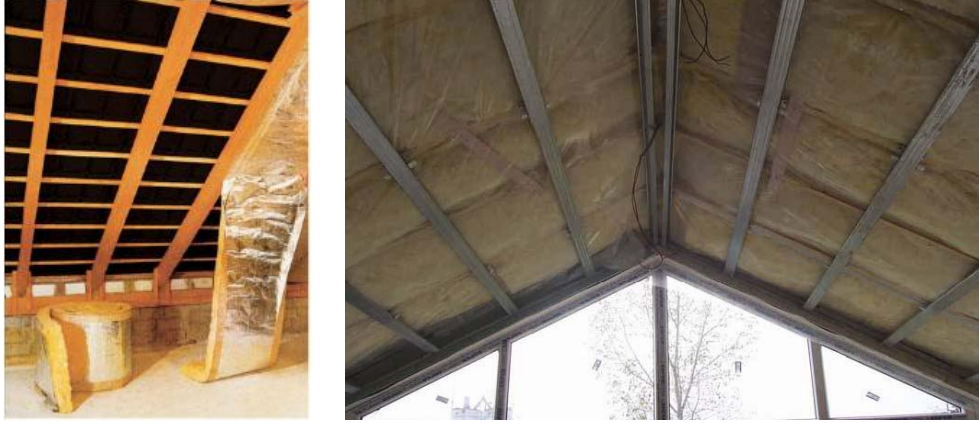
Şekil 3. 201 Isı yalıtımın mertekler arasında uygulanması [286], [128]
