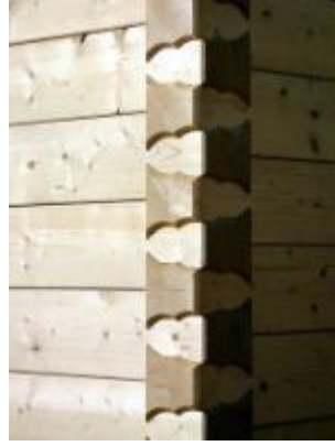
Şekil 2. 34 Estetik görünüm verilmiş bir kırlangıçkuyruğu geçme [73]
