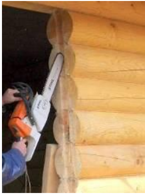
Şekil 3. 69-a Duvar boşluğunda kanal açılması [73]
