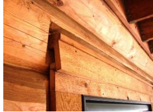
Şekil 3. 79 Pencere üzerinde oturma payı pervazı [219]
