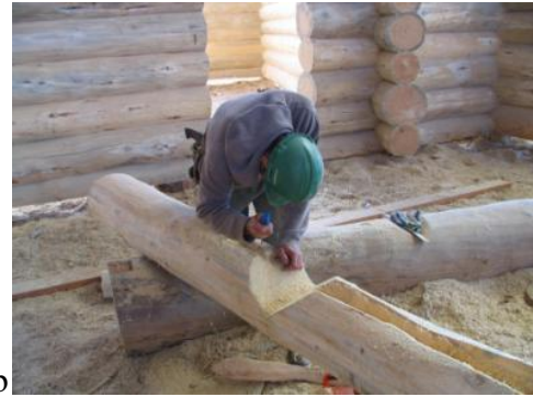
Şekil 2. 12 Geleneksel yöntemde kabukların soyulması ve boyuna kanal açılması [47]
