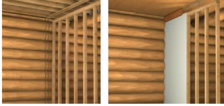
Şekil 3. 88 Kütük duvarda bölücü duvar kaplaması için açılan kanal ve kaplamanın kanala montajı [221]
