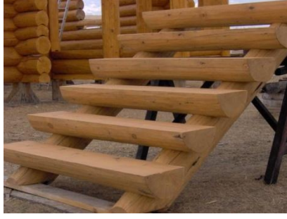
Şekil 3. 172 Yarım kütüklerden oluşan basamakların serenlerin üzerine oturduğu uygulama [262], [263]
