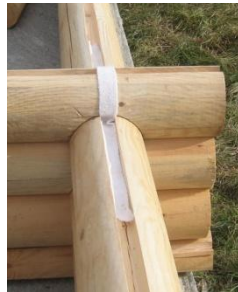
Şekil 3. 110-a Kütük birleşiminde keçe kullanılması [41]
