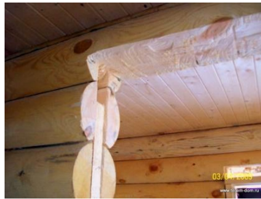
Şekil 3. 69-b Kanalda ahşap çıta uygulaması [213]
