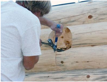
Şekil 3. 154 Duvarlardaki boşlukların inşaat sırasında açılması ve kirişin buraya oturtulması [202]
