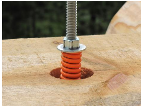
Şekil 3. 43 Duvar bağlantı bulonu üzerinde otomatik sıkıştırma sağlayan yay [202]
