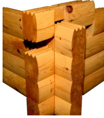
Şekil 2. 26 Kütüklerin aynı hizada olduğu geçme [64]
