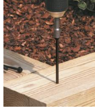
Şekil 3. 52 “Oly lag”ın matkapla yerleştirilmesi [208]
