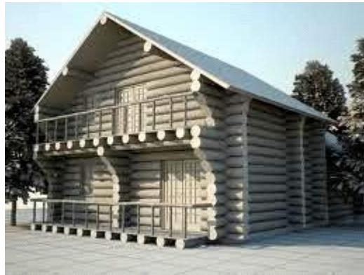
Şekil 3. 195 Çatıya ve balkona destek olan kütük uzantıları [41]
