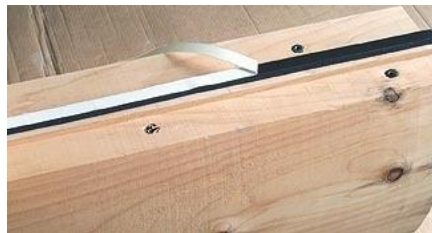
Şekil 3. 112 Bant biçimindeki contanın kütük profiline yerleştirilmesi [224]
