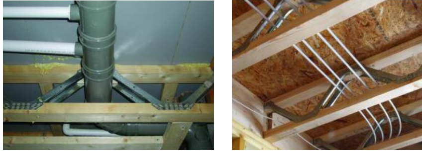
Şekil 3. 150 Makaslar arasından geçirilen tesisat döşemi [251]
