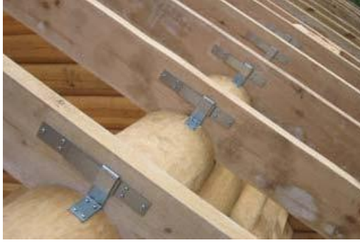
Şekil 3. 213 Merteklerle kütük duvar arasında metal kayar bağlantı elemanları kullanılması [291]
