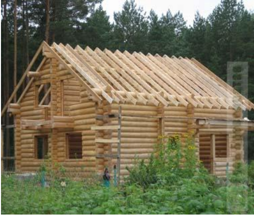
Şekil 3. 191 Aşıkların kalkan duvarlara oturtulup üstte merteklerin çakılması [279]
