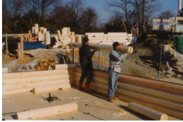
Şekil 3. 41 Kütüklerin duvar bağlantı bulonlarından geçirilmesi [201]
