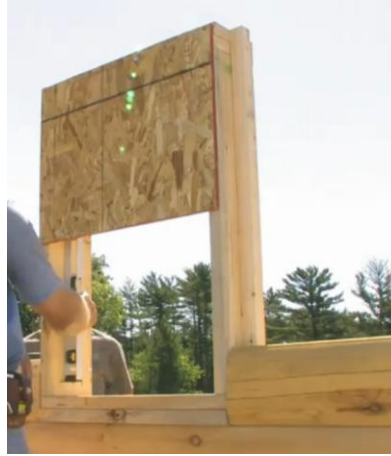
Şekil 3.73 Duvar kütüklerinden önce pencere çerçevesinin yerleştirilmesi [216]
