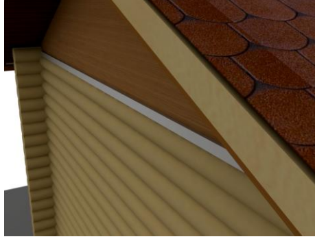
Şekil 4. 40-c Kalkan duvarın önündeki damlalık profili [41]
