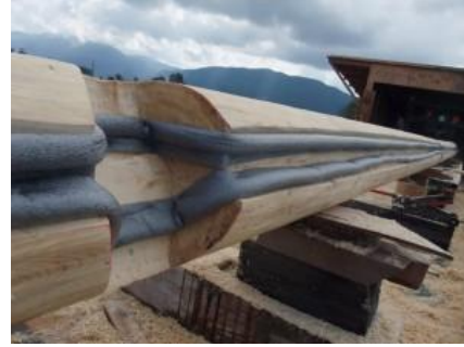
Şekil 3. 111 Kütük birleşiminde mineral yün conta kullanımı [223]
