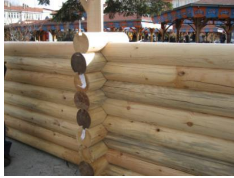
Şekil 2. 22 Kütük duvarın dik doğrultuda gelen kütüklerle boy birleşiminin yapılması [41]
