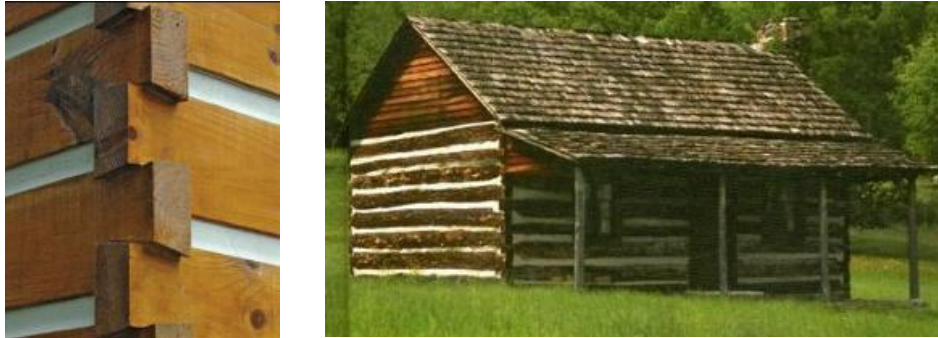
Şekil 2. 35 Kırlangıçkuyruğu geçmede kütükler arasında bırakılan boşluklar ve eski bir yapı örneği [68], [74]
