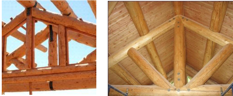
Şekil 3. 187 Metal kenetli birleştiriciler ve bulonlarla birleştirilen makas kütükleri [54], [277]
