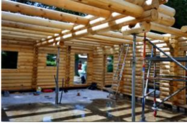
Şekil 3. 159 Üç kütükten oluşan esas kiriş ve ona ters doğrultuda yerleştirilen döşeme kirişleri [73]
