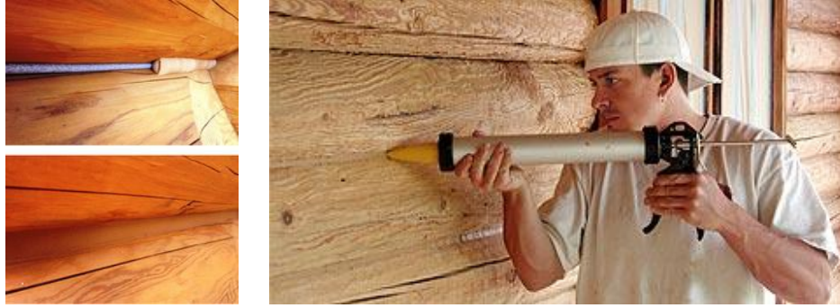
Şekil 3. 116 Kütükler arasında dolgu fitili yerleştirilip üzerinin kapatılması [229], [230]
