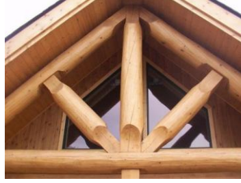
Şekil 3. 185 Biçimlendirilmiş kütük uçlarının makas oluşturacak şekilde birleşimi [275]
