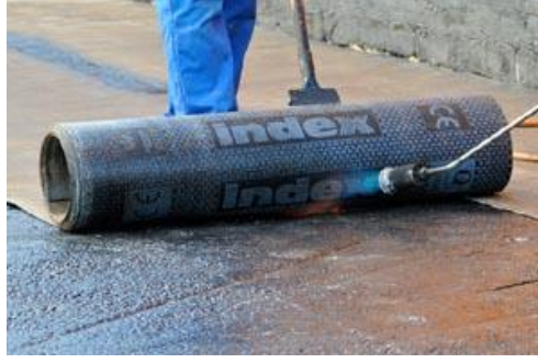
Şekil 3. 13 Membranın astara pürmüz alevi ile yapıştırılması [153]
