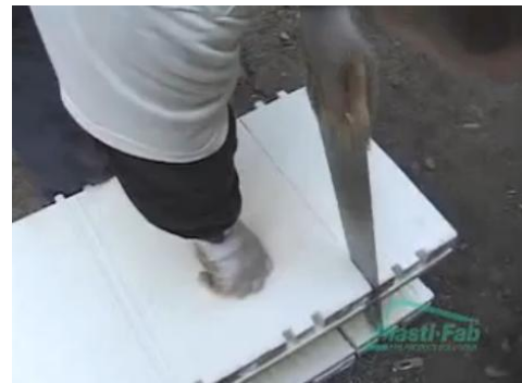
Şekil 3. 8 Kalıpların inşaat alanında kesilmesi [138]
