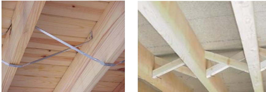
Şekil 3. 143 Döşeme kirişleri arasında çelik ve ahşap kuşaklamanın kullanılması [244], [245]
