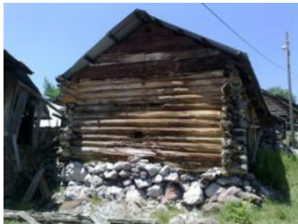
Bolu İli Kırıbrıcık İlçesi’ne bağlı Karacaören Köyü’nde bir çantı yapı
