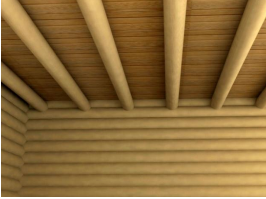
Şekil 4. 34 Kütük kirişlerin ve lambriilerin alt mekândan görünümü [41]
