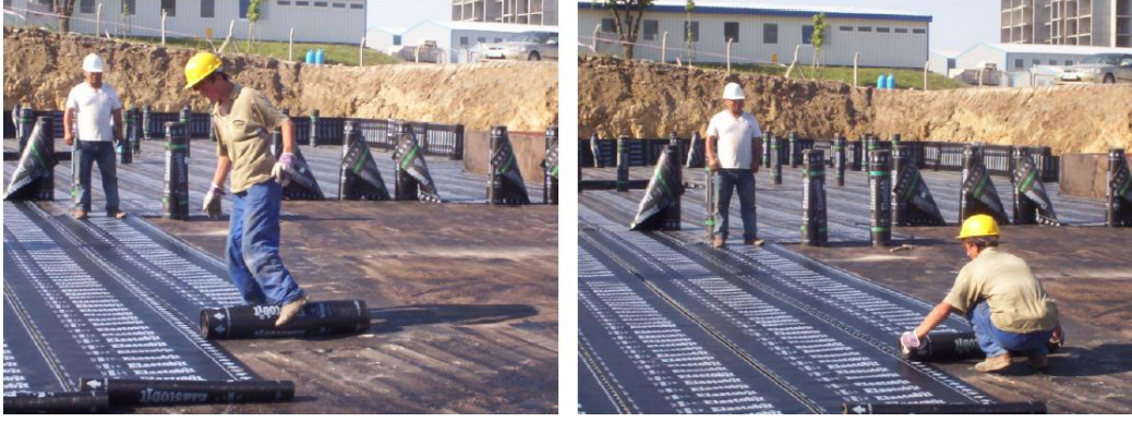
Şekil 3. 11 Bohçalamanın ilk aşamasında temel altına su yalıtım örtüsü serilmesi [145]
