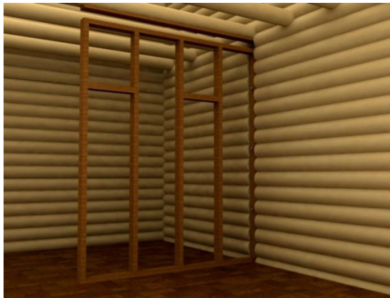
Şekil 4. 26 Kütük duvarda açılan kanala duvar çerçevesinin geçirilmesi [41]
