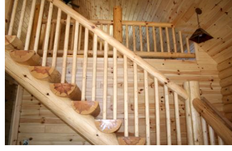
Şekil 3. 172 Yarım kütüklerden oluşan basamakların serenlerin üzerine oturduğu uygulama [262], [263]
