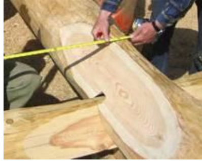
Şekil 2. 29 Semer geçmede kütükler arasında bırakılan oturma payı [69]
