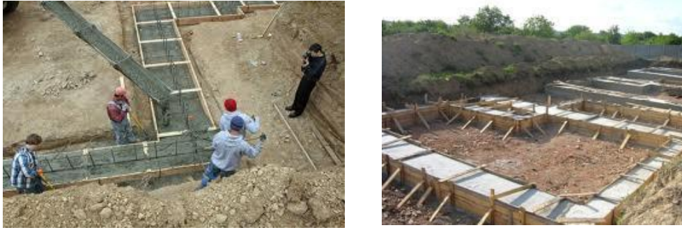
Şekil 3. 3 Yerinde dökme betonarme temel uygulaması [130], [129]
