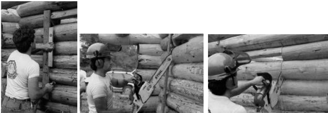
Şekil 3. 64 Geleneksel yöntemle pencere boşluğunun oluşturulması [212]
