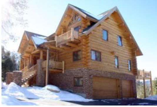
Şekil 3. 153 Balkonu taşıyan konsol döşeme kirişleri [254]
