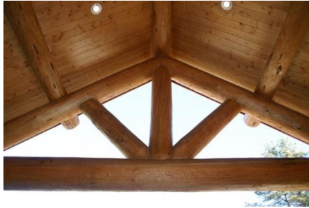
Şekil 3. 189 Kütük makas ve aşıklardan oluşan çatı elemanları [254]
