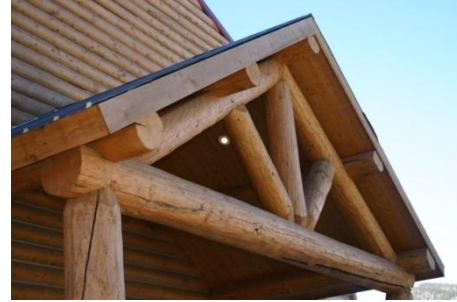
Şekil 3. 189 Kütük makas ve aşıklardan oluşan çatı elemanları [254]
