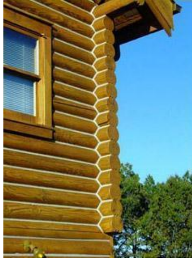
Şekil 2. 39 Araları sıvanmış kütüklerden oluşan bir duvar [82]
