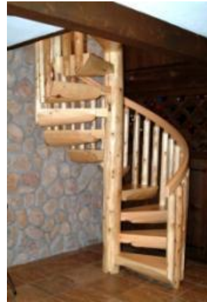
Şekil 3. 174 Basamakları yarım kütüklerden oluşan dönel merdiven resimleri [264], [265]
