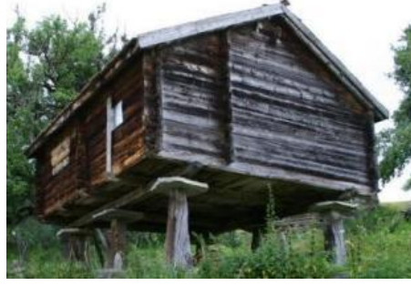
Şekil 2. 7 Sinop – Erfelek Himmetoğlu Köyü’nde ahşap ayaklar üzerinde yükseltilmiş bir kütük yapı (Serander) [40]
