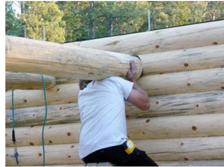
Şekil 3. 154 Duvarlardaki boşlukların inşaat sırasında açılması ve kirişin buraya oturtulması [202]
