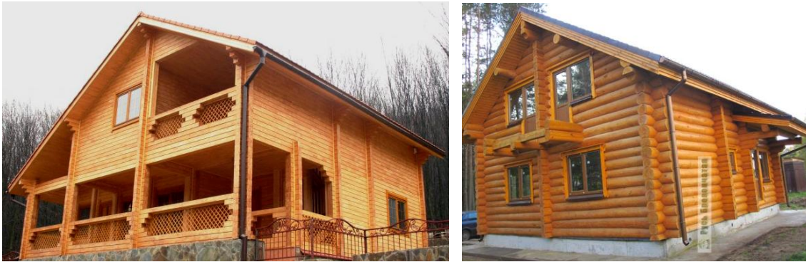
Şekil 3. 194 Çatıya destek olan kütük uzantıları [280], [279]
