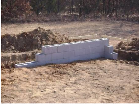
Şekil 3. 4 Hazır blok betonlarla örülen temel duvarı [131]
