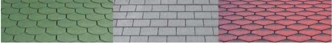
Şekil 3. 225 Farklı renk ve modellerde “shingle” kaplamalar [299]
