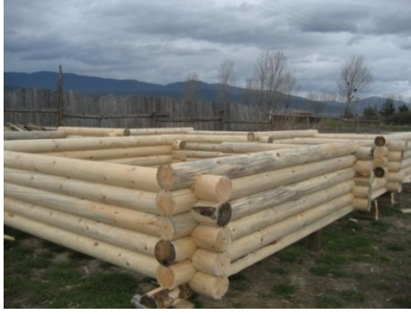
Şekil 4. 5 Kütüklerin bağlantı ürünü, conta vs. kullanılmadan bir araya getirilmesi [41]
