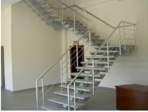
Şekil 3. 166 Metal basamaklardan oluşan çelik merdiven [257]
