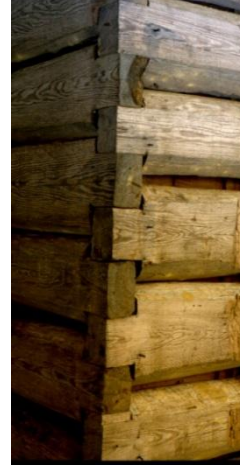
Şekil 2. 36 Üçlü köşe geçmesi [63], [75]
