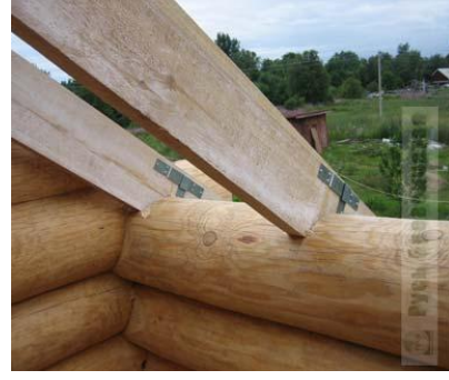
Şekil 3. 213 Merteklerle kütük duvar arasında metal kayar bağlantı elemanları kullanılması [291]
