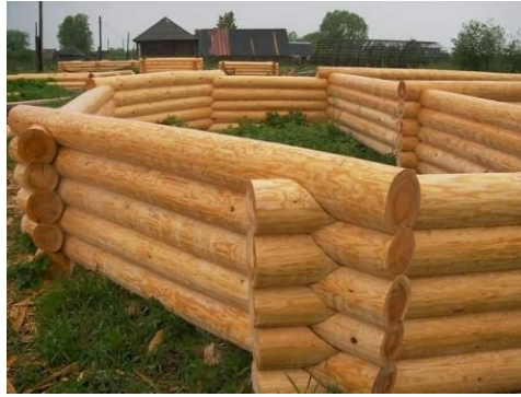
Şekil 4. 4 Geniş açılı olarak kesiştirilen duvarlar [308]
