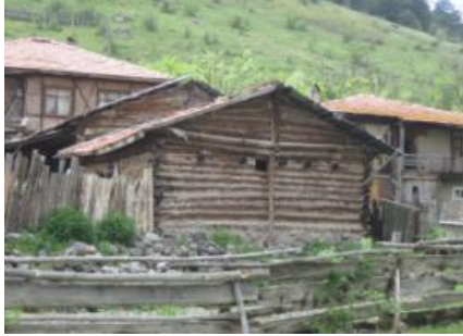
Bolu’nun Tekkedere Köyü’nde ahır olarak kullanılan bir çantı yapı
