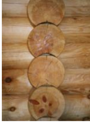
Şekil 3. 29 Basit çentikli geçme [73]
