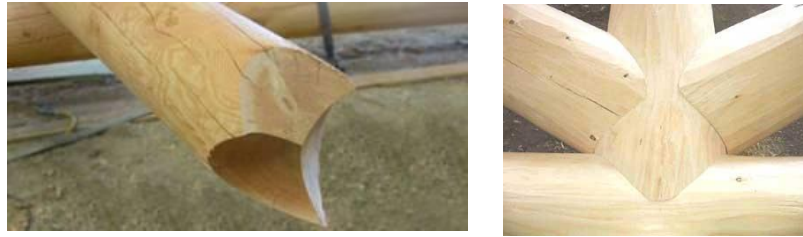
Şekil 3. 186 Biçimlendirilmiş kütük uçlarının birleşimi [273], [276]
