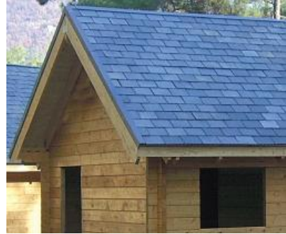
Şekil 3. 228 Arduvaz çatı kaplaması [303]
