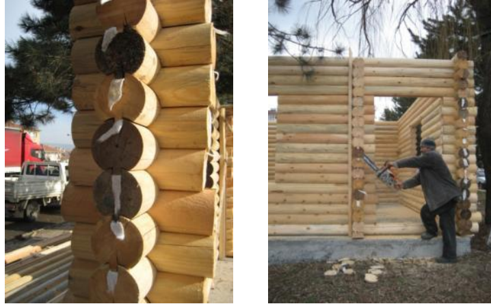
Şekil 2. 53 Depolanma sırasında mavi leke oluşan kütük uçlarının inşaat sırasında kesilmesi [41]
