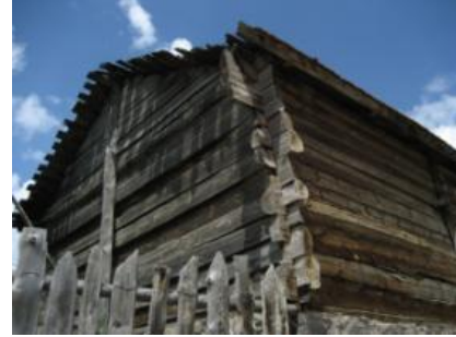
Bolu’nun Tekkedere Köyü’nde yarım kütüklerle oluşturulmuş bir çantı yapı
