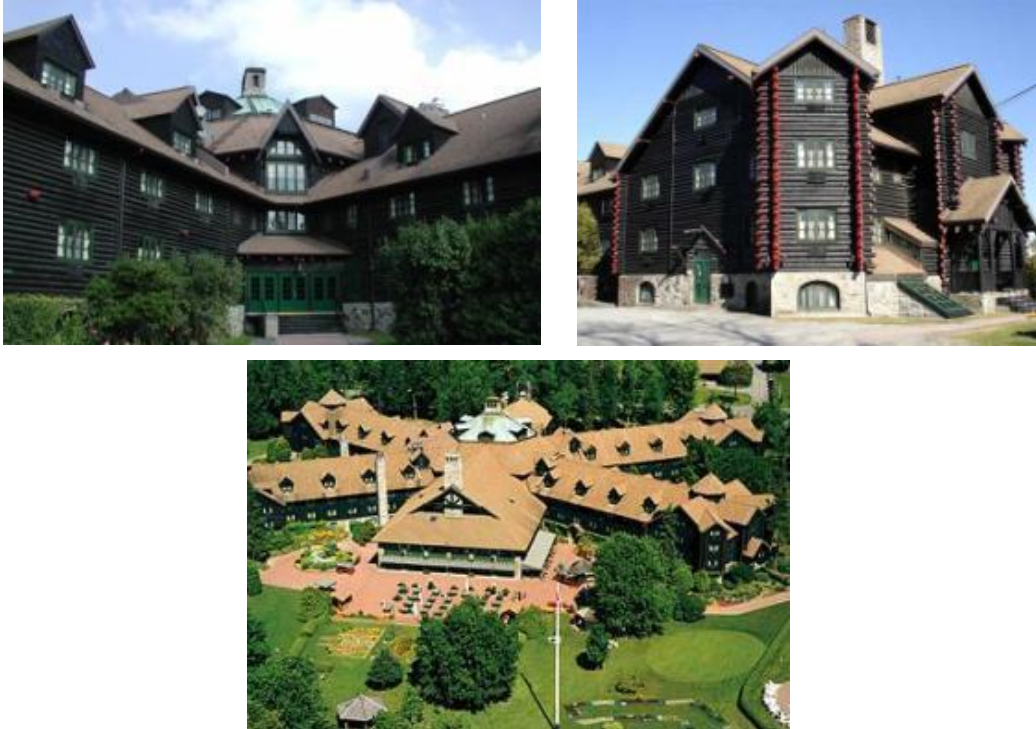
Şekil 2. 10 Dünyanın en büyük kütük yapılarından “Log Château” [42], [43], [44]
