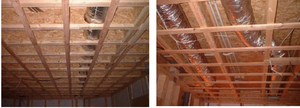
Şekil 3. 164 Döşeme kirişlerinden geçirilen servis elemanları [128]
