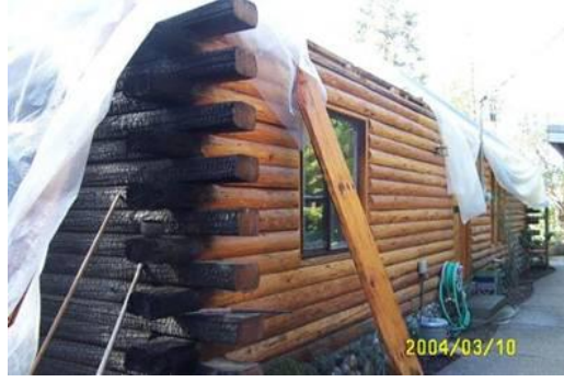
Şekil 2. 47 Yanmış bir kütük duvar [54]
