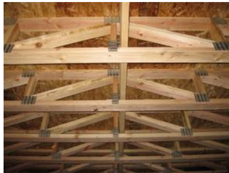
Şekil 3. 148 Ahşap makas döşeme kirişleri [249]
