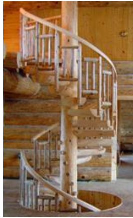
Şekil 3. 174 Basamakları yarım kütüklerden oluşan dönel merdiven resimleri [264], [265]
