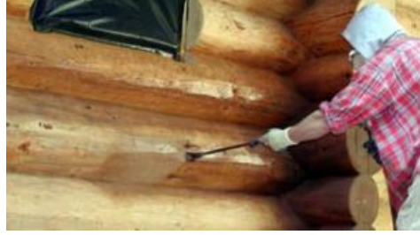
Şekil 2. 63 UV ışınlarının vereceği zararı azaltmak için püskürtülerek uygulanan yüzey koruyucu [124]
