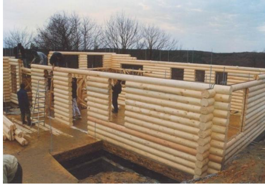
Şekil 3. 65 Modern yöntemle inşa edilen yapıda kapı ve pencere boşlukları [201]
