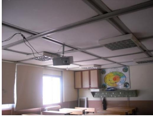
Şekil 4. 18 Sakarya’da depremden sonra yonga levha panel sistemle oluşturulan geçici ilköğretim birimine ait asma tavan uygulaması [114]
