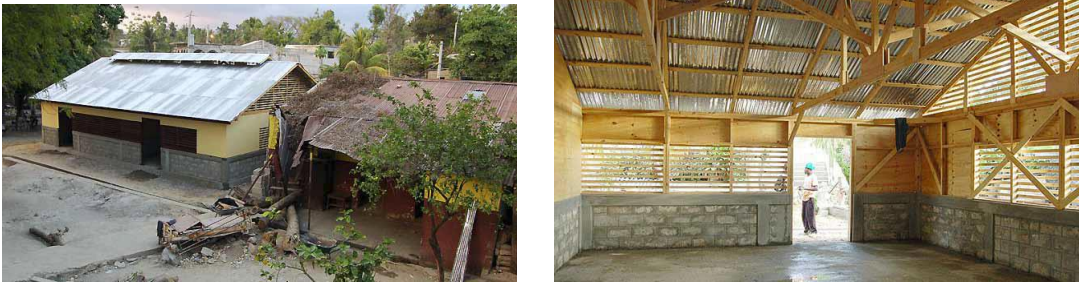
Şekil 3. 58 Jacmel’de uygulanan geçici ilköğretim birimleri ve birimlerin iç mekanın (sağda) doğal aydınlatma ile aydınlatılması [76]
