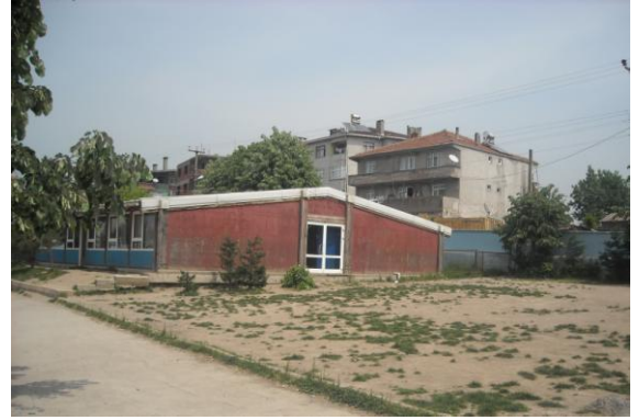
Şekil 5. 45 Ferizli Şehit Hacı Uzun İlköğretim Okulu bahçesinde depremde sonra kurulan ve günümüzde depo amaçlı olarak kullanılan sökülüp taşınabilir tabakalı ahşap geçici ilköğretim yapısı [114]
