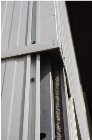
Şekil 4. 29 Günümüzde kullanımda olan çelik taşıyıcı panel sistem okul birimlerinin dış duvar elemanları [114]
