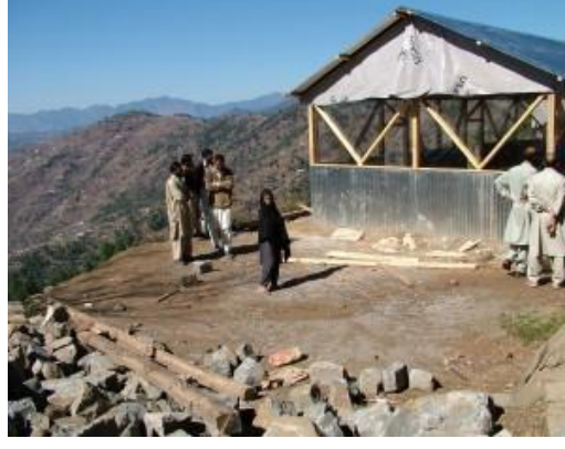
Şekil 3. 11 Ahşap dikme ve dikmelerin ahşap çapraz elemanlarla desteklendiği sistemle oluşturulmuş geçici ilköğretim birimi [81]
