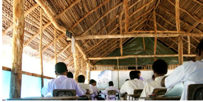
Şekil 3. 6 Deprem sonrası afet bölgesinde kurulmuş bambu geçici okul birimi [74]
