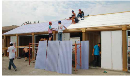
Şekil 3. 25 Kağıt tüp geçici eğitim birimlerinin çatı kaplamasının montajında öğrencilerin katılımı [92]
