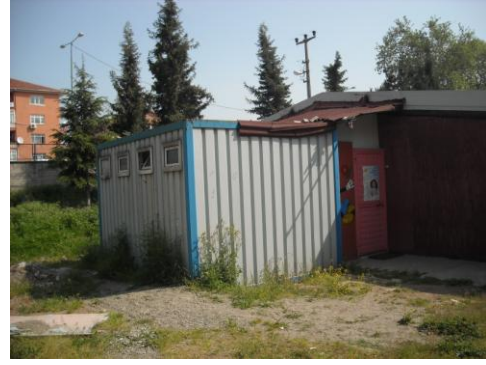
Şekil 5. 43 Kocaeli, Değirmendere Şehit Cengiz Topel İlköğretim Okulu bahçesindeki tabakalı ahşap geçici ilköğretim yapısına zamanla eklenen Wc konteyner birimi [114].
