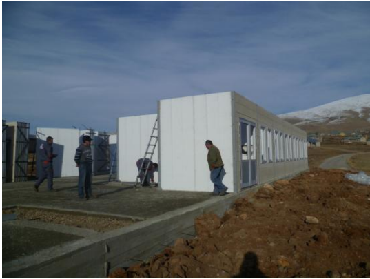
Şekil 4. 38 Van, Erciş'te depremden sonra oluşturulan çelik taşıyıcı sistem ilköğretim birimlerine ait yapı elemanlarının üretim ve montaj aşamaları [140]
