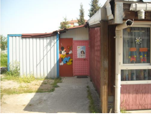
Şekil 5. 43 Kocaeli, Değirmendere Şehit Cengiz Topel İlköğretim Okulu bahçesindeki tabakalı ahşap geçici ilköğretim yapısına zamanla eklenen Wc konteyner birimi [114].
