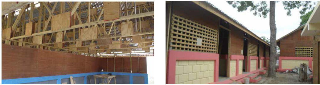
Şekil 3. 59 Port au Prince’de kurulan geçici eğitim yapılarındaki derslikleri ayıran bölücü duvarlar ve yığma / ahşap karma dış duvar uygulamasına ait görünüm [76]
