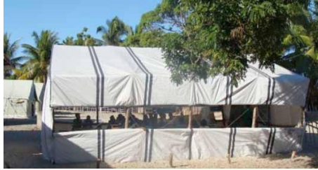
Şekil 5. 7 Madagaskar’da kasırğa sonrası hakim rüzgar yönüne göre konumlandırılmış çadır geçici eğitim birimleri [76]
