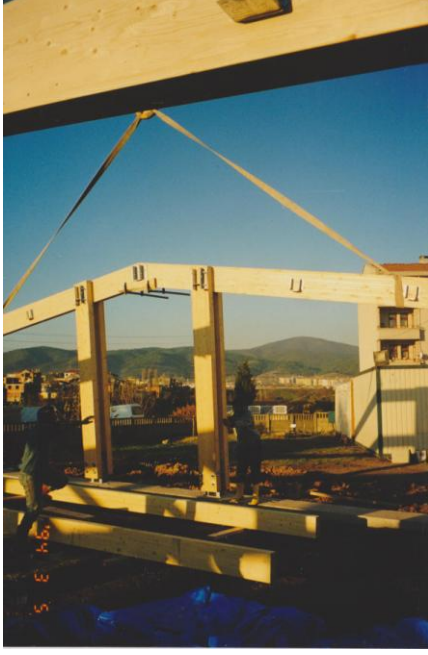
Şekil 5. 41 Tabakalı tutkallı ahşap çatı kirişlerinin vinç yardımıyla kaldırılarak lamine ahşap kolonlar üzerine oturtulması [160]
