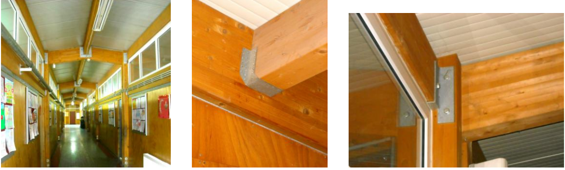
Şekil 5. 19 1999 Marmara Depremleri sonrasında taşıyıcı sistem elemanlarının birleşim noktalarının görünebilir ve kullanıcılar tarafından açıkça izlenebilir olduğu geçici eğitim birimleri [114]
