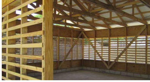
Şekil 5. 18 2010 Haiti Depremi sonrasında yerel malzemelerle kısa sürede yapımı gerçekleştirilen ahşap iskelet sistemli geçici eğitim yapısı [157]
