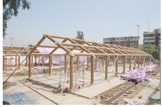
Şekil 3. 23 Kağıt tüp geçici eğitim birimlerinin taşıyıcı sistem elemanlarının birleştirilmesine ve iskelet sistemin oluşturulmasına ilişkin görseller [90]
