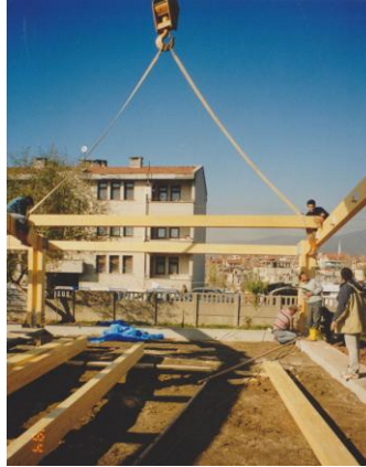
Şekil 5. 40 Tabakalı tutkallı ahşap çatı merteklerinin lamine ahşap aşık elemanlarına sabitlenmesi [160]
