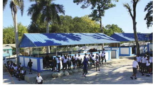
Şekil 5. 21 Haiti depreminden sonra oluşturulan çadır ve çelik-betonarme karma taşıyıcılı geçici eğitim birimleri [76]
