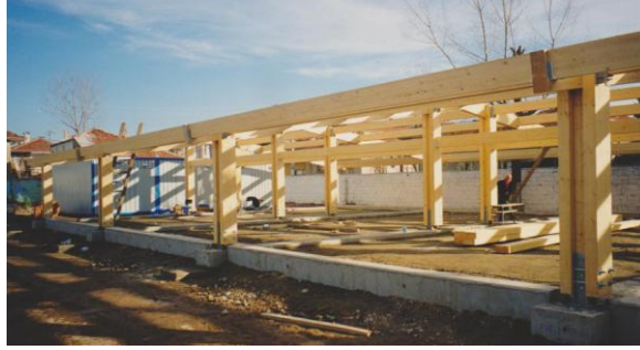
řekil 5. 16 1999 Marmara Depremleri sonrasında tabakalı tutkallı ahřap teknolojiyle oluřturulan “sökölüp-takılabilen” geęici eęitim yapısı [160]
