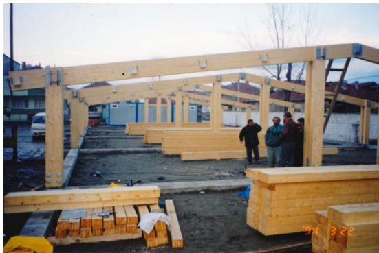
Şekil 5. 38 Ön yapım tabakalı tutkallı ahşap taşıyıcı elemanların şantiye organizasyonu neticesinde montaj zamanı gelinceye kadar belirli alanlarda üst üste dizilerek bekletilmesi ve montajının gerçekleştirilmesi [160]
