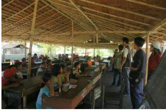
Şekil 3. 5 Sirombu'da deprem sonrası kurulmuş bambu geçici okul birimi [75]
