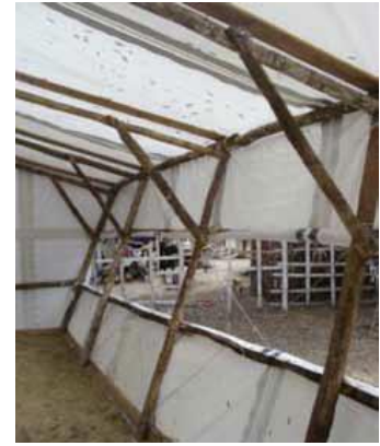
Şekil 5. 14 Madagaskar'da afet sonrası hasarlı okul yapılarındaki zemin kaplamasının onarılarak yeniden kullanıldığı geçici eğitim birimleri [151]
