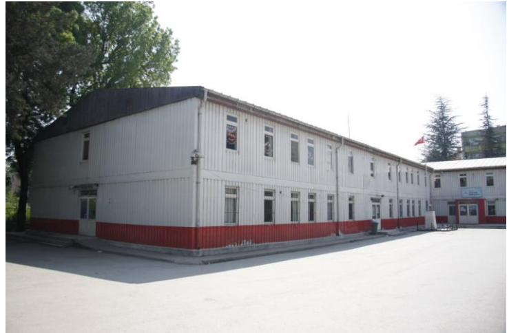
Şekil 4. 27 Düzce’de depremden sonra kurulan ve halen kullanımda olan çelik taşıyıcı panel sistem geçici ilköğretim birimleri [114]
