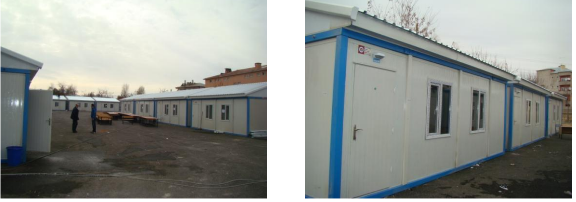
Şekil 3. 40 Van'da depremden sonra kurulan sandviç panel sistem geçici ilköğretim birimleri [142]
