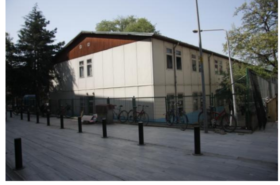
Şekil 4. 28 Düzce’de depremde sonra kurulan ve halen kullanımda olan çelik taşıyıcı panel sistem geçici ilköğretim birimleri [114]
