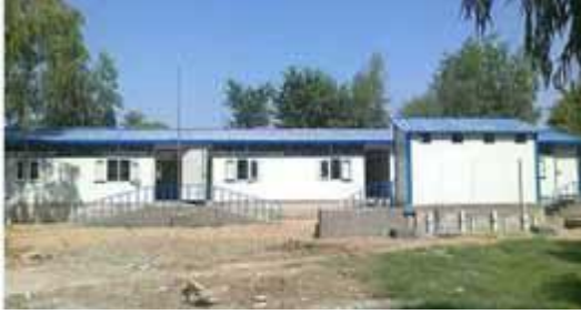
řekil 5. 17 2010 Pakistan’da afet sonrası ęelik tařıyıcı sistemli “sökölüp-takılabilen” geęici eęitim yapısı [157]
