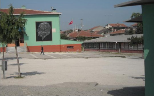
Şekil 5. 44 Kocaeli, Değirmendere Şehit Cengiz Topel İlköğretim Okulu bahçesindeki günümüzde halen kullanımda olan sökülüp taşınabilir tabakalı ahşap geçici ilköğretim yapısı [114]
