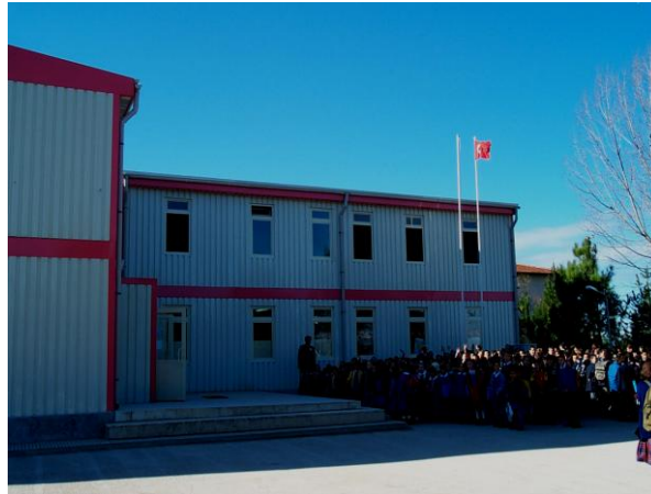
Şekil 4. 33 Yalova’da çelik konstrüksiyonlu sandviç panel birimlerde eğitim [134]
