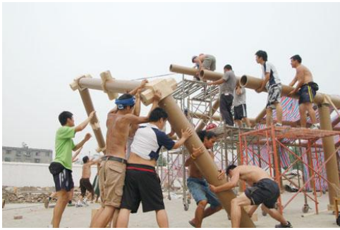
Şekil 3. 24 Kağıt tüp geçici eğitim birimlerinin taşıyıcı sistem elemanlarının birleştirilmesi çalışmalarında öğrencilerin katılımı [90, 91]
