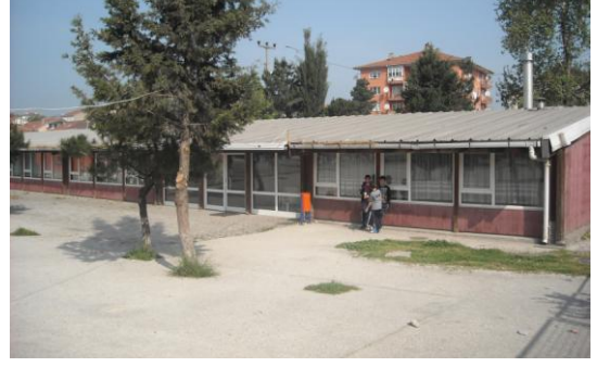
Şekil 5. 44 Kocaeli, Değirmendere Şehit Cengiz Topel İlköğretim Okulu bahçesindeki günümüzde halen kullanımda olan sökülüp taşınabilir tabakalı ahşap geçici ilköğretim yapısı [114]
