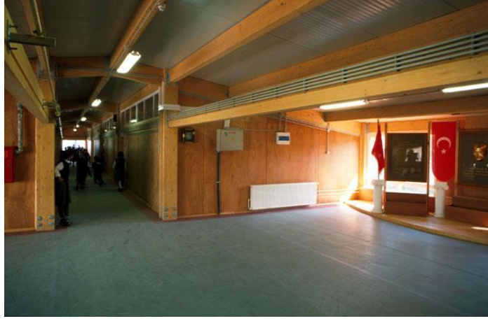
Şekil 5. 30 Holün zemininde üzerine PVC kaplanmış, sökülüp kaldırılabilir ve yeniden kullanılabilir panolaştırılmış kontrplak kullanımı [160]
