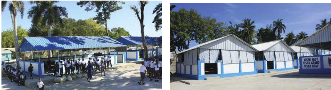
Şekil 3. 43 Haiti'deki çelik ve betonarme karma taşıyıcılı geçici eğitim birimlerinin görünüşleri [76]
