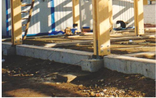
Şekil 5. 34 Sökülüp kaldırılabilen ön yapım betonarme temel kirişleri ve prefabrik temellerin üzerine monte edilmiş sökülüp taşınabilir lamine ahşap taşıyıcı elemanlar
