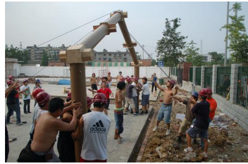
Şekil 3. 24 Kağıt tüp geçici eğitim birimlerinin taşıyıcı sistem elemanlarının birleştirilmesi çalışmalarında öğrencilerin katılımı [90, 91]
