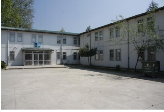
Şekil 4. 28 Düzce’de depremde sonra kurulan ve halen kullanımda olan çelik taşıyıcı panel sistem geçici ilköğretim birimleri [114]
