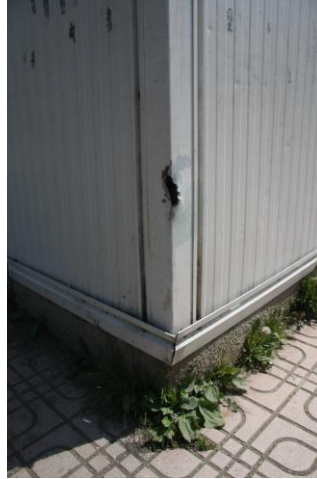
Şekil 4. 29 Günümüzde kullanımda olan çelik taşıyıcı panel sistem okul birimlerinin dış duvar elemanları [114]
