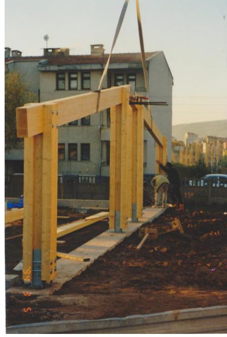
Şekil 5. 41 Tabakalı tutkallı ahşap çatı kirişlerinin vinç yardımıyla kaldırılarak lamine ahşap kolonlar üzerine oturtulması [160]
