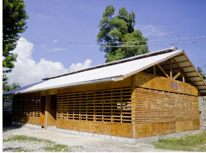
Şekil 3. 47 Haiti-Jacmel’de deprem sonrası oluşturulan ahşap konstrüksiyonlu geçici eğitim yapısı [101]
