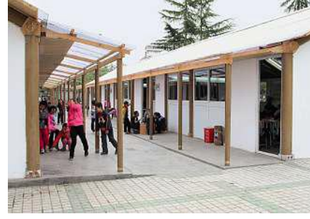
Şekil 3. 19 Çin’de 2008 yılında meydana gelen depremden sonra Sichuan Eyaleti’nde oluşturulan “Kağıt Tüp Geçici Eğitim Yapıları” [89]
