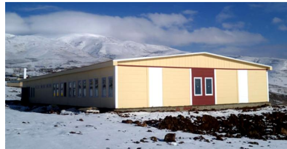
Şekil 4. 39 Van, Erciş'te depremden sonra oluşturulan çelik taşıyıcı sistem ilköğretim birimleri [141]
