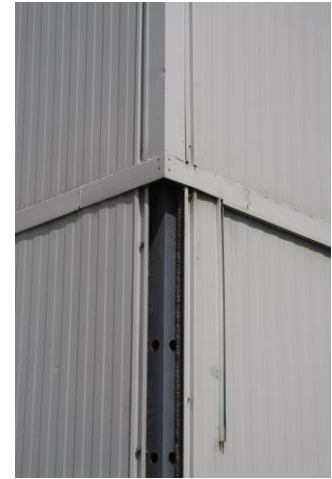
Şekil 4. 29 Günümüzde kullanımda olan çelik taşıyıcı panel sistem okul birimlerinin dış duvar elemanları [114]
