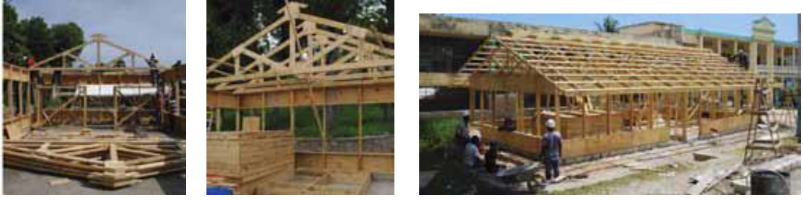
Şekil 3. 49 Geçici eğitim birimlerinin ahşap iskelet sistemi ve kontrplak duvar elemanları oluşturulduktan sonra ahşap çatı konstrüksiyonunun gerçekleştirilmesi [76]
