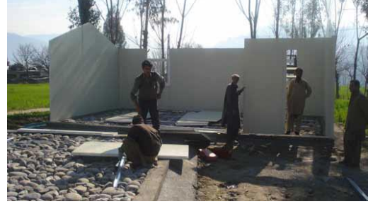
řekil 5. 17 2010 Pakistan’da afet sonrası ęelik tařıyıcı sistemli “sökölüp-takılabilen” geęici eęitim yapısı [157]
