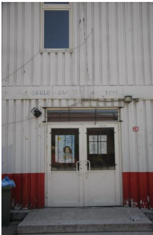
Şekil 4. 27 Düzce’de depremden sonra kurulan ve halen kullanımda olan çelik taşıyıcı panel sistem geçici ilköğretim birimleri [114]
