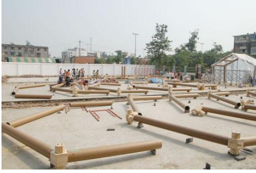
Şekil 3. 23 Kağıt tüp geçici eğitim birimlerinin taşıyıcı sistem elemanlarının birleştirilmesine ve iskelet sistemin oluşturulmasına ilişkin görseller [90]
