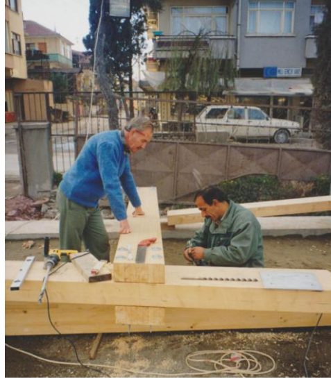
Şekil 5. 32 Tabakalı tutkallı ahşap kolonların çelik bağlantılarının yapılması [160].
