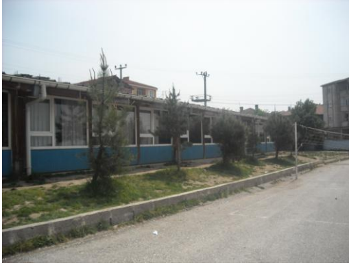
Şekil 5. 45 Ferizli Şehit Hacı Uzun İlköğretim Okulu bahçesinde depremde sonra kurulan ve günümüzde depo amaçlı olarak kullanılan sökülüp taşınabilir tabakalı ahşap geçici ilköğretim yapısı [114]
