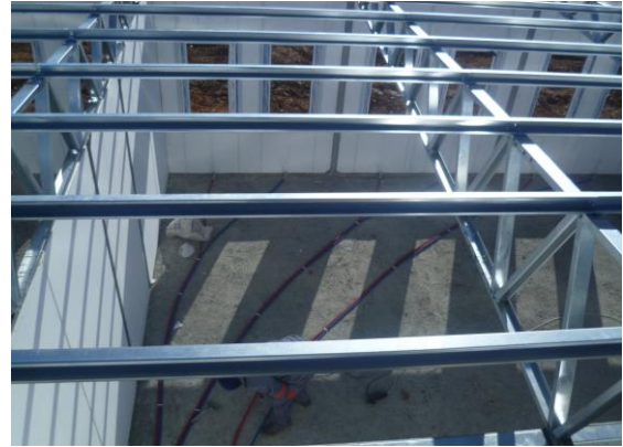
Şekil 4. 38 Van, Erciş'te depremden sonra oluşturulan çelik taşıyıcı sistem ilköğretim birimlerine ait yapı elemanlarının üretim ve montaj aşamaları [140]
