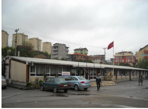
Şekil 4. 10 Kocaeli Yarbay Refik Cesur İlköğretim Okulu'nun bahçesinde halen kullanımda olan afet sonrası ahşap geçici ilköğretim birimi [114]
