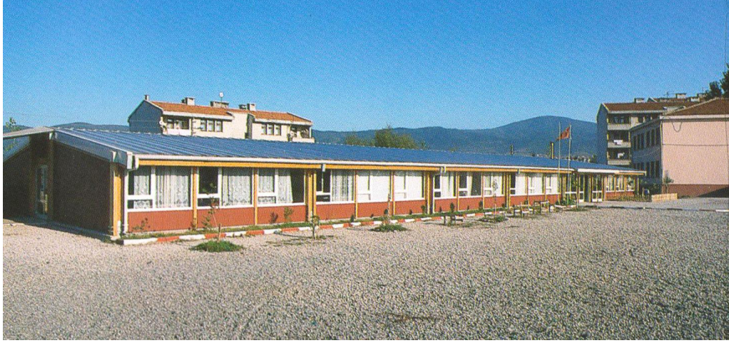
Şekil 5. 23 1999 Marmara Depremleri sonrasında oluşturulmuş sökülüp taşınabilir geçici ilköğretim yapısı [116]
