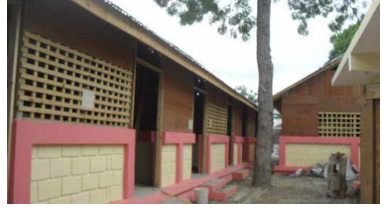
Şekil 5. 3 Haiti’de depremden sonra kurulan geçici eğitim birimlerinin cephelerinde doğal aydınlatmanın kontrollü bir şekilde iç mekana geçişini sağlayan ahşap gölgelik elemanlar [76]
