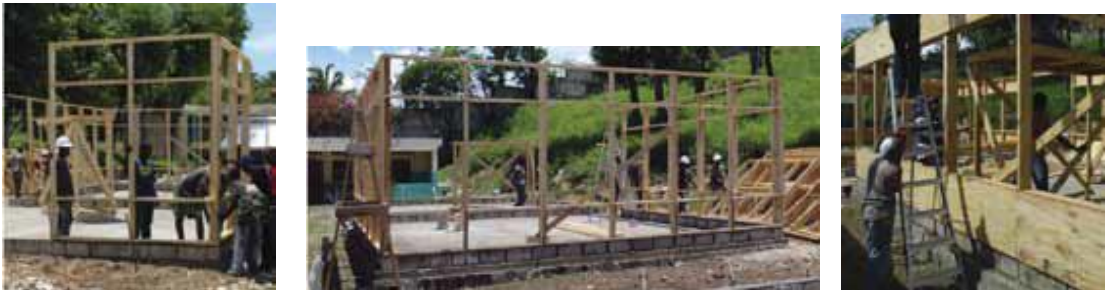
Şekil 3. 48 Geçici eğitim birimlerinin ahşap iskelet sisteminin oluşturulması ve bu sisteme dış ortam koşullarına dayanıklı kontrplak duvar elemanlarının monte edilmesi [76]
