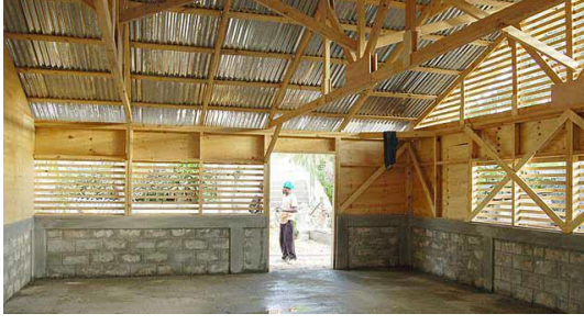
Şekil 5. 3 Haiti’de depremden sonra kurulan geçici eğitim birimlerinin cephelerinde doğal aydınlatmanın kontrollü bir şekilde iç mekana geçişini sağlayan ahşap gölgelik elemanlar [76]
