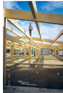
Şekil 5. 38 Ön yapım tabakalı tutkallı ahşap taşıyıcı elemanların şantiye organizasyonu neticesinde montaj zamanı gelinceye kadar belirli alanlarda üst üste dizilerek bekletilmesi ve montajının gerçekleştirilmesi [160]
