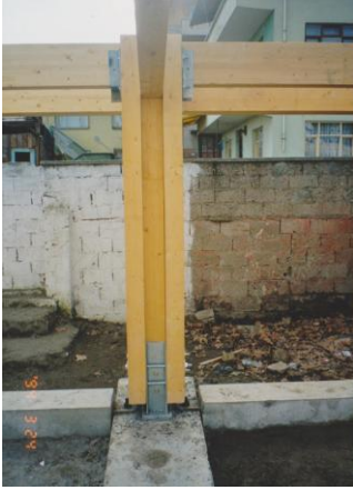
Şekil 5. 34 Sökülüp kaldırılabilen ön yapım betonarme temel kirişleri ve prefabrik temellerin üzerine monte edilmiş sökülüp taşınabilir lamine ahşap taşıyıcı elemanlar
