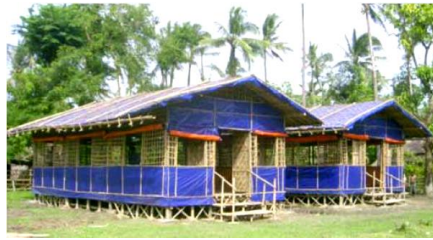
Şekil 5. 6 Myanmar’da kasırga sonrası hakim rüzgar yönüne göre konumlandırılmış geçici eğitim yapıları [76]
