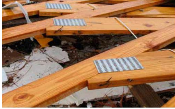
Şekil 4.81 Doğru bağlantı uygulaması [60]
