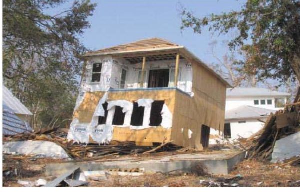
Şekil 4.46 Ahşap yapının temelden ayrılması [61]
