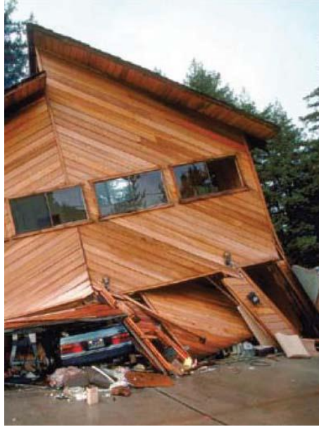
Şekil 4.9 Ahşap yapılarda oluşan devrilme etkisi [53]
