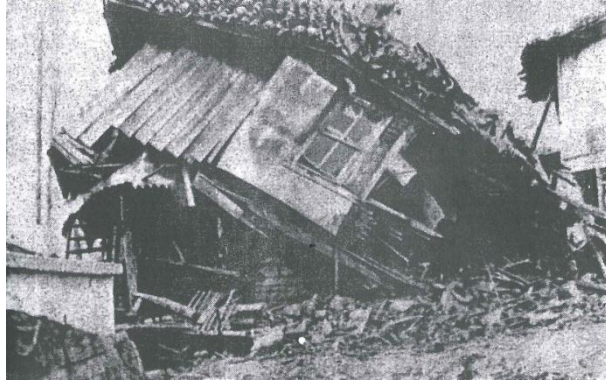
Şekil 4.17 Ahşap yapının temelden ayrılarak devrilmesi [41]
