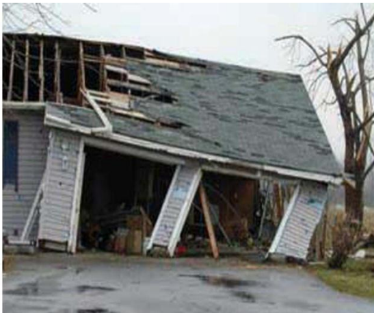
Şekil 4.42 Ahşap yapıların bir bütün halinde devrilmesi [51]
