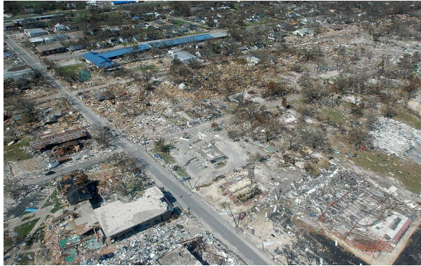
Şekil 4.37 Katrina kasırgası'nın ahşap yapılara etkisi [46]
