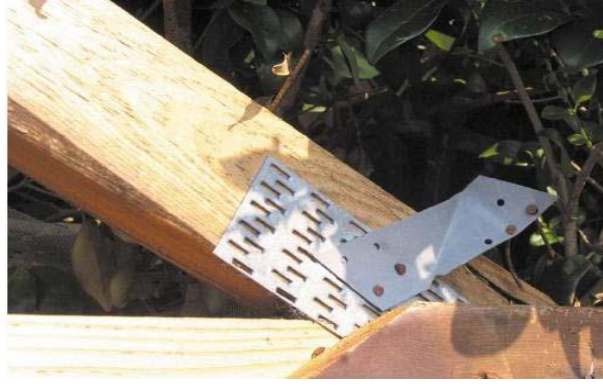
Şekil 4.68Çatı makaslarındaki bağlantı [61]
