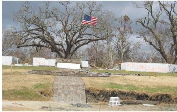
Şekil 4.48 Rüzgâr kuvvetlerinin ahşap yapıyı uçurması [61]
