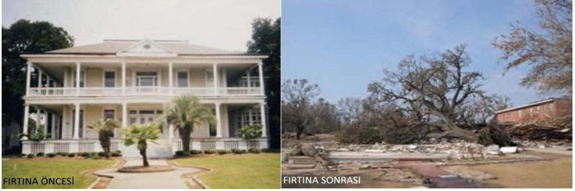
Şekil 4.43 Rüzgâr kuvvetlerinin ahşap yapılara etkisi [57]
