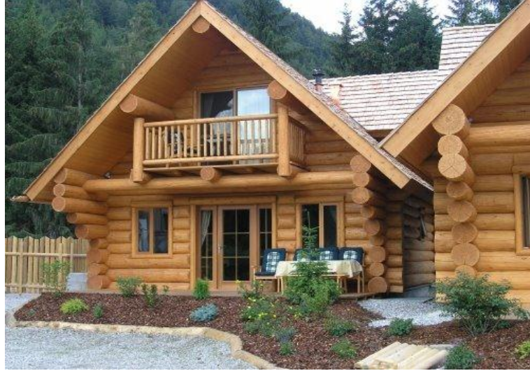
Şekil 2.14 Kütük yığma çatı örneği [24]
