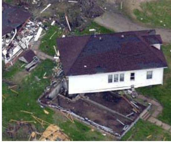
Şekil 4.41 Ahşap yapılarda oluşan kayma etkisi [51]
