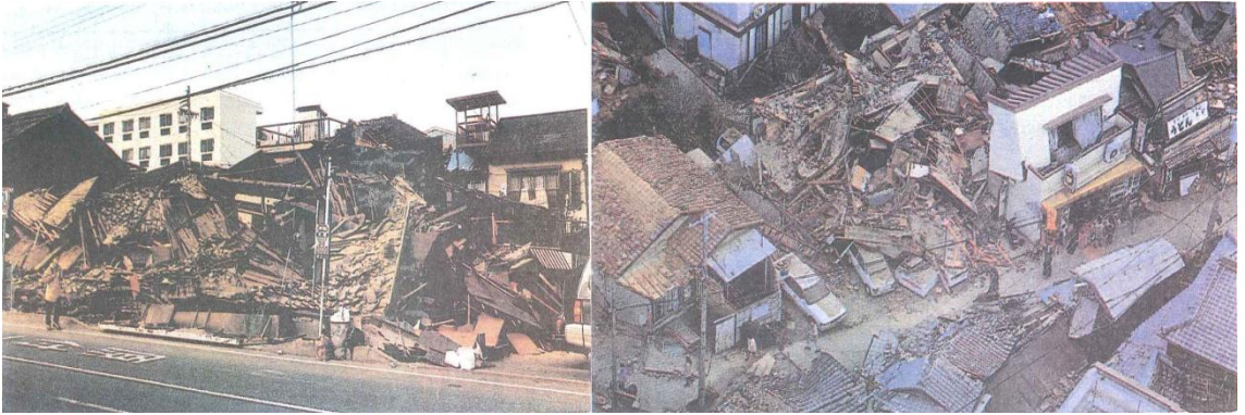
Şekil 4.1 Kobe depremi sonrası ahşap yapılarda görülen hasarlar [45]
