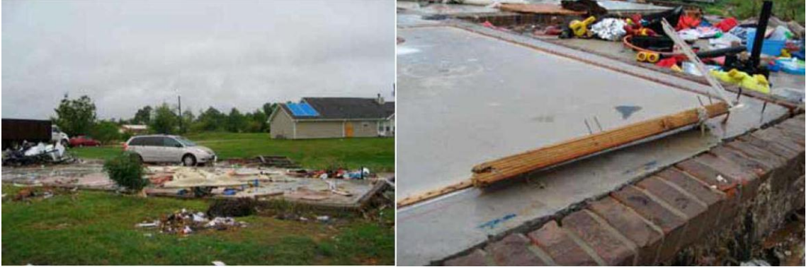
Şekil 4.47 Rüzgâr kuvvetlerinin ahşap yapıyı parçalaması [60]
