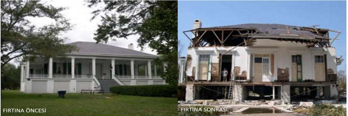
Şekil 4.44 Rüzgâr kuvvetlerinin ahşap yapılara etkisi [57]
