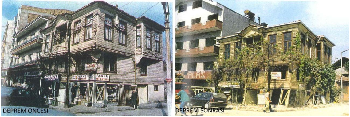
Şekil 4.21 Ahşap yapılarda görülen yumuşak kat etkisi [41]
