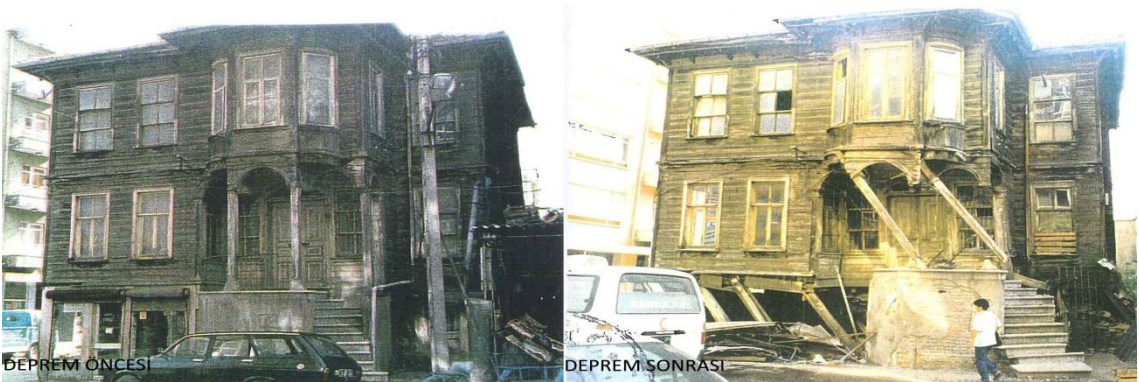
Şekil 4.22 Ahşap yapılarda görülen yumuşak kat etkisi [41]
