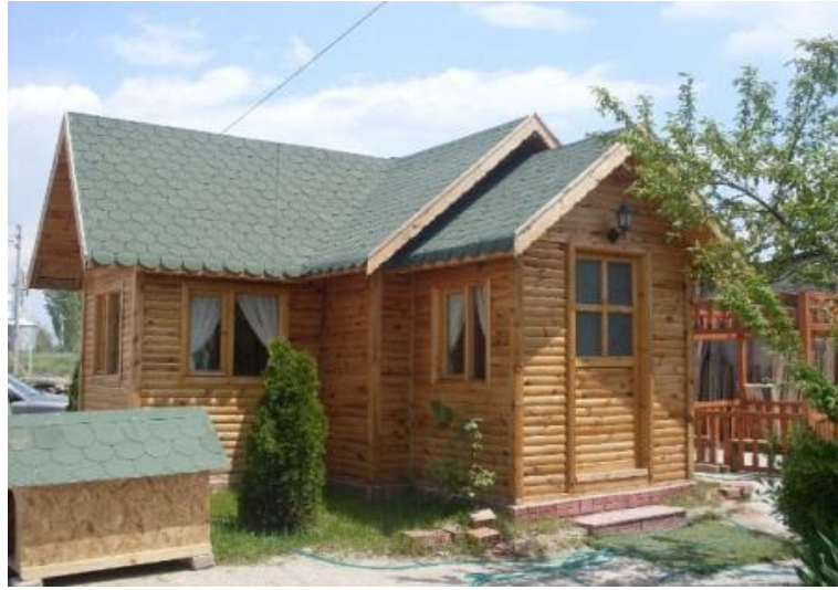
Şekil 2.4 Dikmeli yapım yöntemi uygulanmış konut [18]
