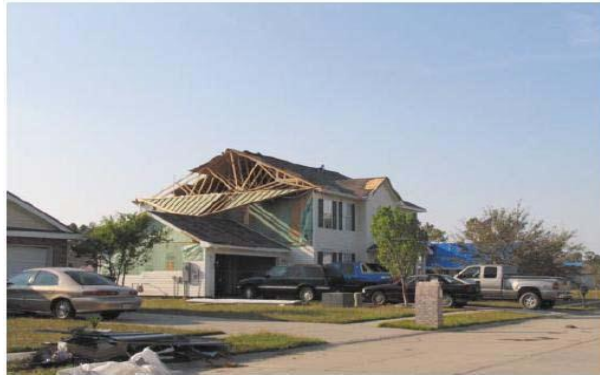
Şekil 4.75 Kalkan duvarının yıkılması [61]
