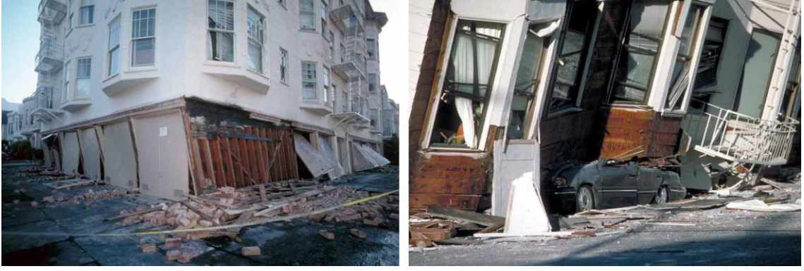
Şekil 4.3 Loma Pritea depremi sonrası ahşap yapılarda görülen hasarlar [48], [49]
