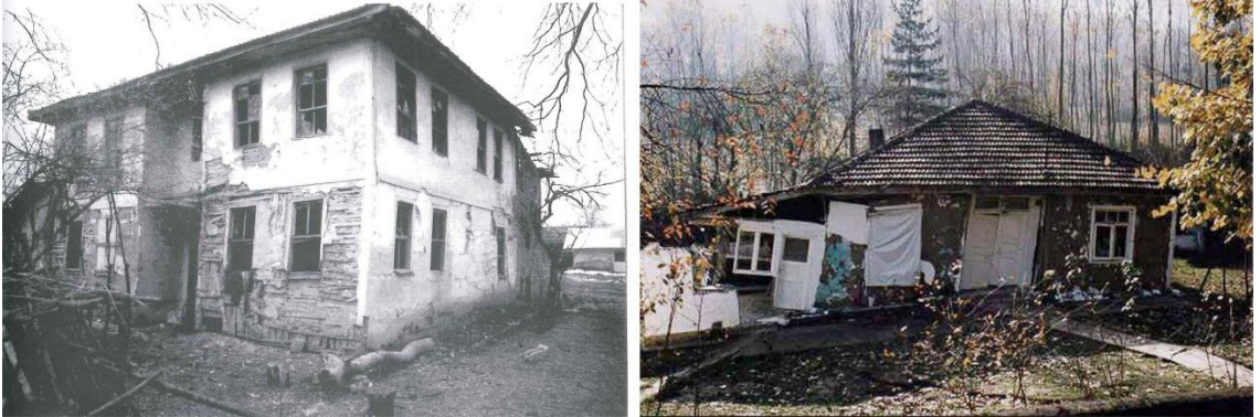
Şekil 4.6 Ahşap yapılarda oluşan makaslama etkisi [41]
