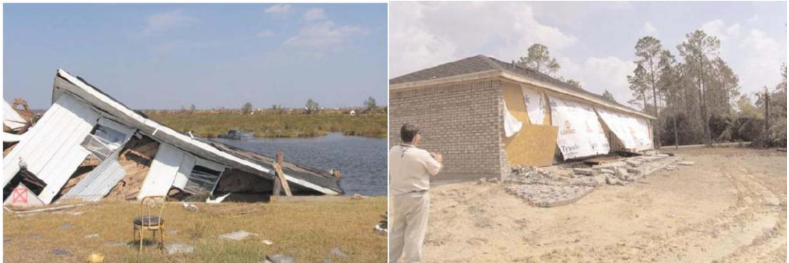
Şekil 4.84 Su baskınlarının ahşap yapılara etkisi [61]
