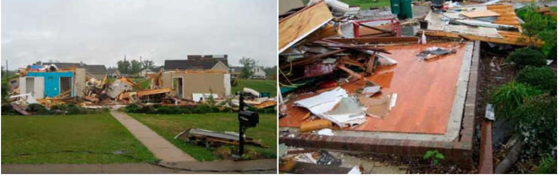
Şekil 4.49 Duvar – zemin bağlantısı ve yıkımı [60]
