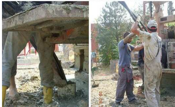
Şekil 4.12 Toprakaltı Devresi'nin sondaj ve yerleřtirme alıřmaları
