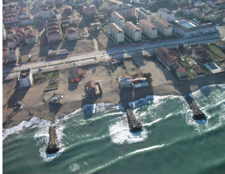
Şekil 3.16 Liman yakınındaki mahmuzlar ve erozyon durumu [11]
