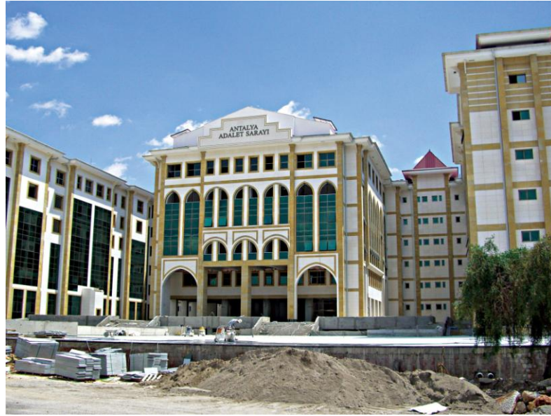
Şekil 3. 13 Selçuklu mimarisine öykünen Antalya Adliye Binası [82]
