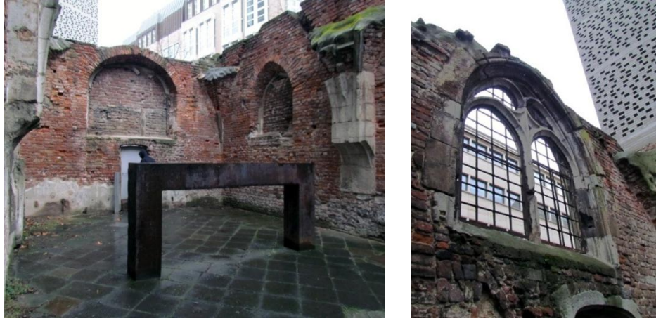
Şekil 4.13 Zemin katta bulunan diğer avlu
