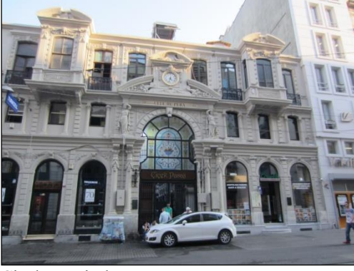
Çiçek Pasajı dış görünüş [159]
