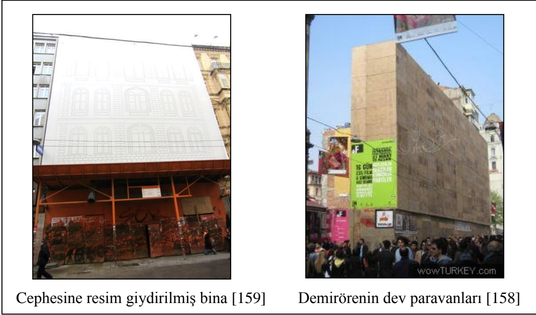
Şekil 5. 26 Yapım aşamasında tarihi bir bina ile Demirören kıyaslaması
