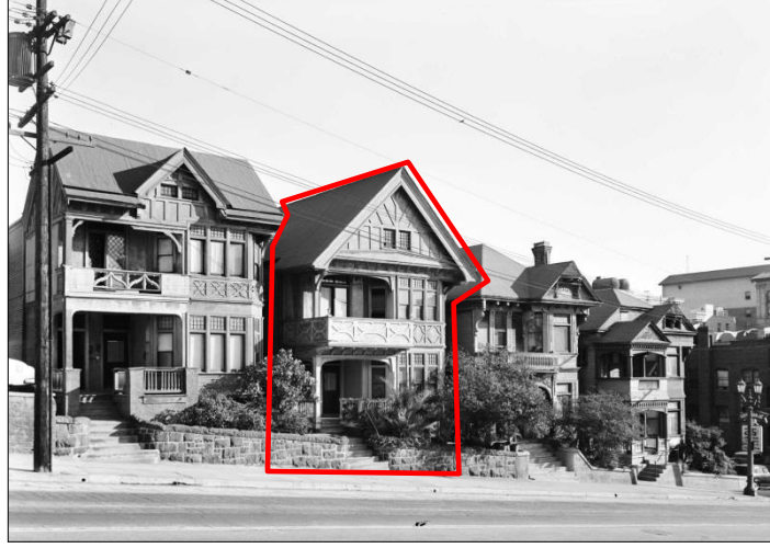
Şekil 3. 4 Komşularından ileride ve ayrıık nizam olarak uygulanan yeni yapı [132]
