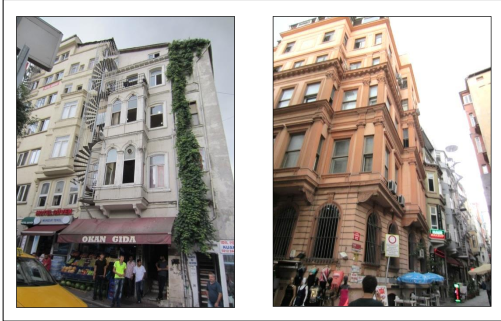
Şekil 4. 30 Sakızağacı caddesi üzerinde sivil mimarlık örneği yapılar
