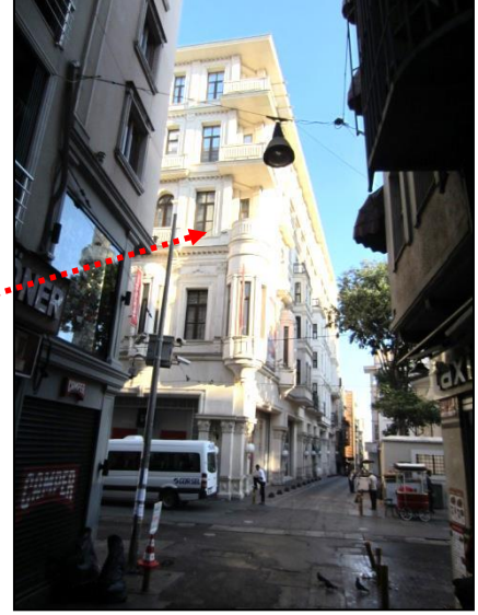
(2014) yıkılan yapıların yeri [159]
