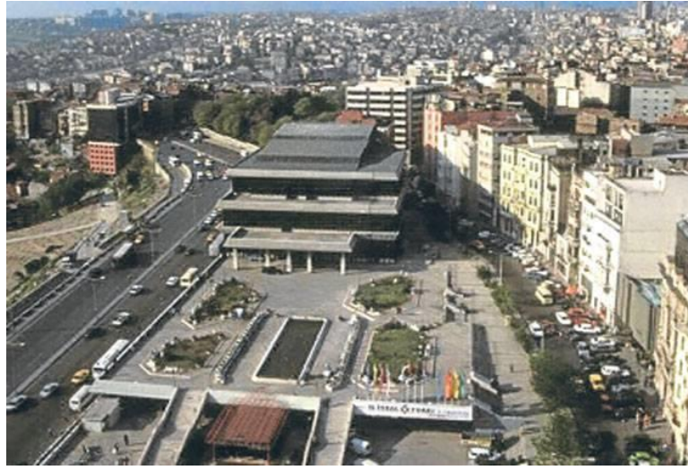
Şekil 3. 25 Meşrutiyet Caddesi'nde serbest yaklaşımla yapılmış TRT binası
