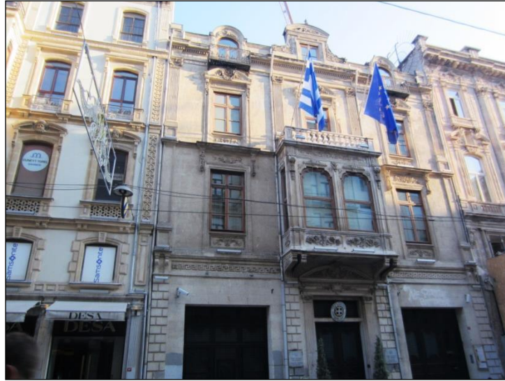
Şekil 4. 26 Çalışma alanındaki Yunanistan Konsolosluğu binası
