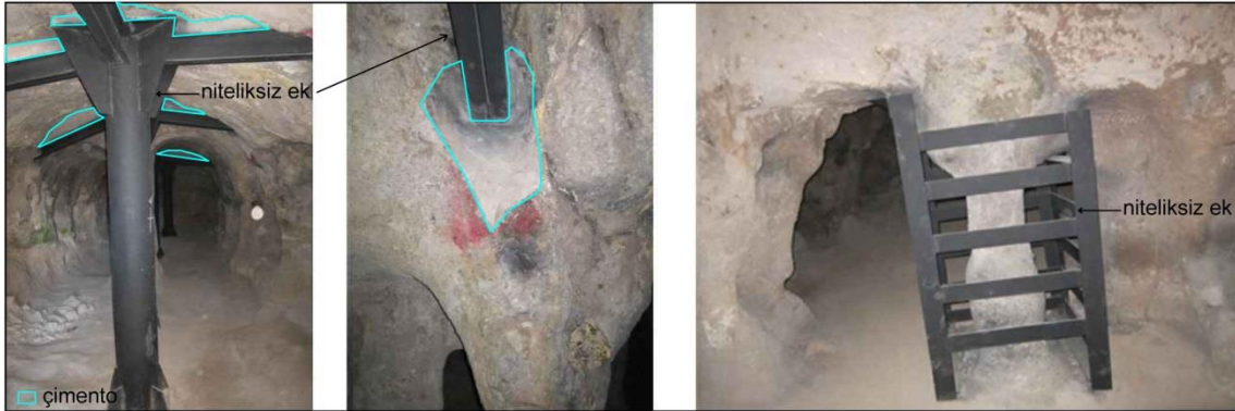
Şekil 4. 9 Mazi Yeraltı Şehri'nde kullanılan niteliksiz ekler ve çimento kaynaklı hatalı onarım hasarları
