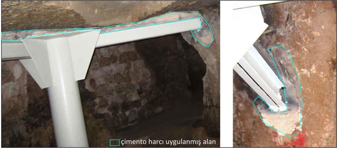
Şekil 4. 23 Çelik kolon/kiriş-kaya birleşiminde çimento harcı kullanımı
