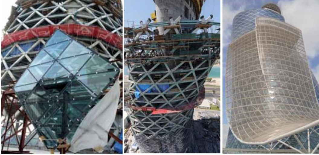
Şekil 2.26 Capital Gate Cephe Detayları [21]
