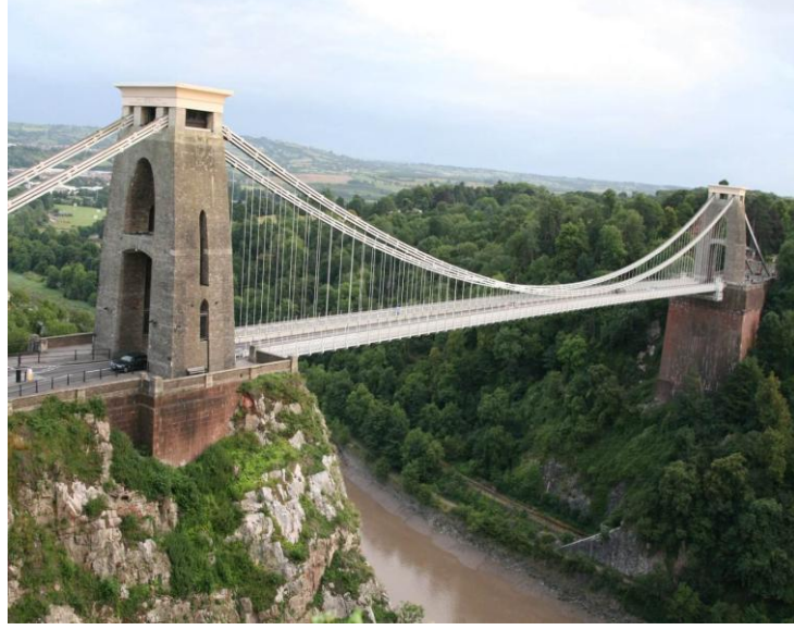
Şekil 2. 3 Clifton asma köprüsü
