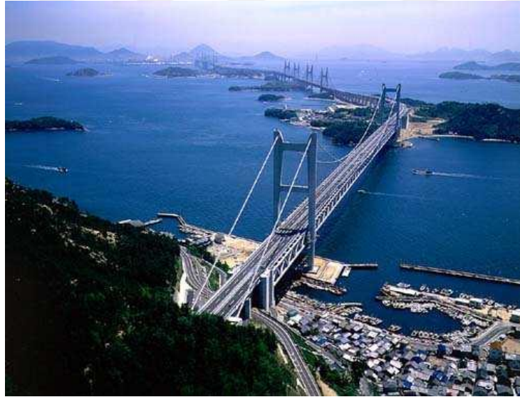
Şekil 2. 12 Shimotsui asma köprüsü
