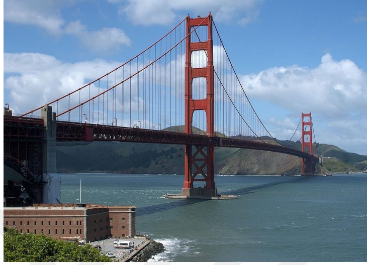
Şekil 2. 9 Golden Gate asma köprüsü
