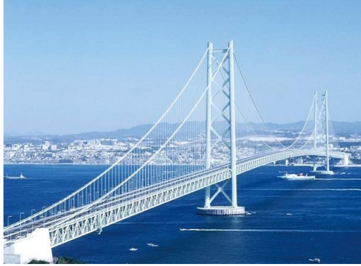
Şekil 2. 13 Akashi Boğazi asma köprüsü
