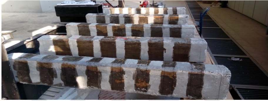
b) CFRP şeritlerin yapıştırılacağı yerlerin astarlanması
