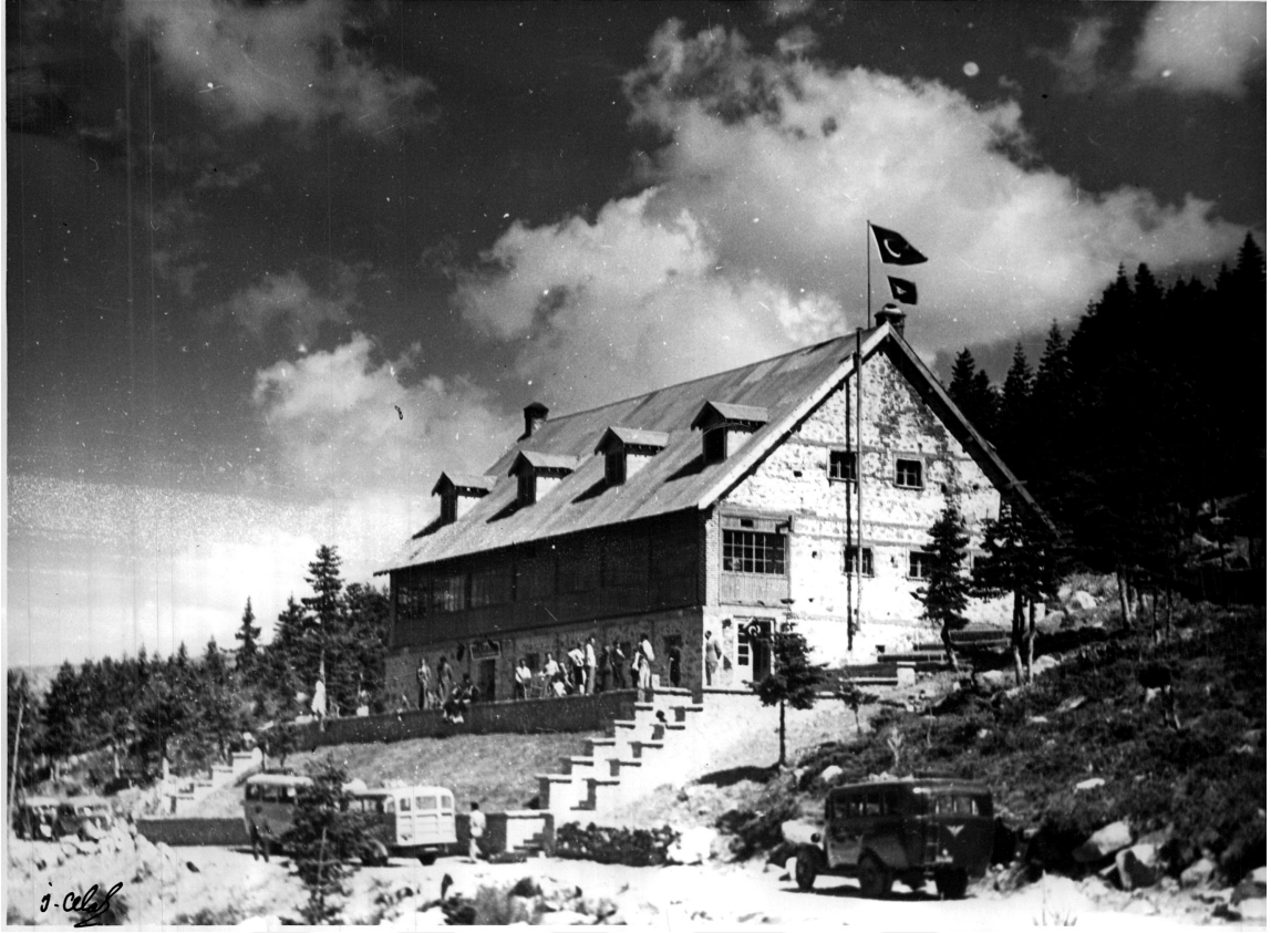
Şekil 6.28 Kayakevi, önündeki varena camekanla kapatılmış [298]
