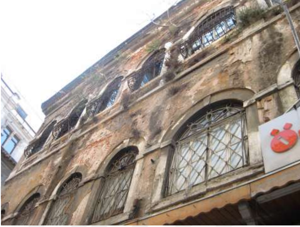
Şekil 4. 29 Mustafa Paşa Hanı Cephesinde Görülen Biyolojik Bozulmalar [B.N.İskender, 2016].
