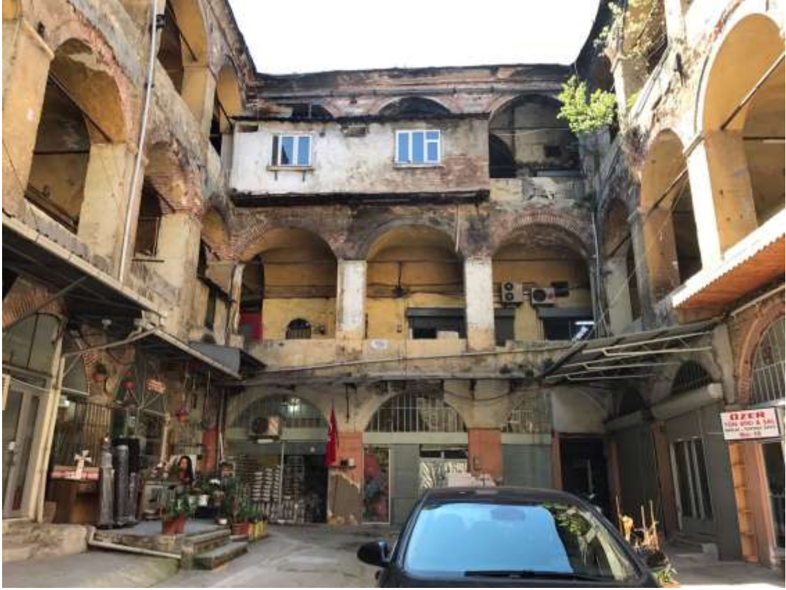
Şekil 5. 49 Büyük Yeni Han İkinci Avlusuna Bakan İkinci Katta Revakların Önüne Yapılan Çıkma [B.N.İskender, 2017]
