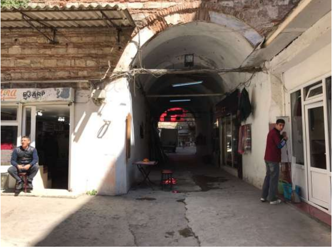
Şekil 5. 51 Büyük Yeni Handa Açıkta Tehdit Oluşturan Kablolar [B.N.İskender, 2017]
