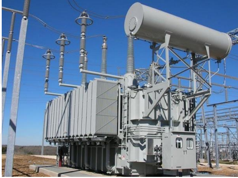
řekil 2.7 Yaęlı tip genleřme depolu transformatr
