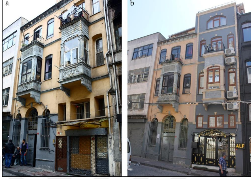
Şekil 5. 3 175 Ada 29 Parselde yer alan tescilli yapının 2014 yılında (a) ve 2016 yılındaki (b) durumu [Z.A.Ozan].
