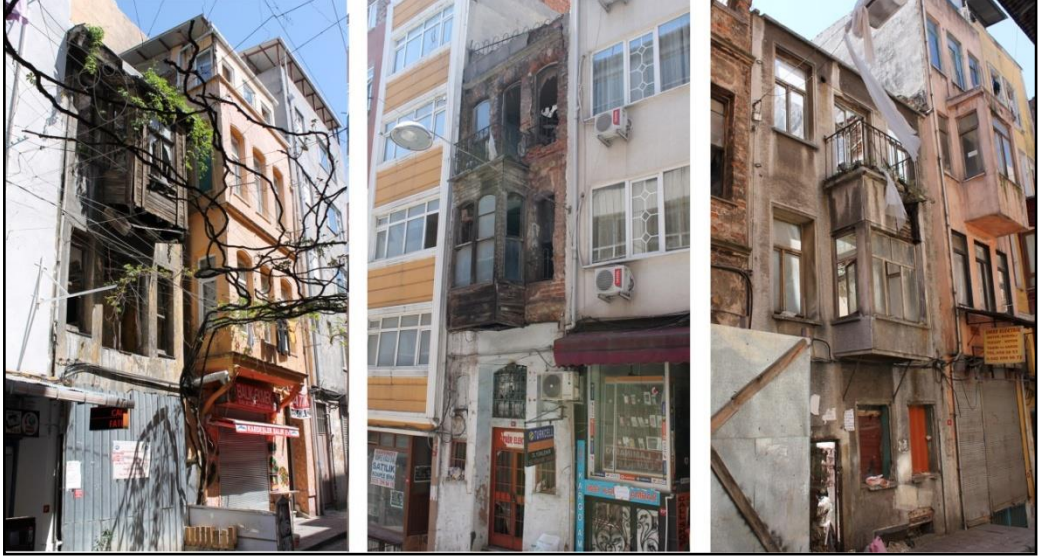
Şekil 3. 56 Çalışma alanındaki ahşap cumbalı yığma yapıların güncel durumu [Z.A.Ozan].
