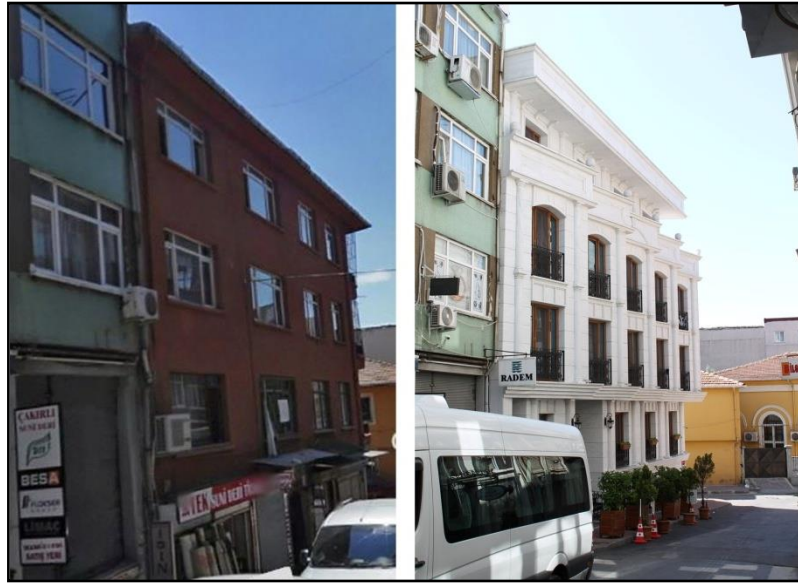
Şekil 3. 50 1166 ada 30 parselde yer alan yapının yıkılıp yeniden yapıldıktan önceki ve sonraki durumu [Z.A.Ozan].
