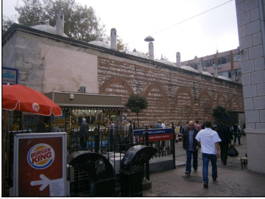
Şekil 3. 25 Külliye'nin batı cephesinde izleri okunan yıkılmış bölümler, 2016 [Z.A.Ozan].
