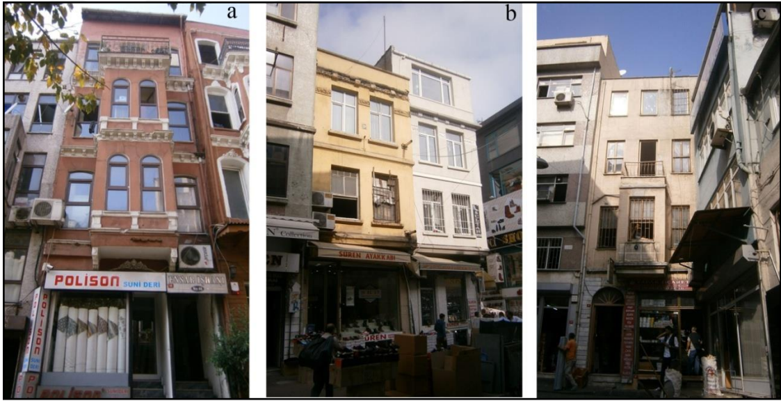
Şekil 3. 63 196 Ada 22 Parsel (a), 209 Ada 22-23 Parsel (b) ve 218 Ada 9 Parselde (c) yer alan özgünlüğünü kısmen yitirmiş tescilli yapılar [Z.A.Ozan].
