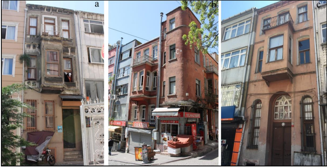
Şekil 3. 59 196 Ada 17 Parsel (a) ve 192 Ada 19-20 Parsel (b), 189 Ada 25 Parselde (c) yer alan basit onarım gerektiren tescilli yapılar [Z.A.Ozan].
