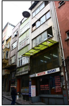
Şekil 3. 47 173 Ada 20-21-22 parsellerde yer alan betonarme han yapısı örnekleri [Z.A.Ozan].
