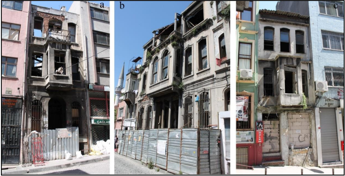
Şekil 3. 72 191 Ada 42 Parsel (a), 175 Ada 7 Parsel (b) ve 188 Ada 17 Parselde (c) yer alan boş yapılar [Z.A.Ozan].
