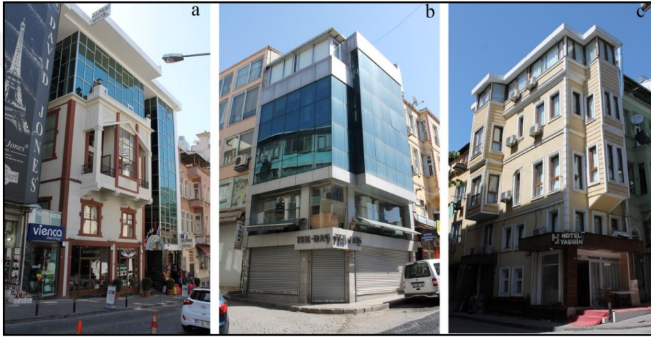
Şekil 3. 65 204 Ada 24 Parsel (a), 207 Ada 2 Parsel (b) ve 189 Ada 1 Parselde (c) yer alan özgünlüğünü yitirmiş tescilli yapılar [Z.A.Ozan].
