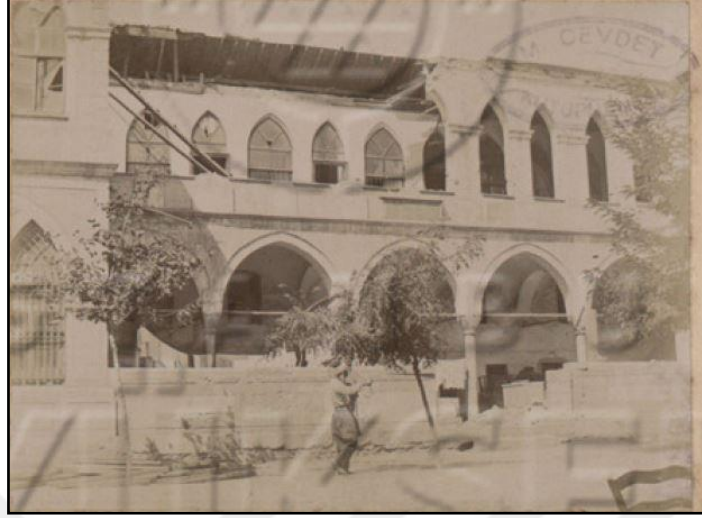
Şekil 2. 9 Çarşıkapı'da konumlanan Kemankeş Kara Mustafa Paşa Medresesi'nin 1894 depreminden sonraki durumu [25].
