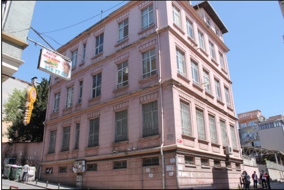
Şekil 3. 10 Gedikpaşa Ortaokulu Tiyatro Caddesi cephesi [Z.A. Ozan].
