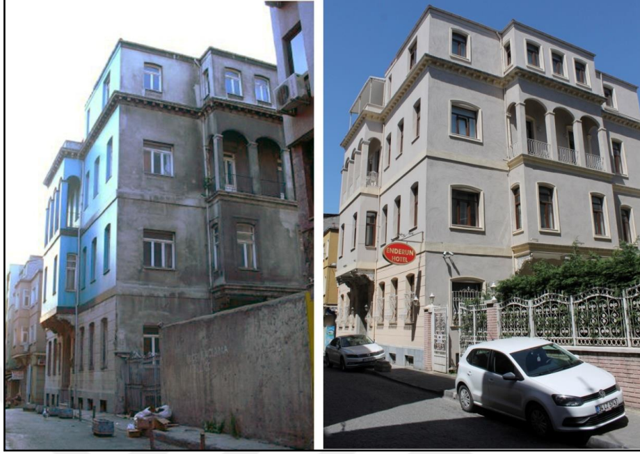
Şekil 3. 49 199 ada 32 parselde yer alan Gedikpaşa Amerikan Okulu'nun restorasyon öncesi ve sonrası görünümü [Z.A.Ozan].
