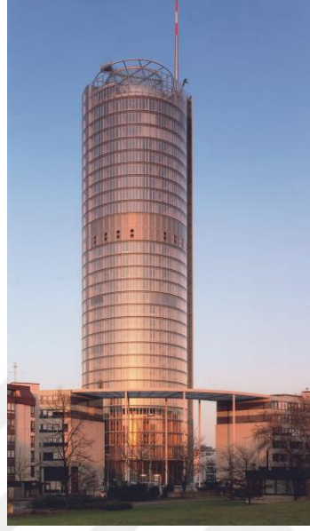
Şekil 2.7 RWE AG Headquarters Binası, Essen[20]
