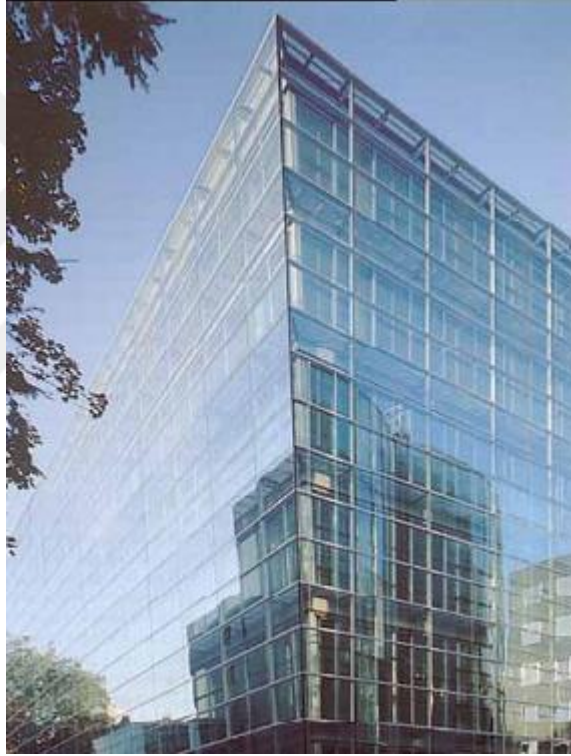
Şekil 2.20 Çok katlı çift kabuk cephe örnek, Victoria Ensemble, Cologne, Almanya[33]
