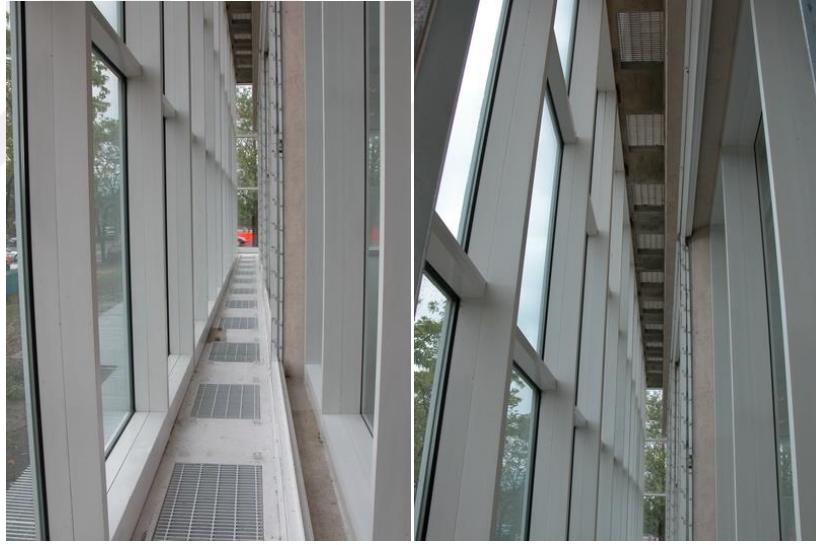
Şekil 2.27 Çift kabuk cephe ara boşluk detayı, Occidental Chemical, Newyork [37]
