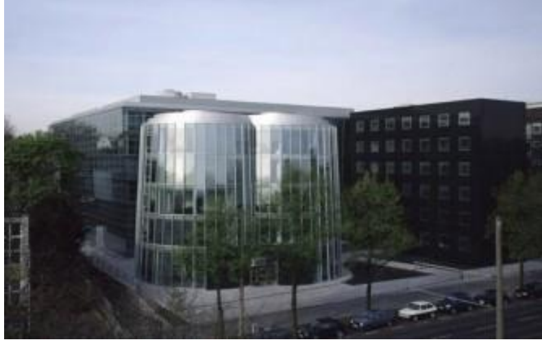
Şekil 2.19 Çok katlı çift kabuk cephe örnek, Victoria Ensemble, Cologne, Almanya[33]
