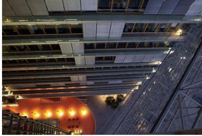
Şekil 2.14 City Gate Binası cephe içi görünüm [29]
