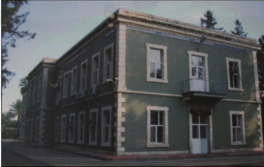
Şekil 3. 160 Adana Askeri Kışla Binası, 2007 [91]
