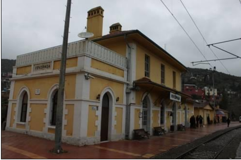
Şekil 3. 153 Fevzipaşa İstasyon Binası, 2015
