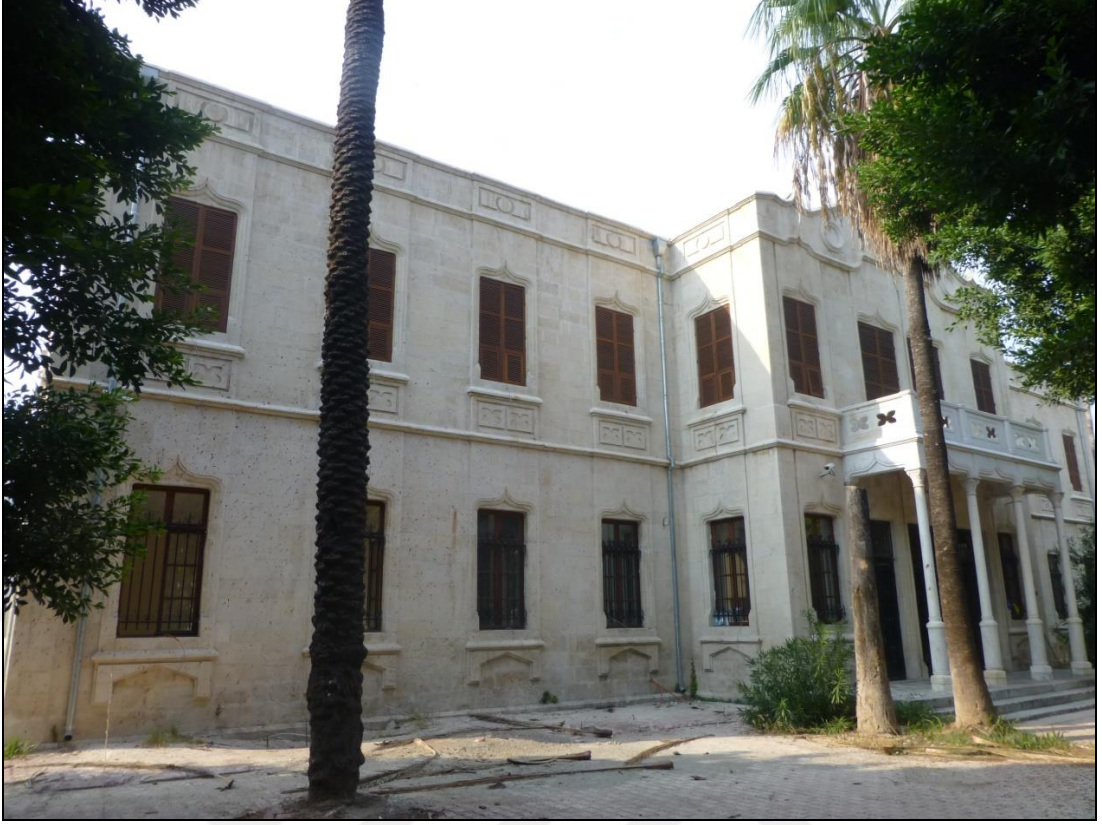
Şekil 3. 12 Mersin Hükümet Konağı, 2014
