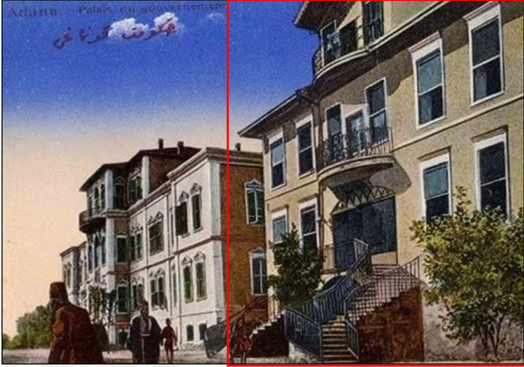
Şekil 3. 40 Adana Vali Konağı [18]
