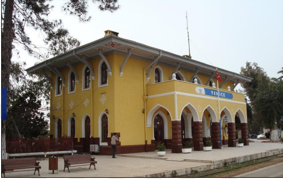
Şekil 3. 136 Adana Yenice İstasyon Binası, 2014
