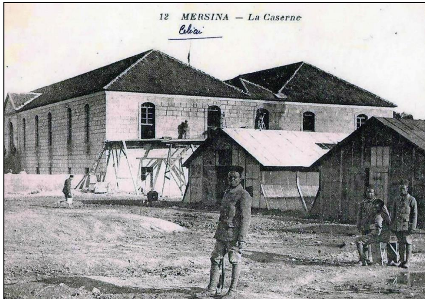
Şekil 3. 173 Mersin Askeri Kışla Binası [94]
