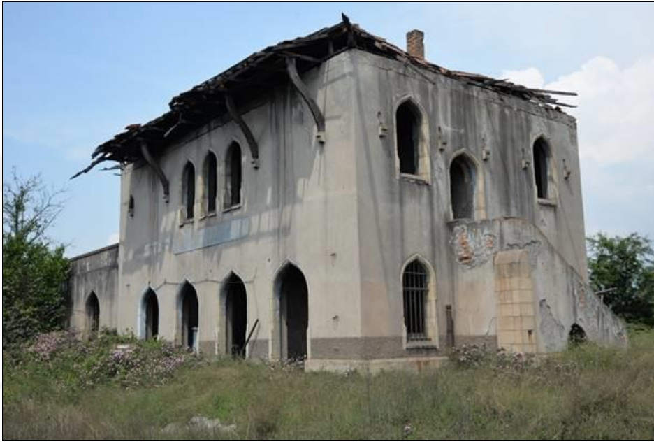
Şekil 3. 150 Payas İstasyon Binası, 2015
