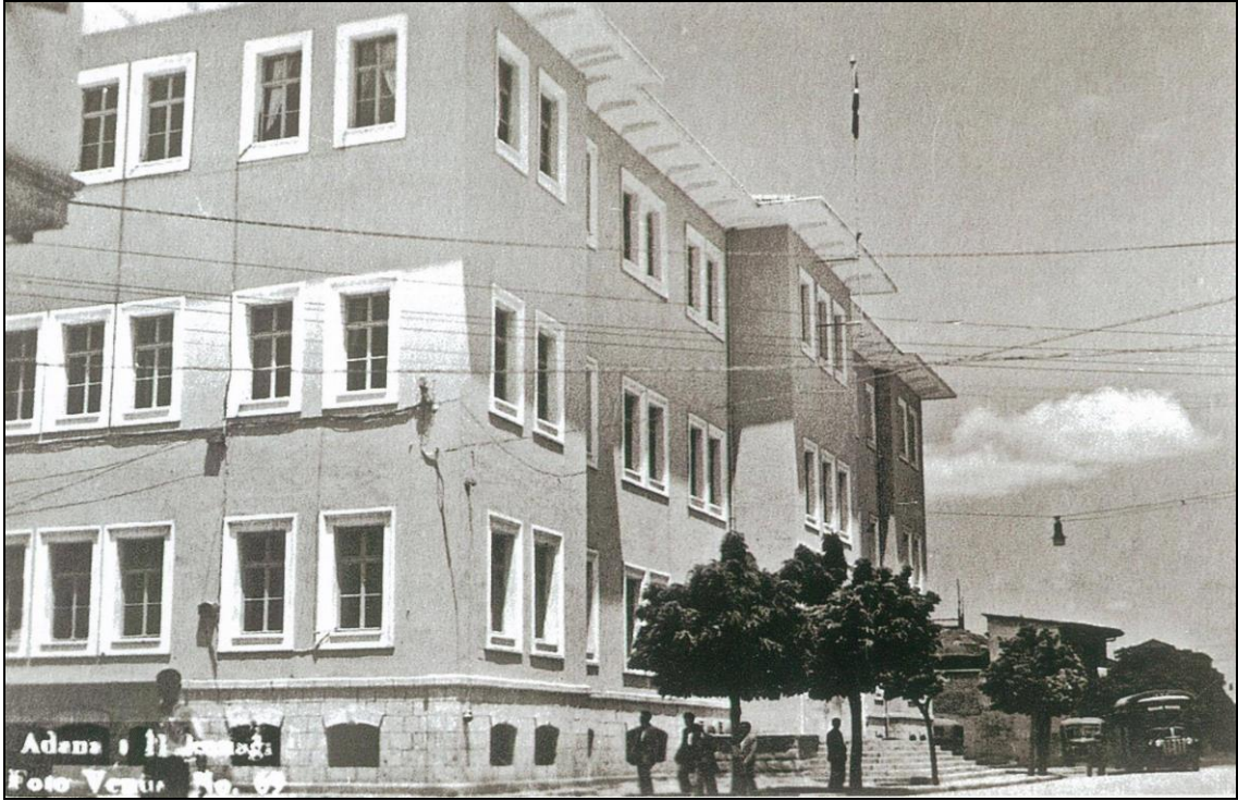
Şekil 3. 4 Adana Hükümet Konağı III. Dönem 1
