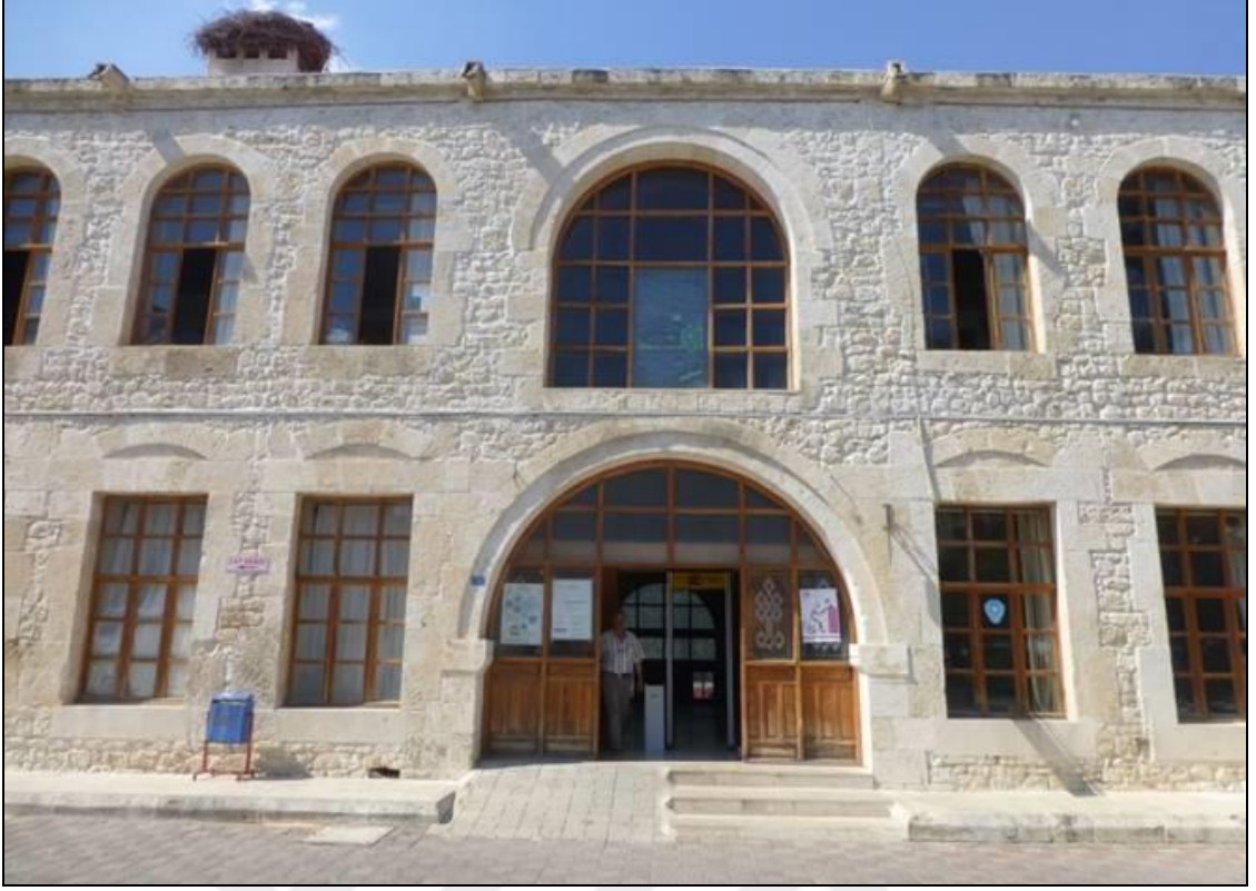
Şekil 3. 17 Silifke Hükümet Konağı giriş, 2014
