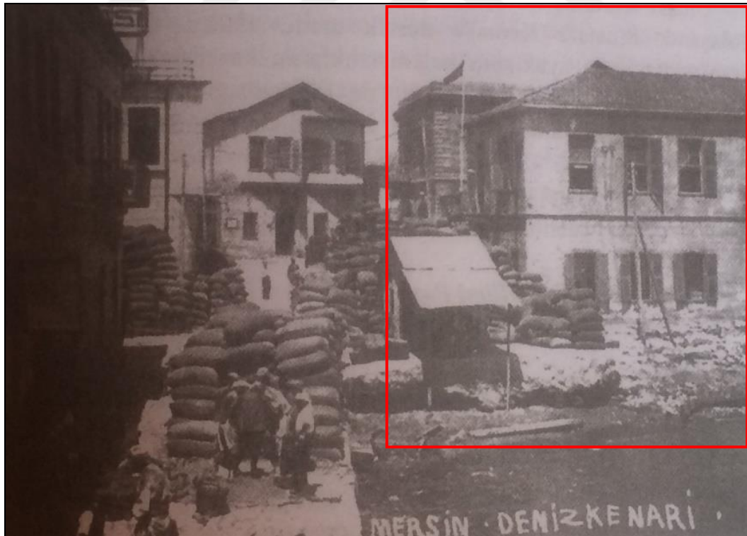
Şekil 3. 62 Mersin Posta Telgraf Binası, 1930 [38]
