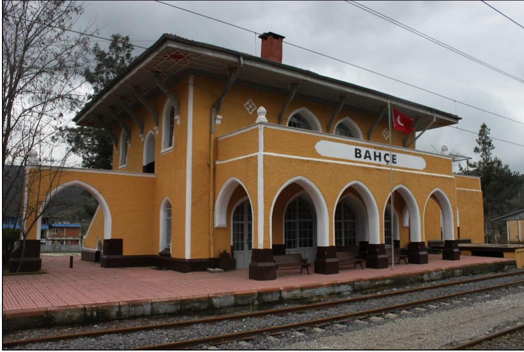
Şekil 3. 144 Bahçe İstasyon Binası, 2015
