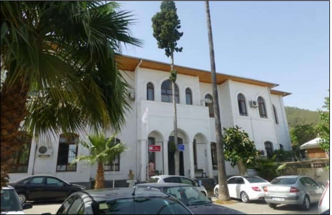
Şekil 3. 21 Anamur Hükümet Konağı, 2014
