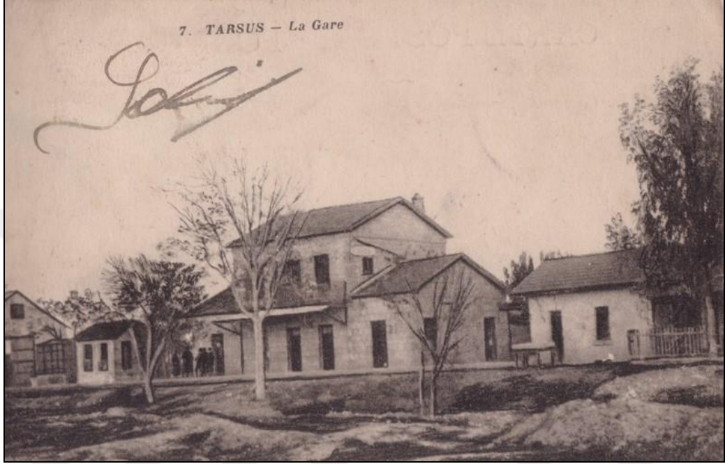
Şekil 3. 154 Tarsus İstasyon Binası 1
