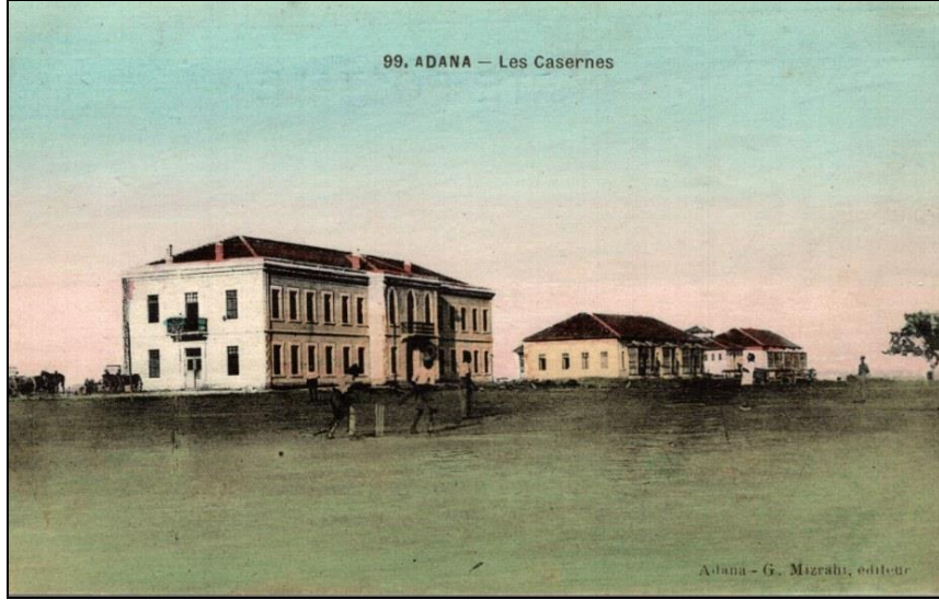
Şekil 3. 159 Adana Askeri Kışla Binası [90]
