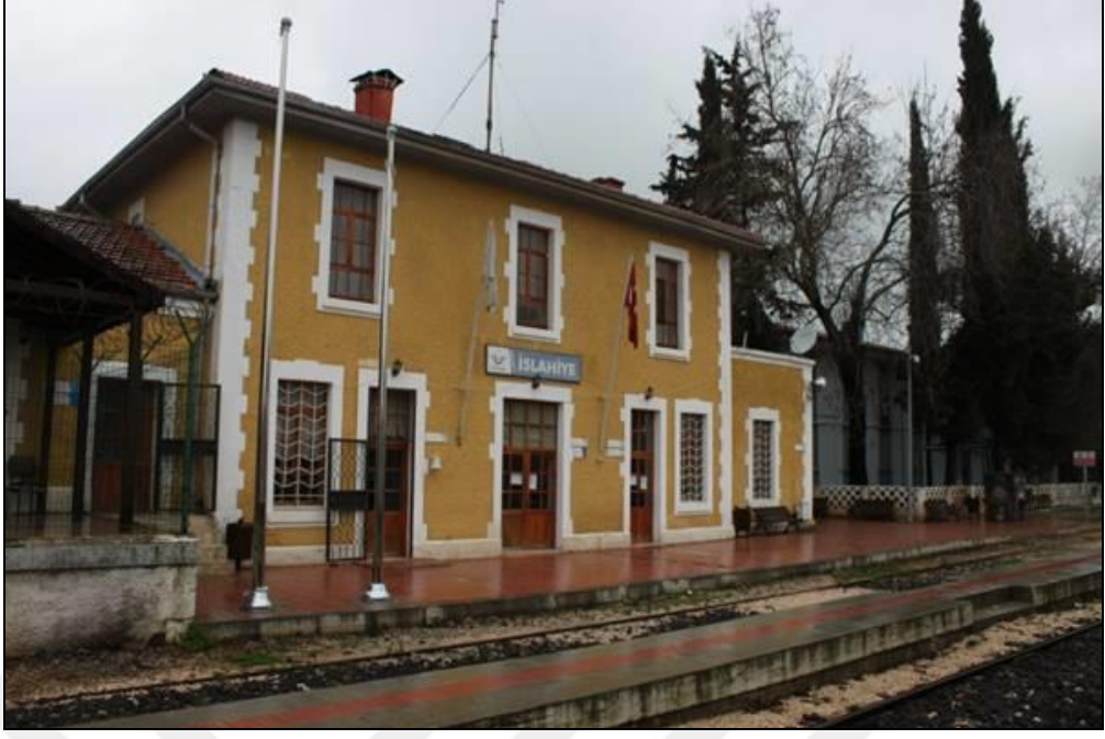
Şekil 3. 152 İslahiye İstasyon Binası, 2015
