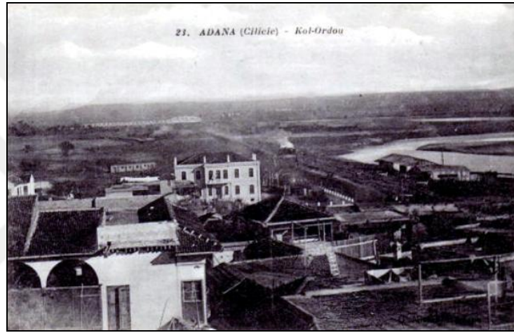
Şekil 3. 157 Adana Kolordu Binası, 1920 [89]
