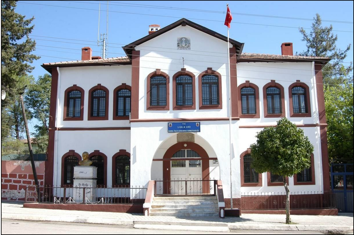
Şekil 3. 23 Hassa Hükümet Konağı, 2014 1
