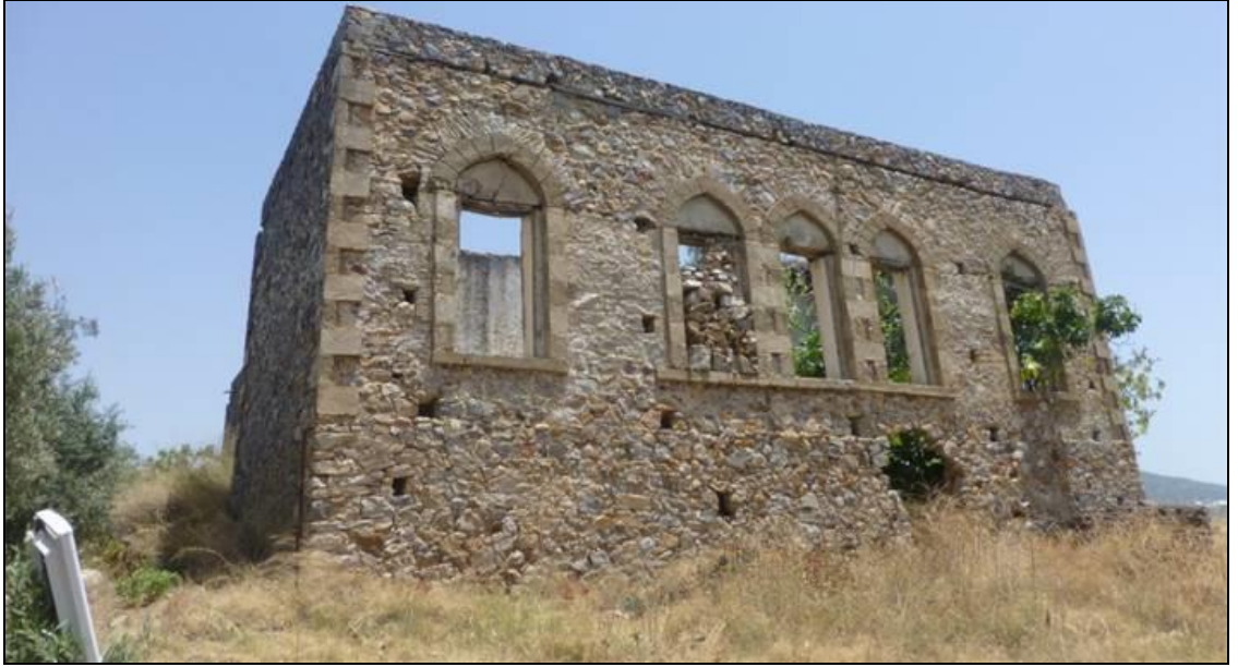
Şekil 3. 119 Anamur Ferizler Köy Okulu Sol Yan Cephe, 2014
