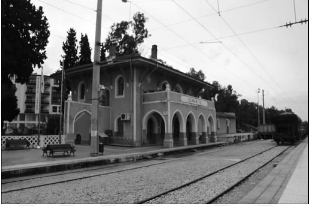
Şekil 3. 148 Osmaniye İstasyon Binası, 2015
