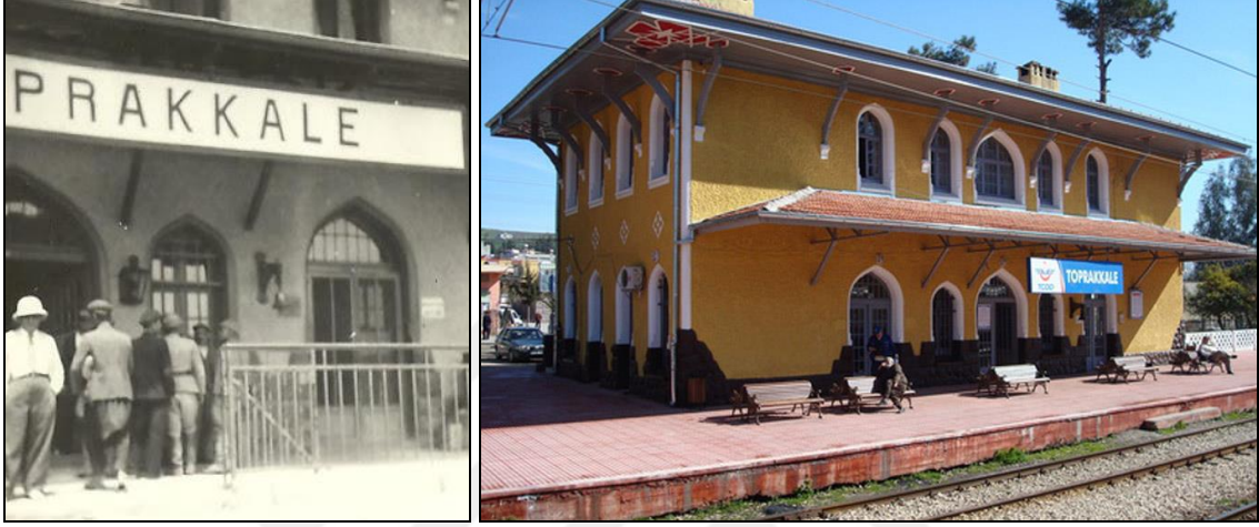
Şekil 3. 145 Toprakkale İstasyon Binası, sol: 1940'lar [82], sađ: 2009 [83]
