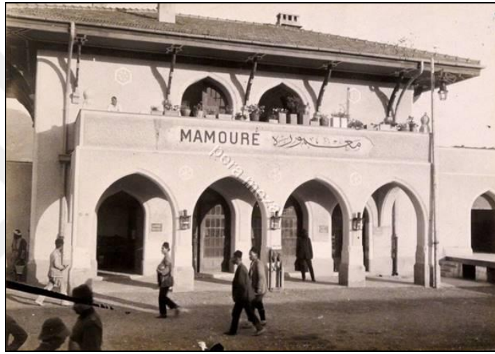
Şekil 3. 146 Mamure İstasyon Binası 1
