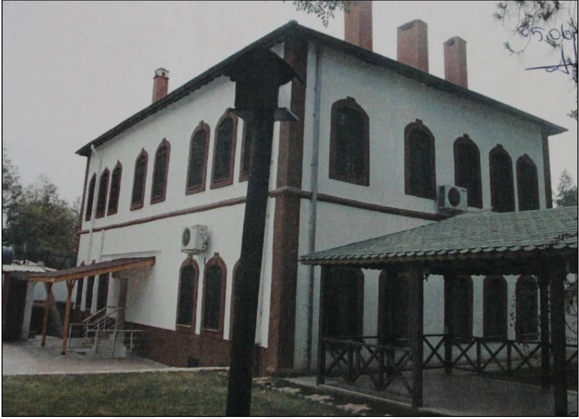
Şekil 3. 24 Hassa Hükümet Konağı, 2014 [40]
