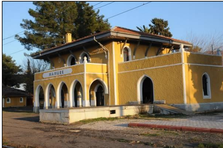
Şekil 3. 147 Mamure İstasyon Binası
