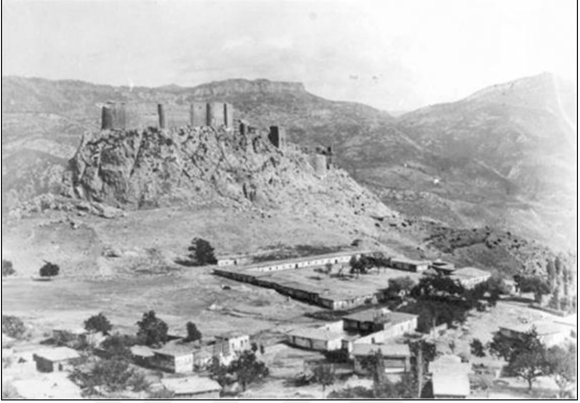
Şekil 3. 169 Fekke Askeri Kışla Binası, 1911 [92]
