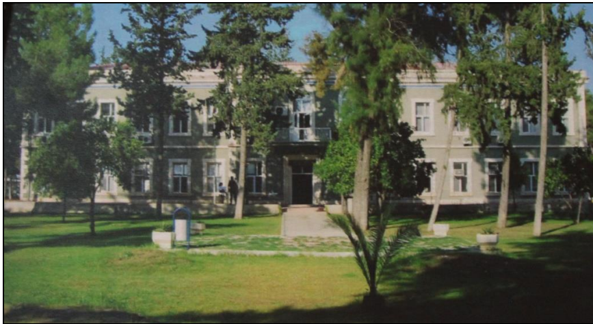
Şekil 3. 161 Adana Askeri Kışla Binası, 2007 [91]
