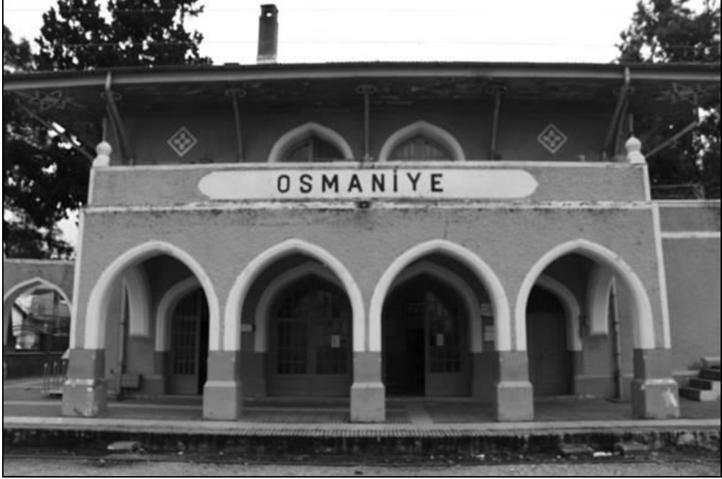
Şekil 3. 149 Osmaniye İstasyon Binası, 2015
