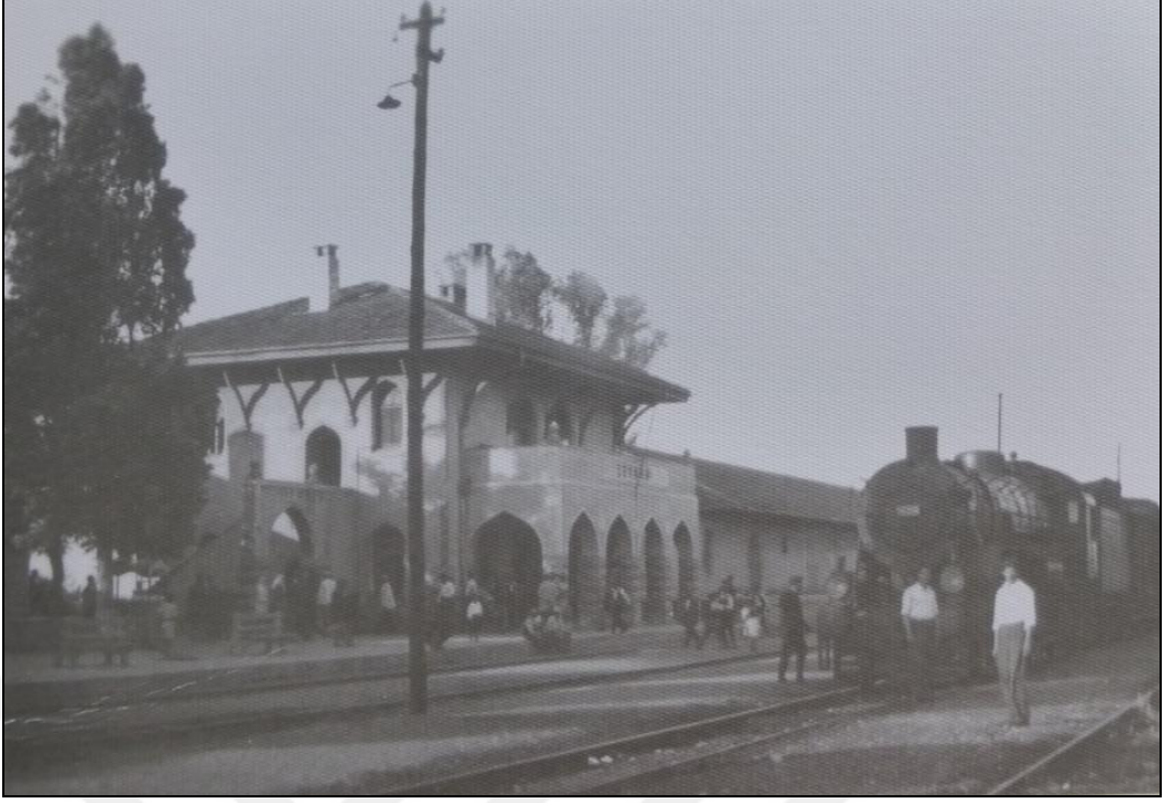
Şekil 3. 142 Ceyhan İstasyon Binası 1
