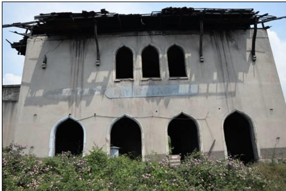
Şekil 3. 151 Payas İstasyon Binası, 2015
