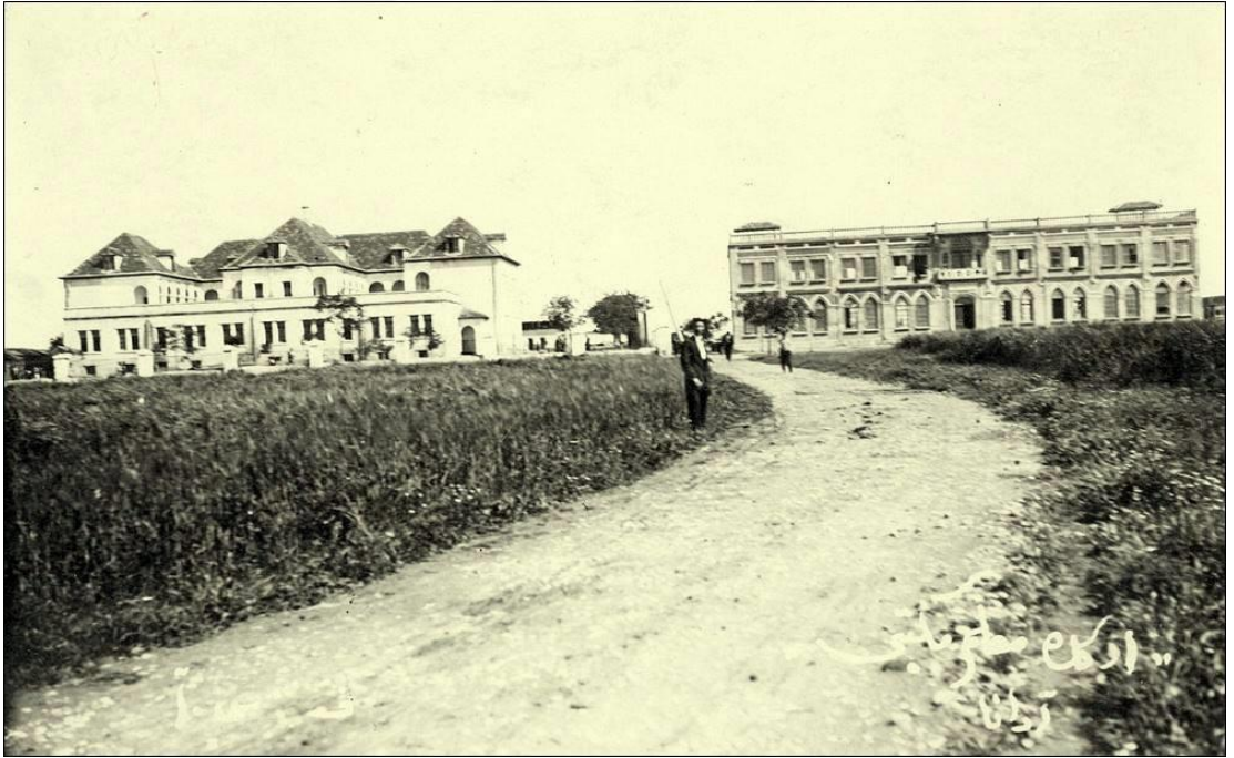
Şekil 3. 84 Adana Darüleytami ve kütüphane - yatakhane - yemekhane binası 2
