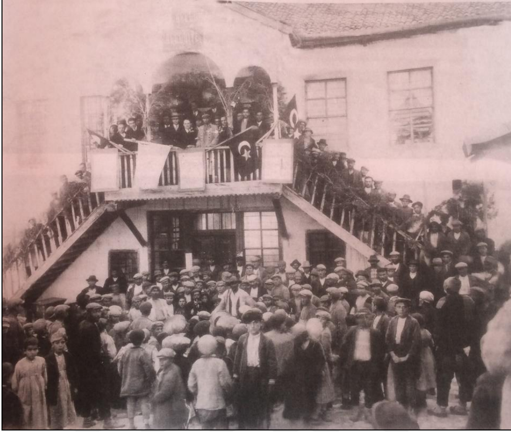
Şekil 3. 48 Ermenek Belediye Binası, 1934 [49]
