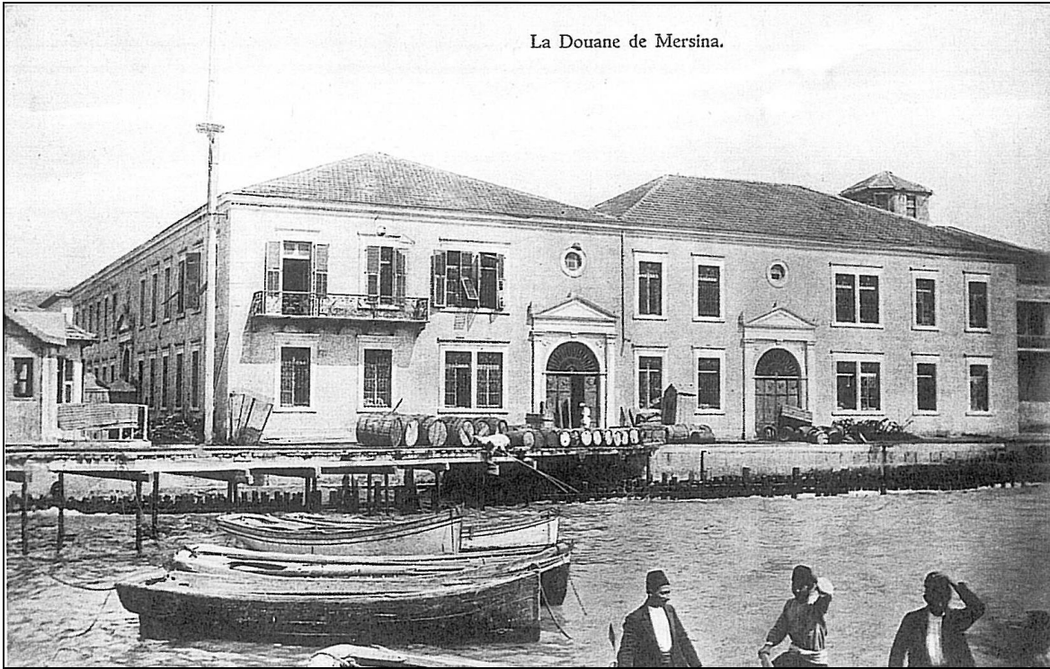
Şekil 3. 58 Mersin Gümrük Binası güney cephesi [24]
