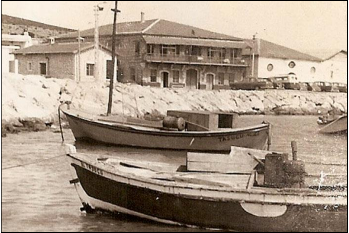
Şekil 3. 50 Taşucu Gümrük Binası 1
