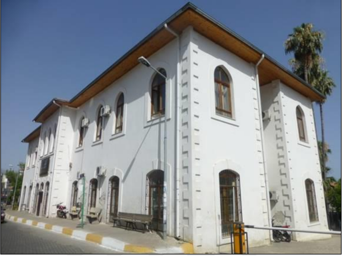
Şekil 3. 20 Anamur Hükümet Konağı, 2014
