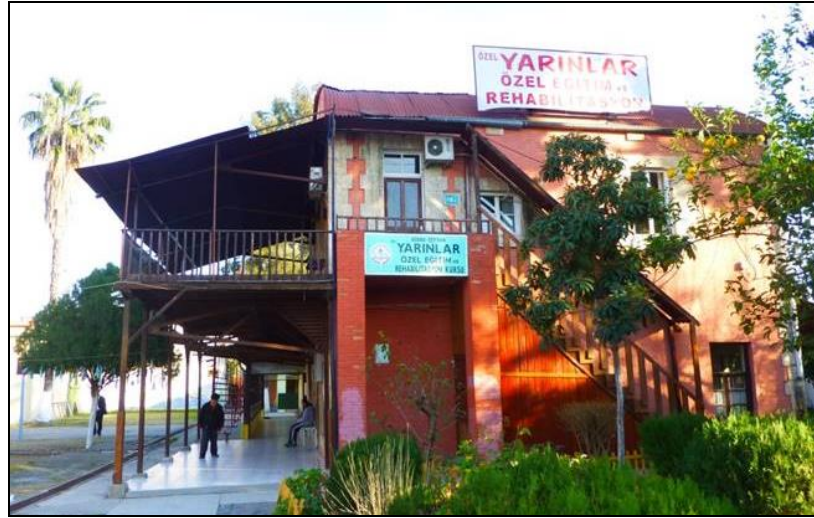
Şekil 3. 134 Adana Eski İstasyon Binası, 2014
