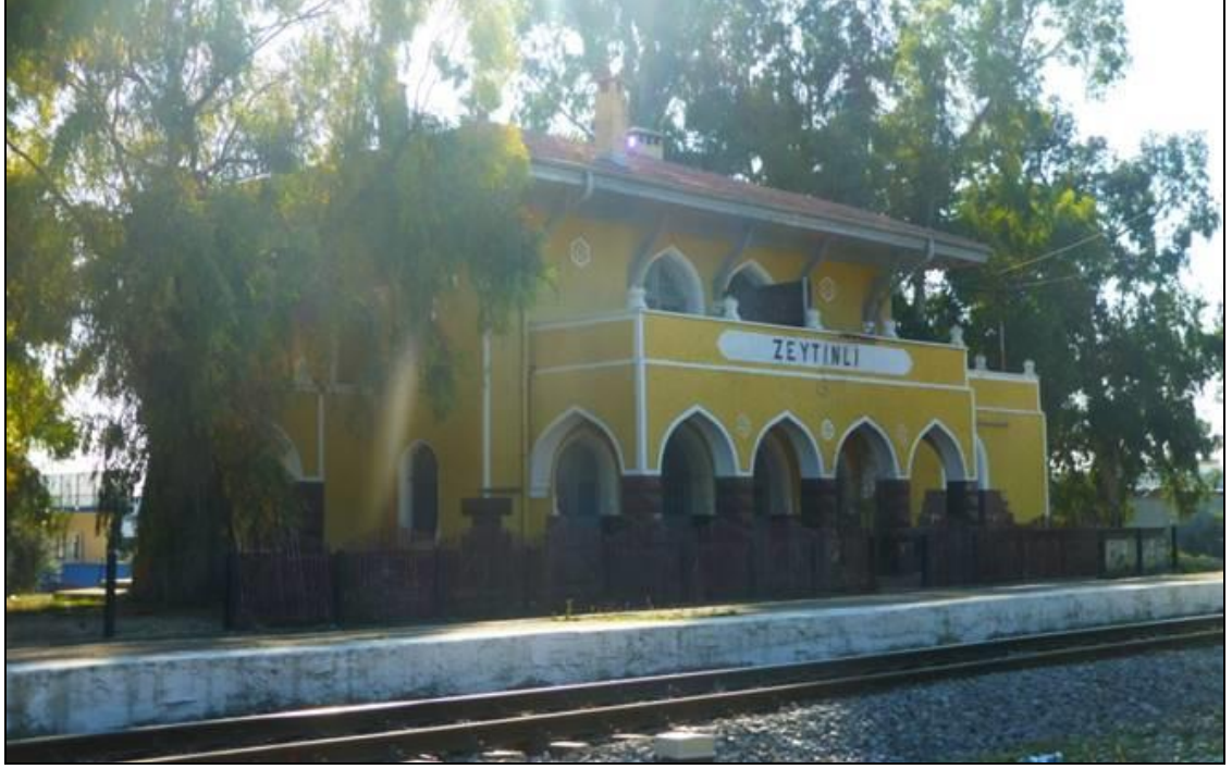
Şekil 3. 135 Adana Zeytinli İstasyon Binası, 2014
