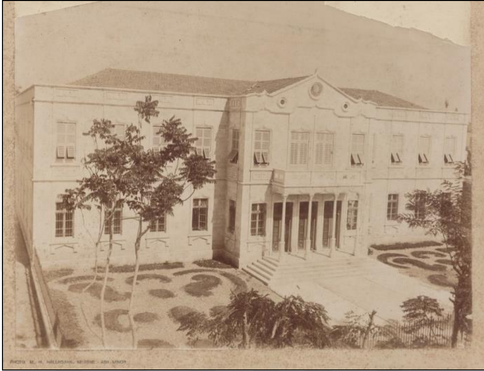
Şekil 3. 10 Mersin Hükümet Konağı 1
