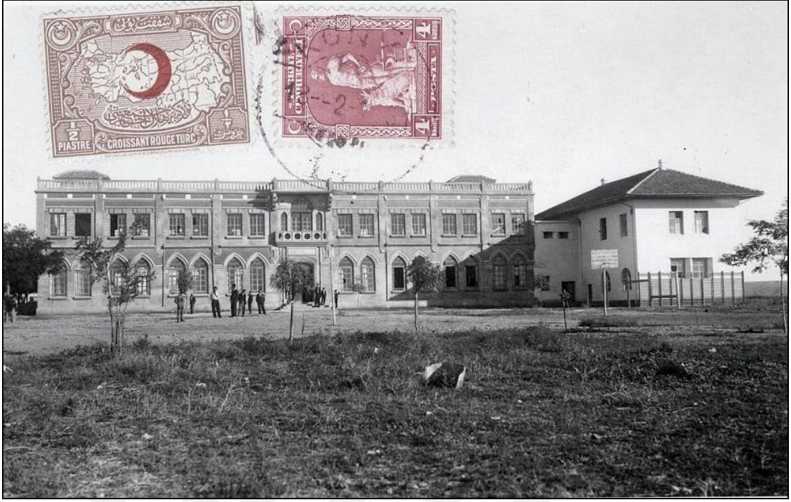
Şekil 3. 85 Adana Darüleytamı'nın kütüphane–yatakhane-yemekhane binası 1
