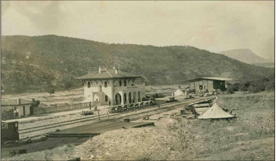
Şekil 3. 143 Bahçe İstasyon Binası 1
