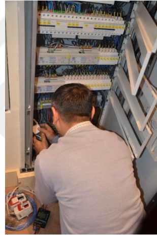
Analizörlerin Aydınlatma Panosuna Yerleştirilmesi
