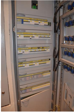
Aydınlatma Elektrik Panosu
