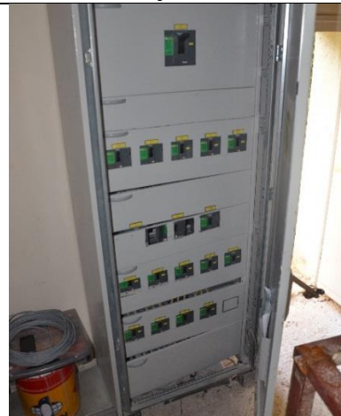
Analizörlerin Aydınlatma Panosuna Yerleştirilmesi
