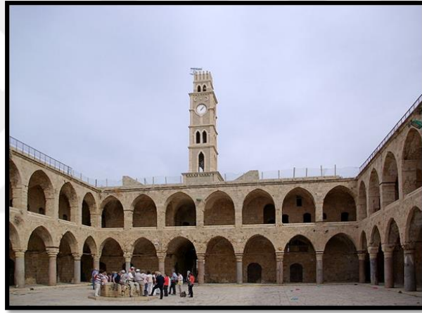
Şekil 2. 2 İsrail, Akka'daki Kervansaray Revakları
