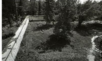
ad: Kasr-ı Hümayûn'un arka bahçesinin onarım öncesi durumu, 1981 sonrası [61]
