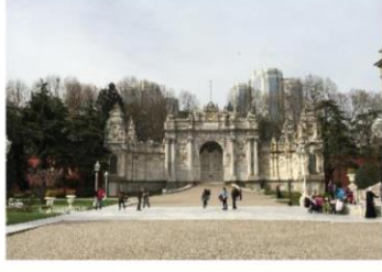
ac: Saltanat Kapısı
