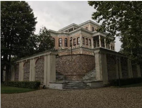
ay: Kasra ulaşımı sağlayan, beşinci set bahçesine ait duvarda bulunan merdiven
