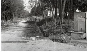
r: Kasırların giriş yolunun onarımlar öncesindeki durumu, 1981 sonrası [61]
