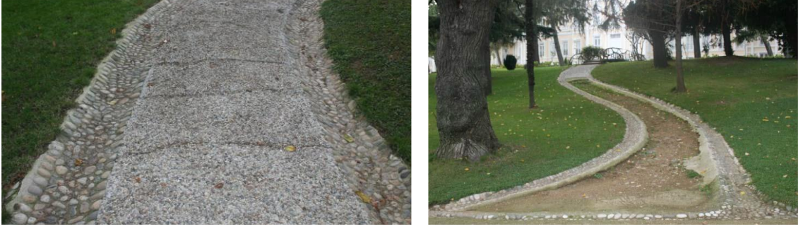
Şekil 3.21 Solda Yıldız Sarayı Şale Köşkü bahçelerindeki iri agregalar ile hazırlanmış yağmur oluklu yer döşemesinin özgün hali [177], sağda aynı yer döşemesinin onarım öncesi durumu [177].
