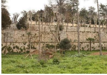
v: 2005 yılında set duvarlarının durumu [61]
