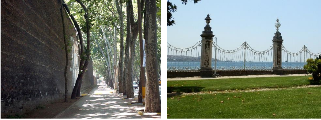
Şekil 2.51 Solda Dolmabahçe Sarayı'nın kara tarafını çevreleyen bahçe duvarları, sağda Dolmabahçe Sarayı'nın denize bakan cephesini çevreleyen parmaklıklar
