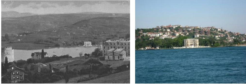
Şekil 3.8 Solda Küçüksu Kasrı ve Göksu Mesiresi'nin 1980 yılındaki görünümü [58], sağda günümüz hali
