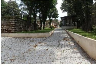
r: Kasir içindeki arnavutkaldırımı yol
