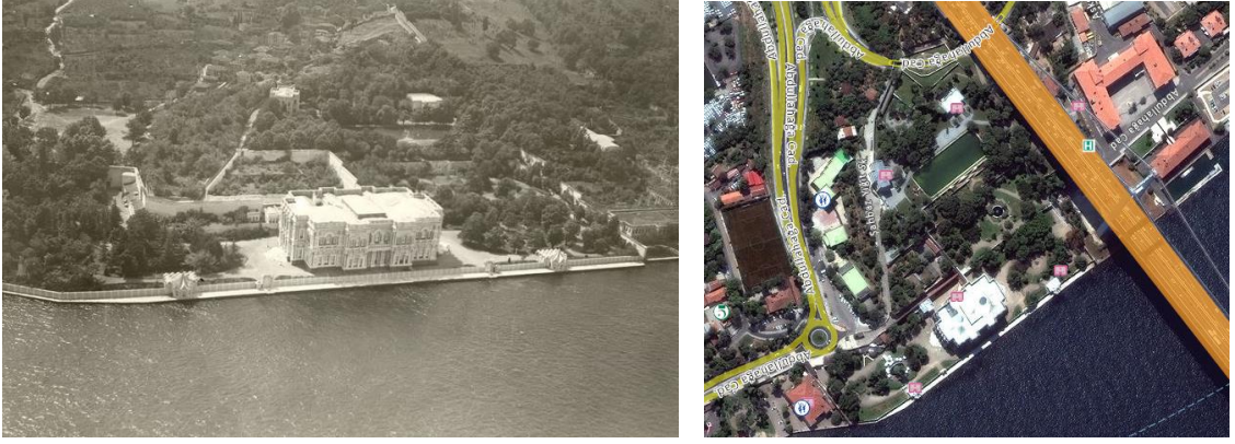
Şekil 3.1 Solda Boğaziçi Köprüsü yapılmadan önce Beylerbeyi Sarayı'nın havadan görünümü [58], sağda sarayın 2017 yılına ait hava fotoğrafı [57]
