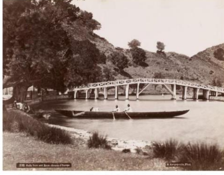
j: Kağıthane Deresi üzerinde bulunan ahşap köprü, 1875 yılı [38]
