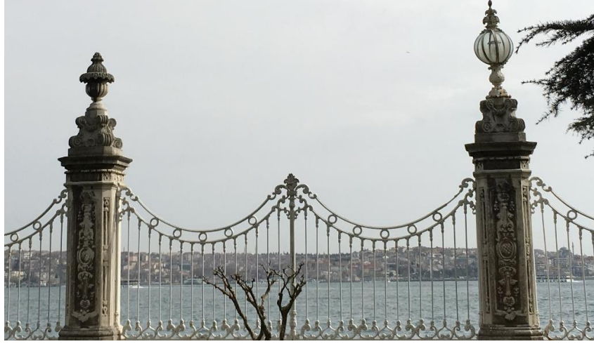
Şekil 3.41 Dolmabahçe Sarayı bahçelerinde rıhtım boyunca uzanan taş babalı demir parmaklıklar (taş babalar üzerinde kir birikimleri ve siyah kabuk oluşumları görülmektedir)
