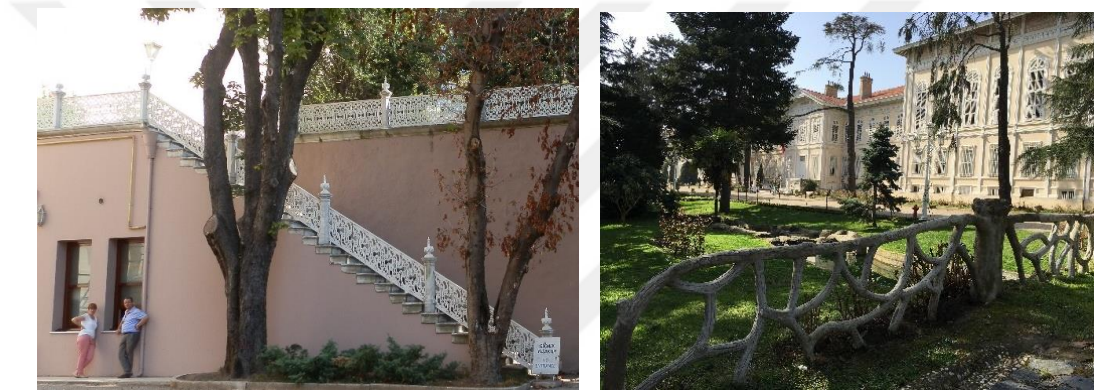
Şekil 2.69 Solda Beylerbeyi Sarayı set bahçelerinin demir merdiven korkulukları, sağda Yıldız Sarayı'nda demir iskelet üzerindeki harcın şekillendirilmesi ile oluşturulan ağaç dalı görünümlü bahçe korkulukları
