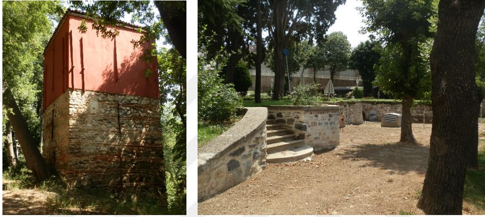
Şekil 2.93 Solda Ihlamur Kasrı bahçesinde bulunan su deposu, sağda Aynalıkavak Kasrı bahçelerinde bulunan su sarnıcı
