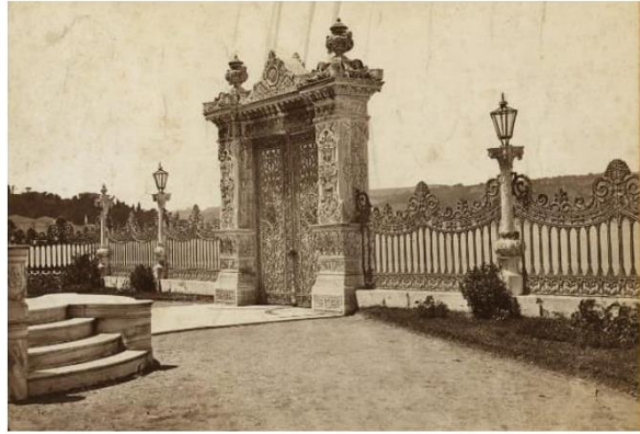
l: Küçük Kasrı'nın kara tarafındaki süslemeli demir kapısı [55]
