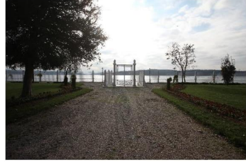
al: Onarım sonrası iskele kapısının hali
