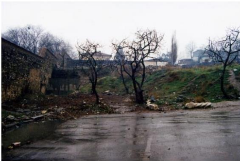
l: Kasrın dış bahçesinin onarım öncesi durumu [61]
