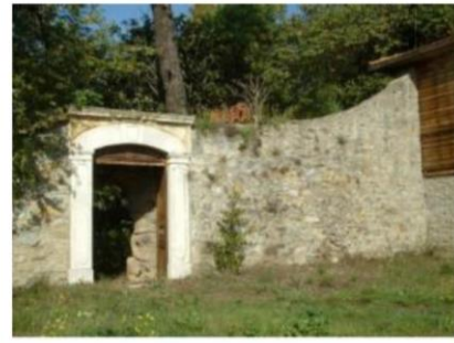
j: Vahdettin Korusu'nda köşkların bahçesini ikiye ayıran duvar ve bahçe kapısı [16]
