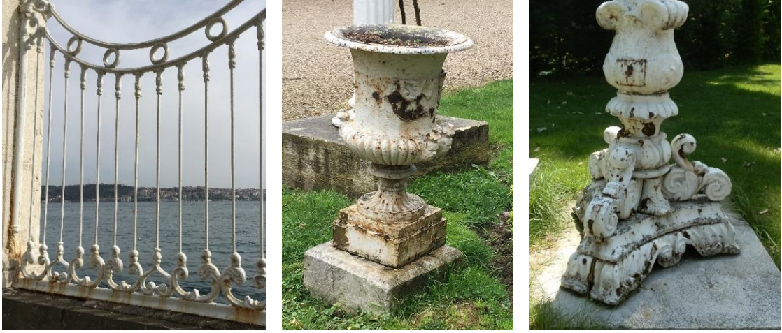
Şekil 3.51 Solda Dolmabahçe Sarayı rıhtımında bulunan paslanmış demir parmaklıklar, ortada Yıldız Sarayı Şale Köşkü bahçesindeki paslanmış demir vazo, sağda Beylerbeyi Sarayı bahçelerinden direkli fener (fenerin kaidesinde yoğun paslanma söz konusudur)
