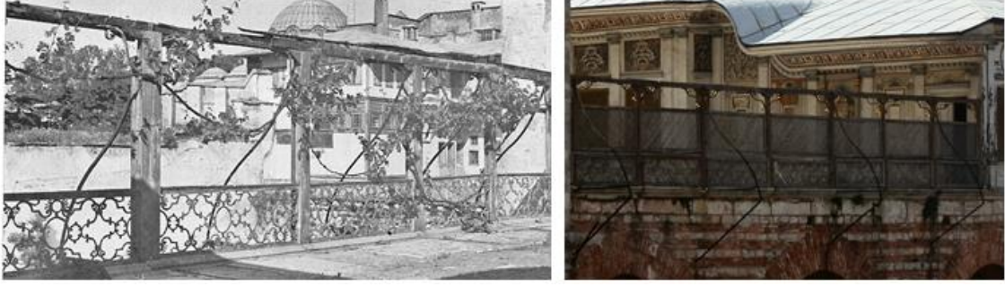
Şekil 2.57 Solda 1973 yılındaki çalışmasında Eldem tarafından Topkapı Sarayı III. Osman asma bahçesinde tespit edilen özgün kafes çerçeveleri [5], sağda aynı bahçede bu kafeslerin yeniden üretilmiş kopyaları
