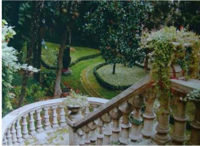
ı: Avusturya Büyükelçiliği Yazlık Konutu bahçelerindeki merdivenlerin detayı
