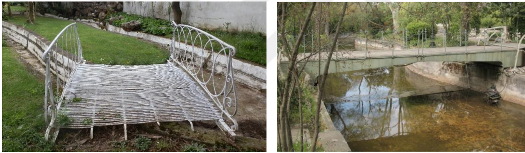
Şekil 2.72 Solda Maslak Kasırları bahçelerindeki demir köprü, sağda Yıldız Sarayı hasbahçesinde bulunan açılıp kapanabilen demir köprü
