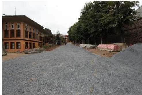
m: Bahçe içindeki yolların onarımı [61]
