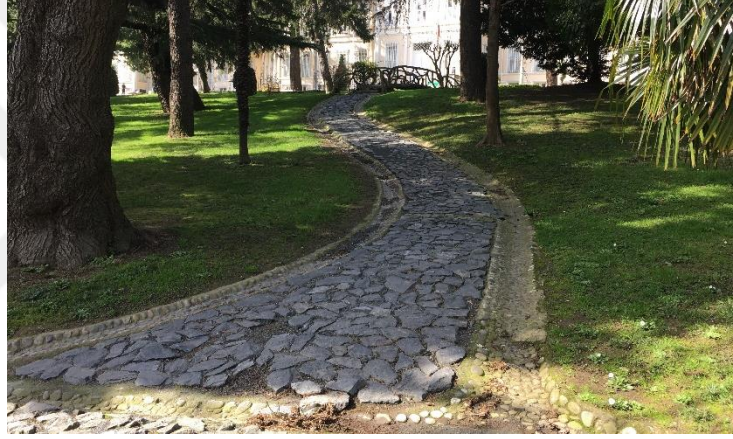
Şekil 3.22 Şekil 3.21’de verilen yer döşemesinin onarım sonrası durumu
