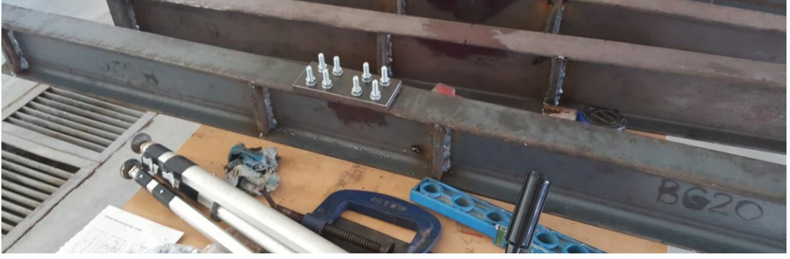
Şekil 4.10 15 cm Uzunluğunda Çelik Plaka Montajı
