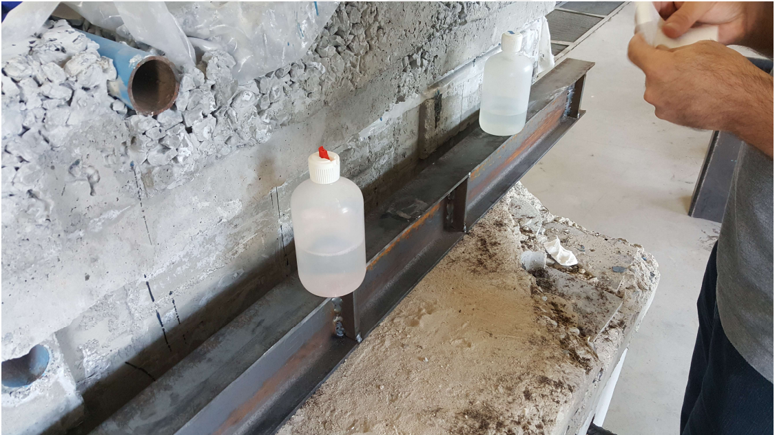
Şekil 3.21 Yüzeyin Strain Gauge Yapıştırmak İçin Hazı Hale Getirilmesi
