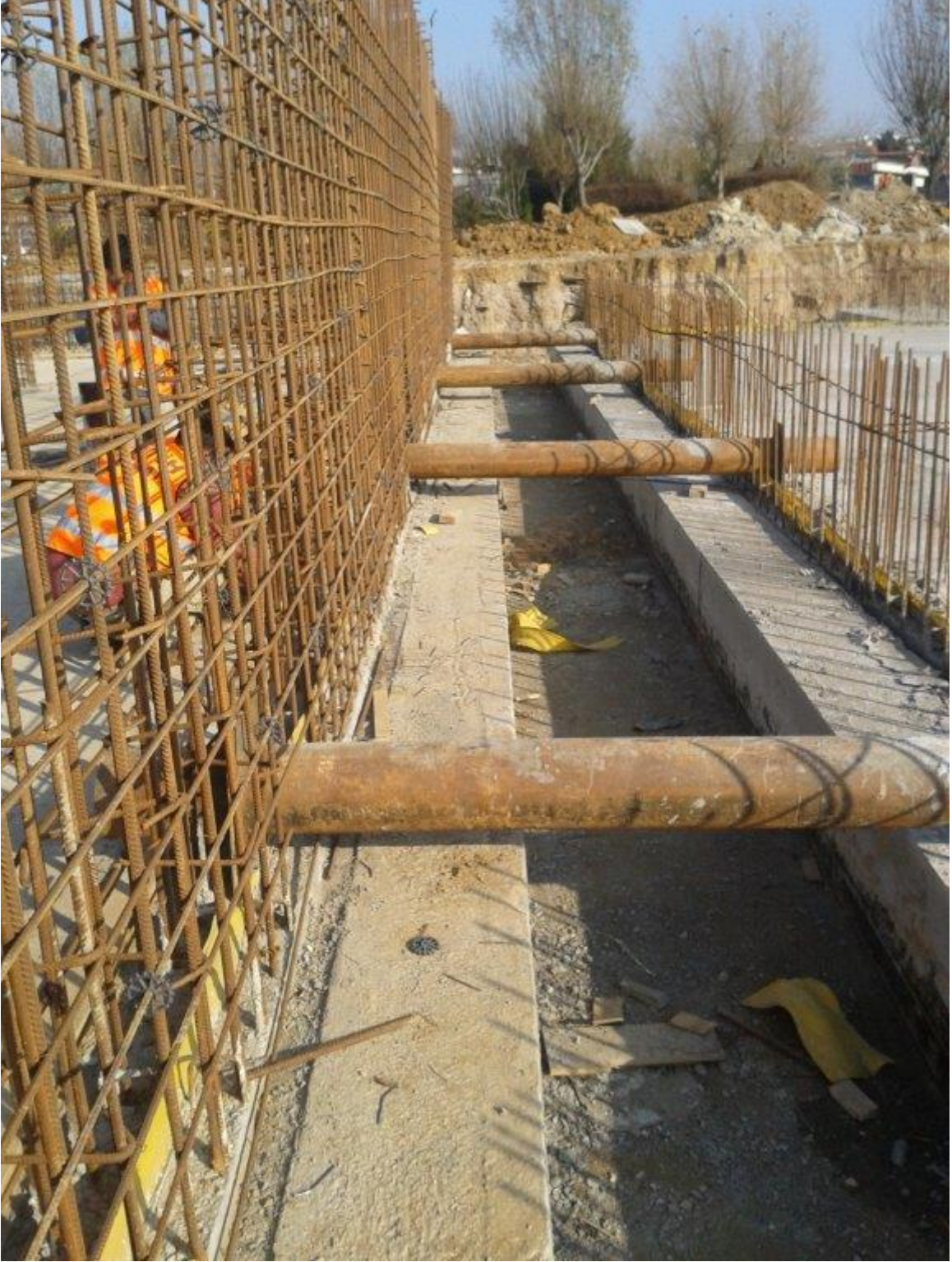
Şekil 4.71 Su Depolarının inşaat safhasına ait bir görünüm. (Depolar arasında bulunan 2 metrelik boşluklar görülmektedir)
