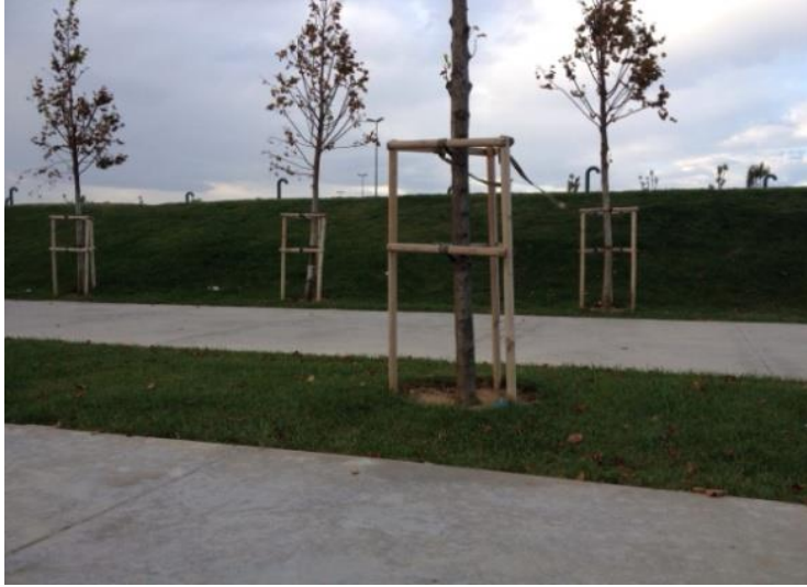
Şekil 4.72 Su Depolarının İmalat sonrasına ait görünüm.
