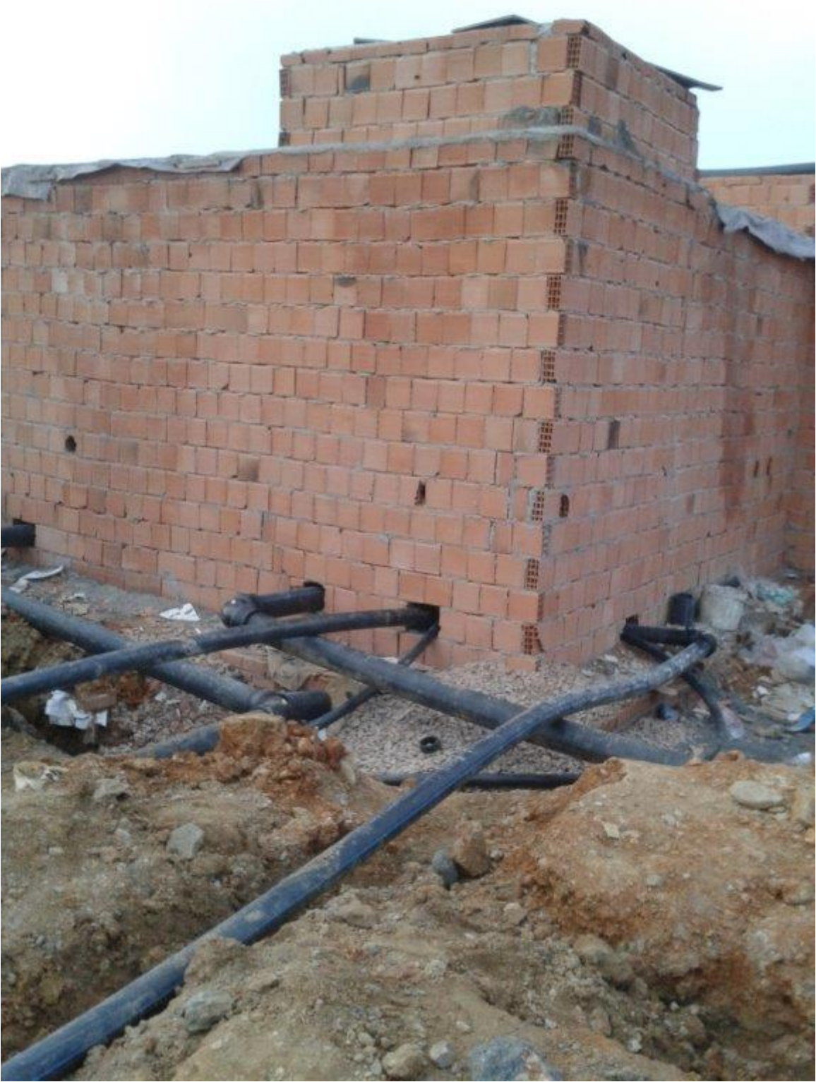
Şekil 4.70 Su Depolarının İmalat Safhasına ait bir görünüm
