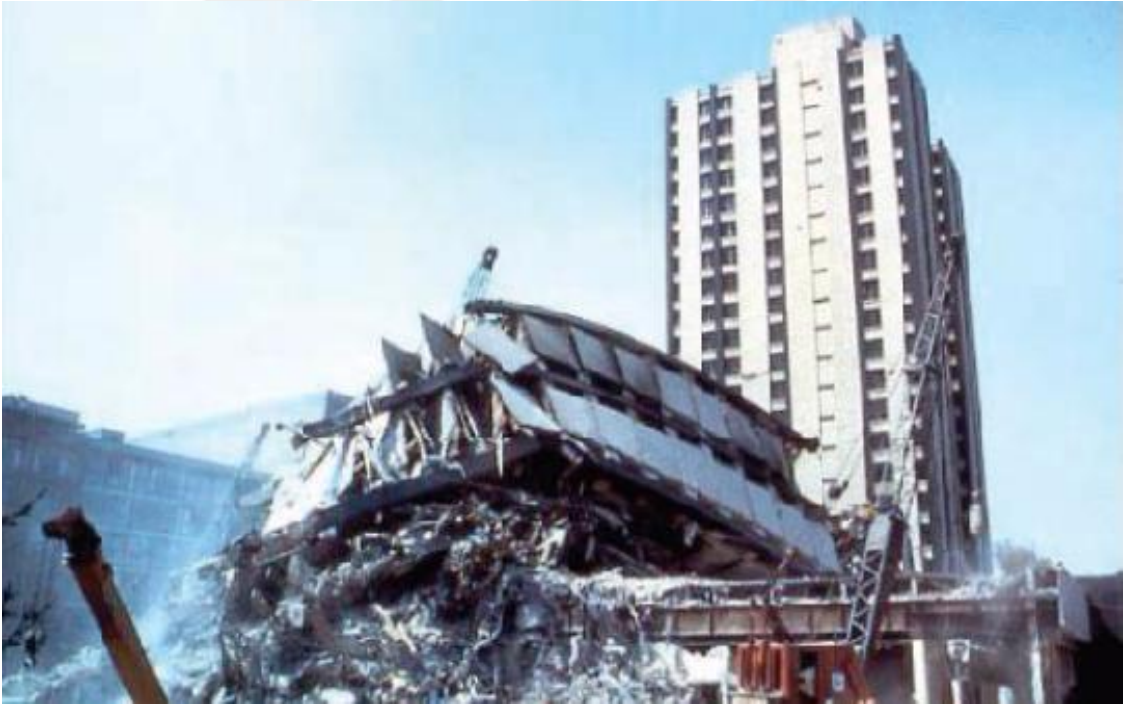
Şekil 4.22 Devrilmiş Piño Suarez apartmanları (Mexico City)
