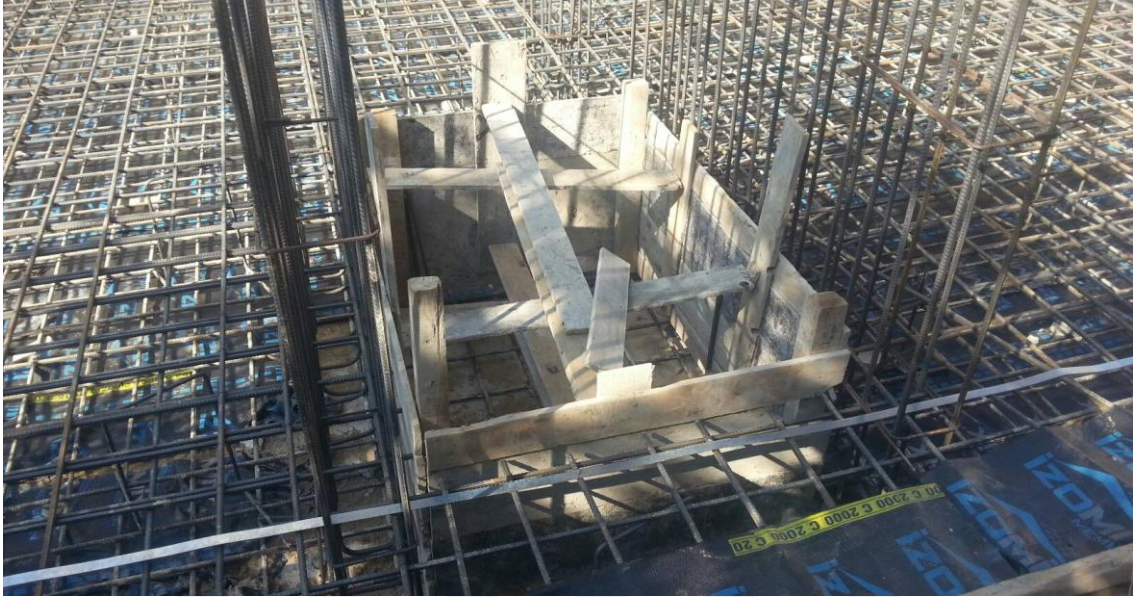
Şekil 4.34 Asansör çukuru teşkili
