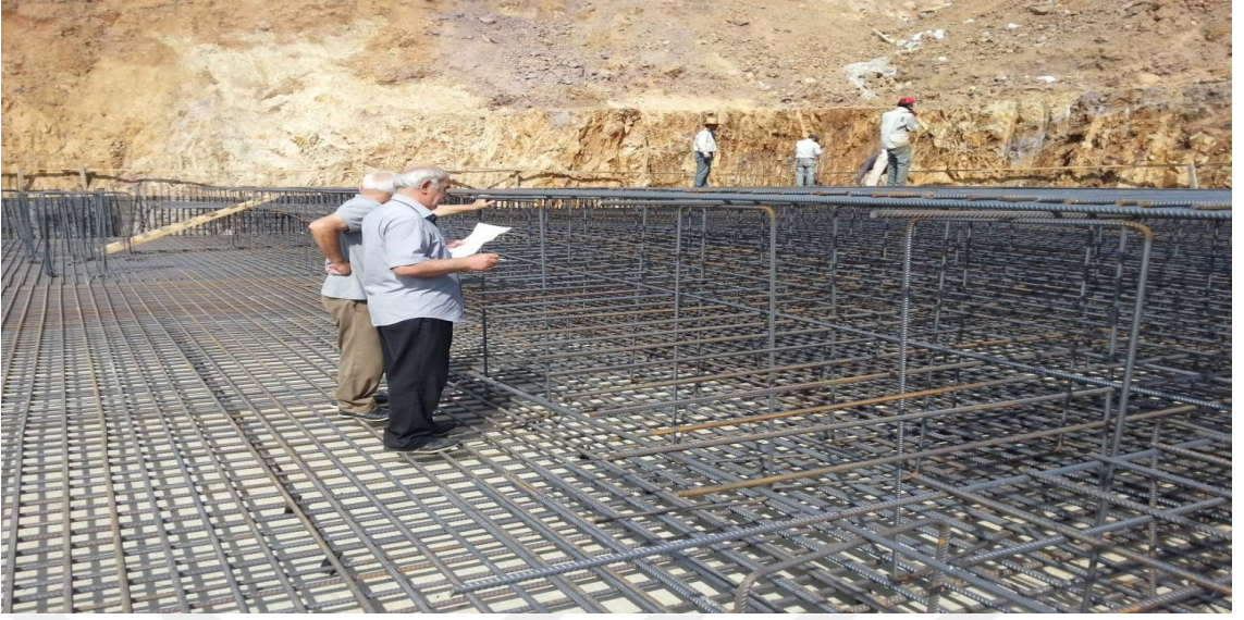
Şekil 4.35 İstanbul, Maltepe'deki bir şantiyede temel çalışmaları
