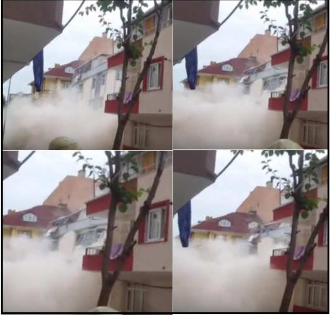
Şekil 4.30 İstanbul Bahçelievler’de yan parselde kazı nedeniyle çöken 7 katlı binadan görüntüler.( 21 Mayıs 2016)
