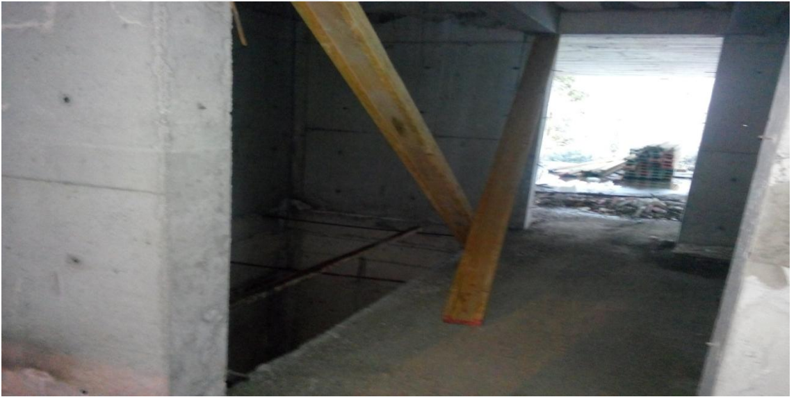
Şekil 3.5 Tahtalarla kapatılan asansör perde boşlukları
