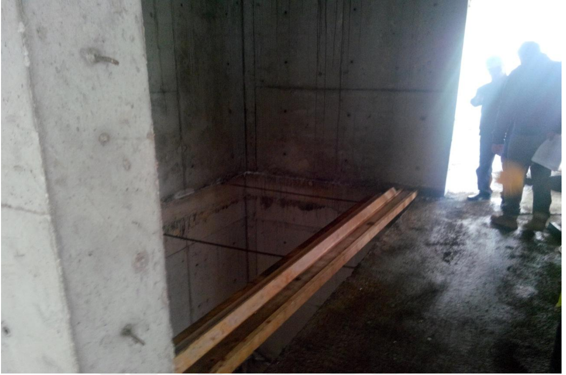
Şekil 3.4 Güvenlik önlemi alınmamış asansör perde boşlukları
