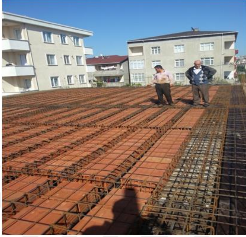
Şekil 4.46 Asmolen döşemelerde, asmolenlerin yönü ve bağlantısı
