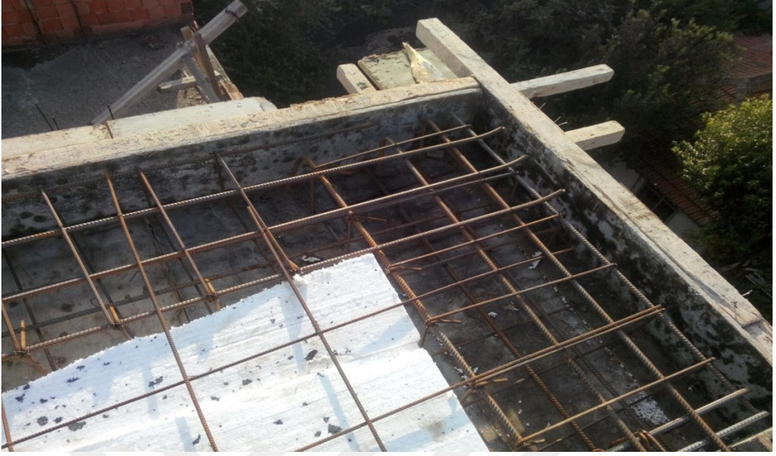
Şekil 4.48 Kirişlerde etriye aralığının ihmali
