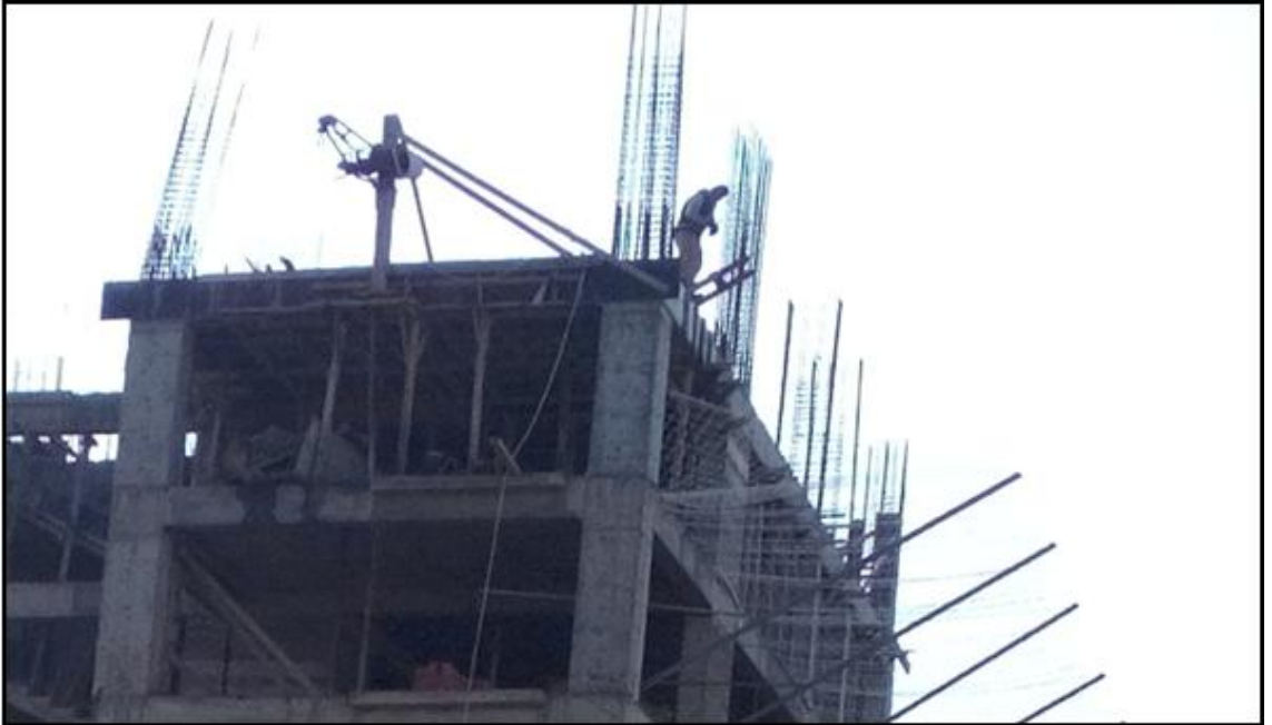
Şekil 3.8 Herhangi bir güvenlik önlemi alınmadan malzeme taşınması işlemi
