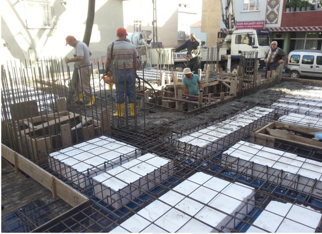
Şekil 4.43 Asmolenlerin aynı hizada ve düzgün yerleşimi
