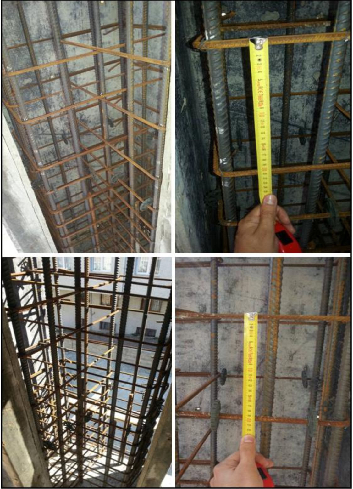
Şekil 4.47 Kolonlarda etriye aralığı tespiti
