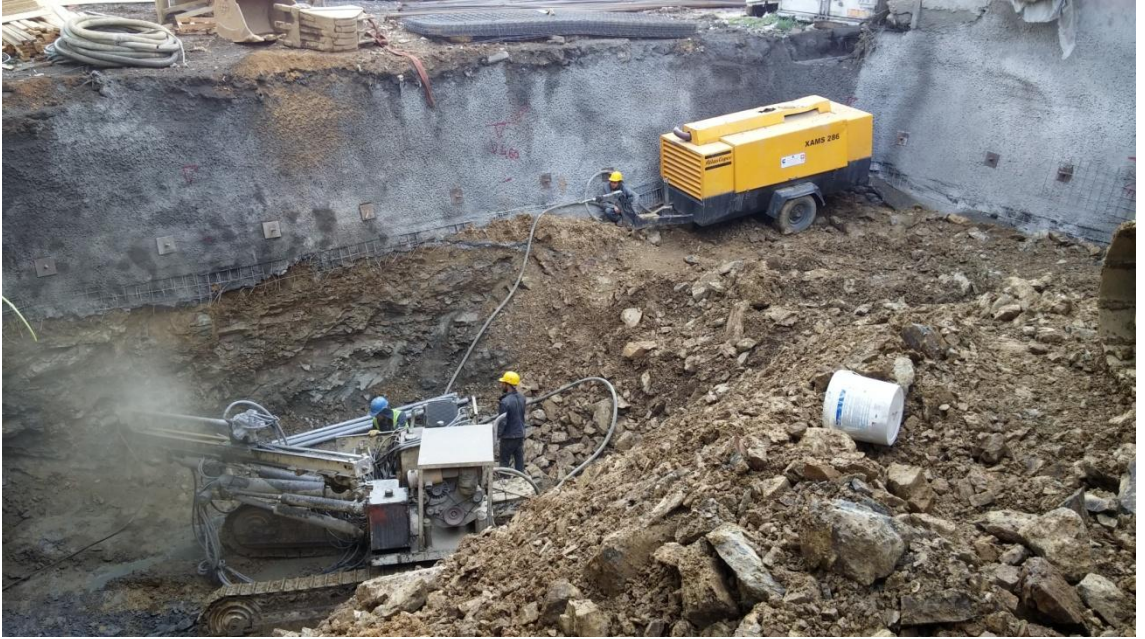
Şekil 4.29 İstanbul, Çekmeköy ilçesindeki bir şantiyenin hafriyat çalışması
