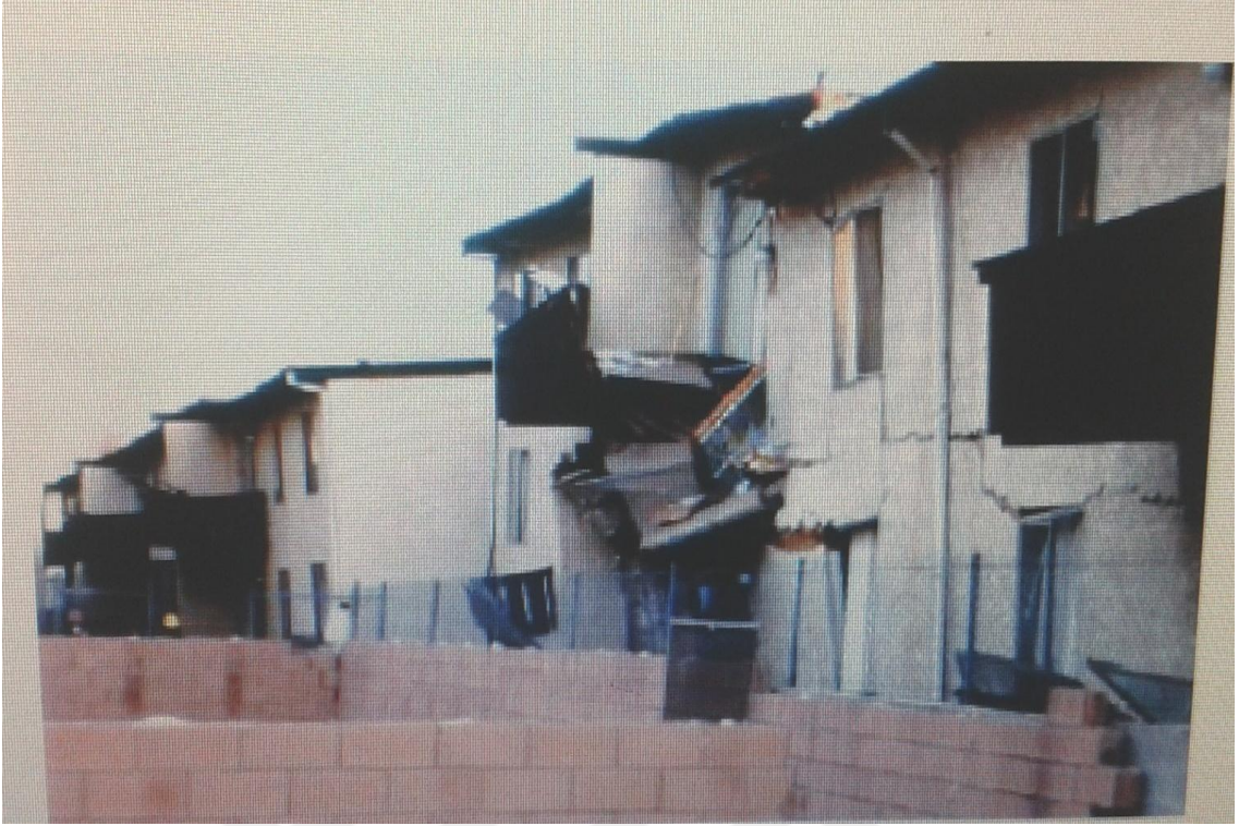
Şekil 4.9 Hasar görmüş bir yapı (Los Angeles, 1994)
