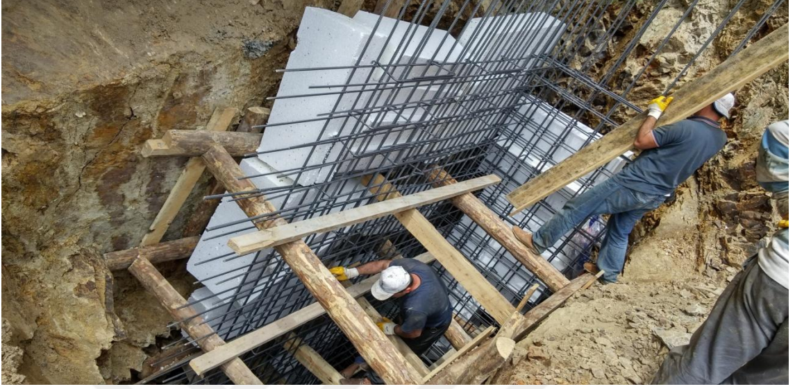
Şekil 4.31 Kuyu temel çalışmalarından bir kesit
