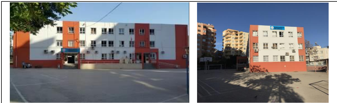
Şekil 5. 4 Ramazanoğlu Ortaokulu (RO)
