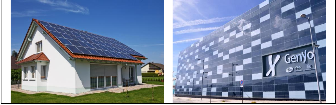
Şekil 3. 17. a) Binaya sonradan ilave FV sistem [77] b) Binayla bütünleşik FV sistem [78]
