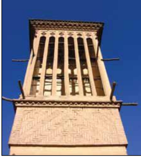
Şekil 3.9 Yazdeki bir Badgirin (rüzgar kulesi) Pervez cephesi [66]
