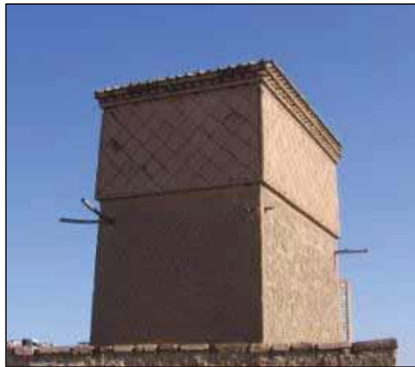
Şekil 3.7 Yazd'de yıkılmış bir Badgir (rüzgar kulesi) baca, ayak ve katgütü [67]
