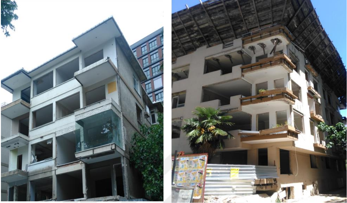
Şekil 4. 8 Riskli bina yıkımı öncesi (T0) ve bina yıkımı sırası (T1)
