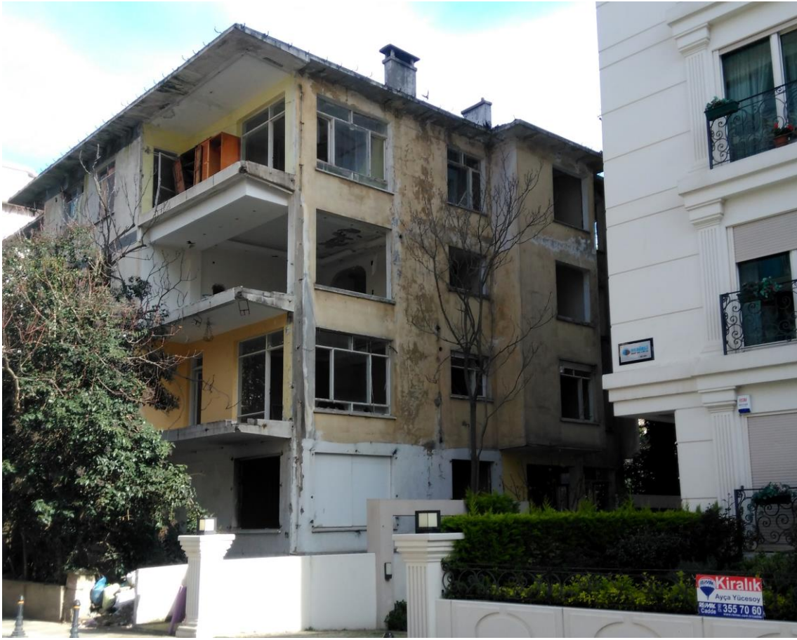
Şekil 2. 3 Kadıköy’de yıkılacak riskli bina görünümü
