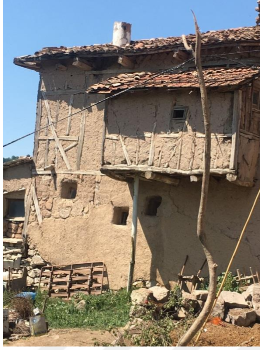
Şekil 4. 22 Arif Ergün evine ait ıslak hacim çıkması (Didem Baran Ergül 2018)
