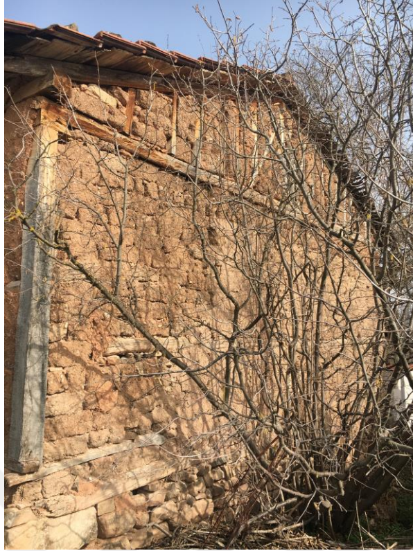
Şekil 4. 17 Yığma kerpiç yapıda hatıl ve döşeme detay görünüşü (Didem Baran Ergül 2018)
