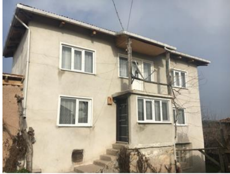
Şekil 4. 46 Nurhan Özsoy evi giriş cephesi (Didem Baran Ergül 2018)
