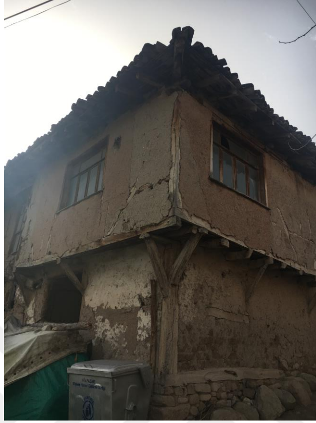
Şekil 4. 13 Hımsı duvar tekniği ile üretilen terkedilmiş ev (Didem Baran Ergül 2018)
