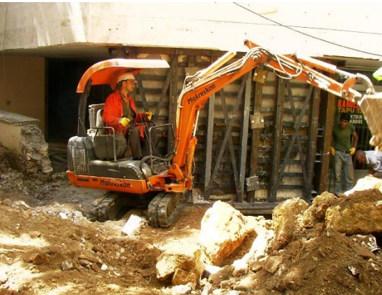
Şekil 3. 14 Hasar gören perdenin güçlendirilmesi için çelik profiller ile sarılması
