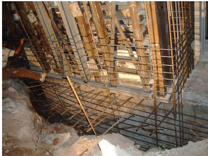
Şekil 3. 14 Hasar gören perdenin güçlendirilmesi için eklenen donatılar ve beton dökümü (devam...)
