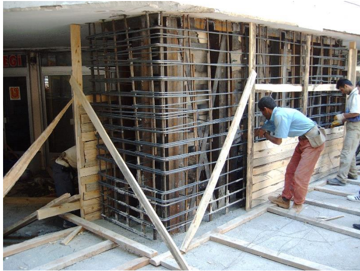
Şekil 3. 15 Hasar gören perdenin güçlendirilmesi için eklenen donatılar ve beton dökümü
