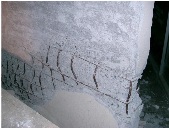
Şekil 3. 12 Hasar gören perdenin hasar görünüşleri
