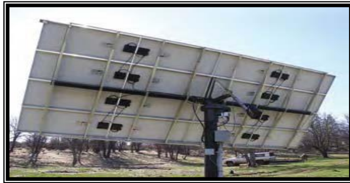
Şekil 5.3 Elektrik prensipli STS
