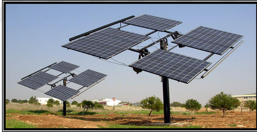
Şekil 5.4 Tek eksenli elektrik prensipli STS [37]
