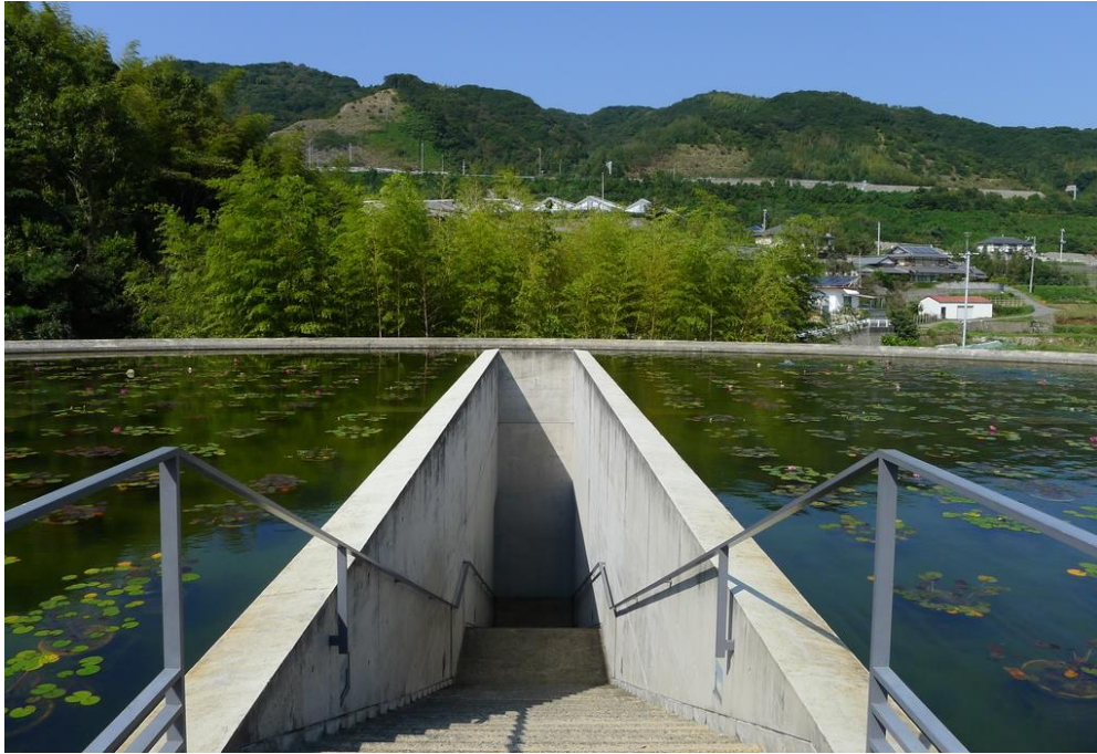
Şekil 5.1 1 no'lu video görüntüsü Water Temple yapısı süs havuzu
