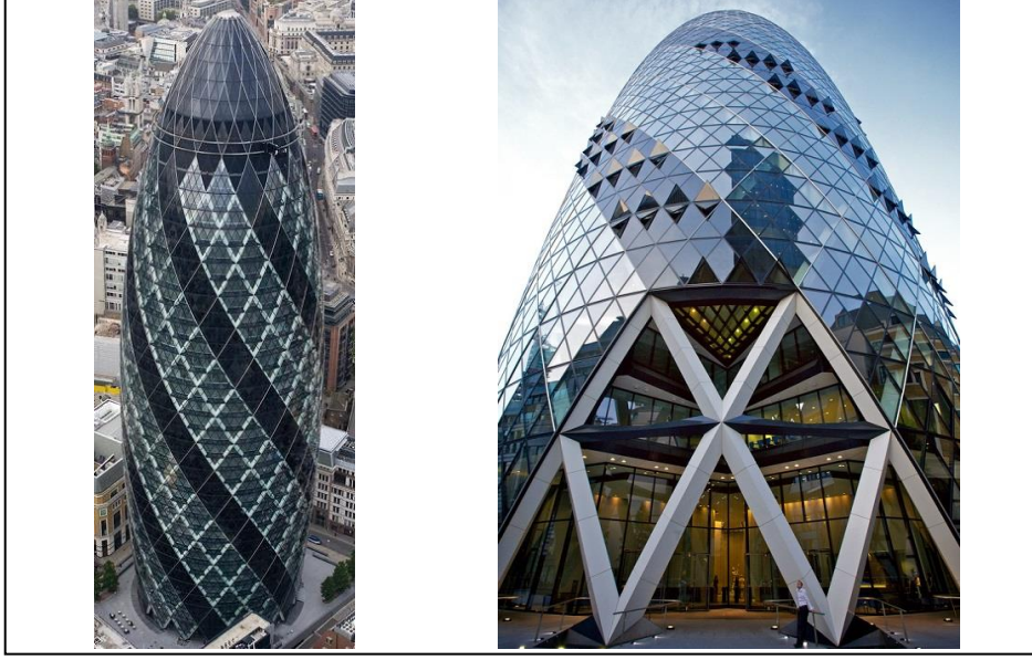
Şekil 3.4 Çift Tabakalı Cephe, Swiss Re Merkez Binası, Londra [83]
