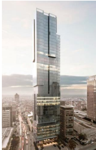
Şekil 2.24 Zorlu Levent Tower, İst. [63]
