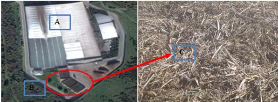
Şekil 4.11 Kompost ve Geri Dönüşüm Tesisi Genel Görünümü, B- Gerçek ölçekli açık yatak biyofiltre ünitesinin (3 adet filtre) tesis alanında konumu C- Biyofiltre ünitesinde örnekleme yapılan dolgu malzemesi
