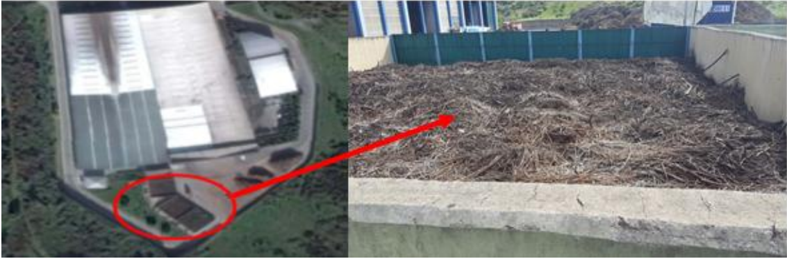
Şekil 4.2 Gerçek ölçekli açık yatak biyofiltre ünitesinin (3 adet) tesis alanında konumu ve dıştan görünümü
