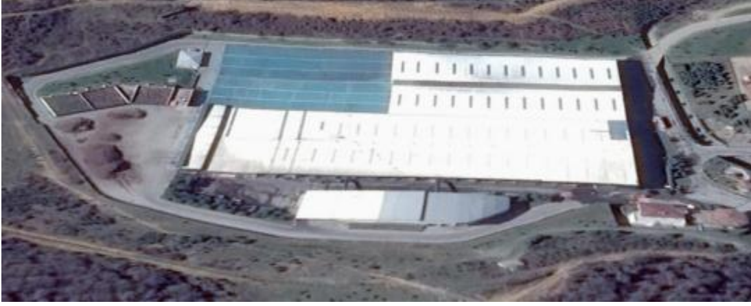
Şekil 4.1 Kemerburgaz Kompost ve Geri Kazanım Tesisi genel görünümü
