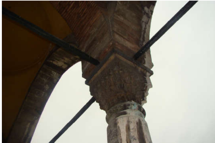
Şekil 5. 21 Fatih Tabhanesi sütun bileziğinde oluşmuş korozyon [Y. Örs, 2010]
