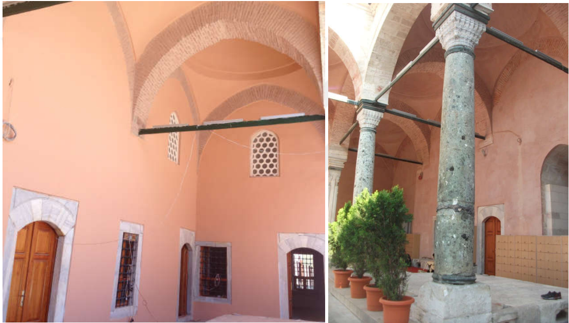
Şekil 5. 76 Fatih Tabhanesi revakları restorasyon sonrası görünüm [Y. Örs, 2017]
