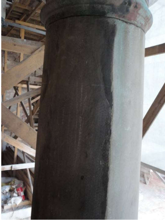
Şekil 5. 63 Fatih Tabhanesi mermer yüzeylerin jel ile temizliği [Y. Örs, 2012]
