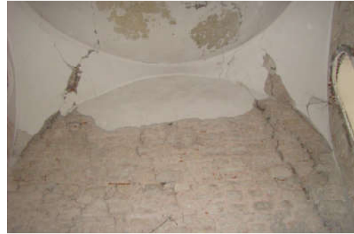
Resim 2. Kubbe ve duvardaki çatlaklar.
