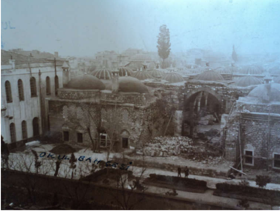
Şekil 5. 8 1766 depremi sonrası ana eyvanın yıkılmış durumu [108]
