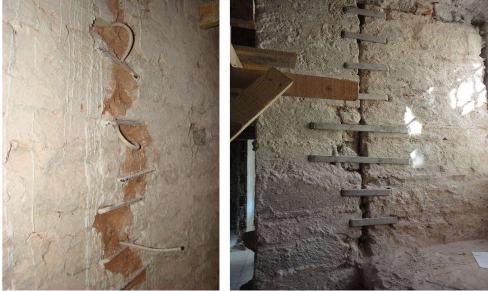
Şekil 5. 55 Fatih Tabhanesi enjeksiyon ve kenet uygulaması [Y. Örs, 2011]
