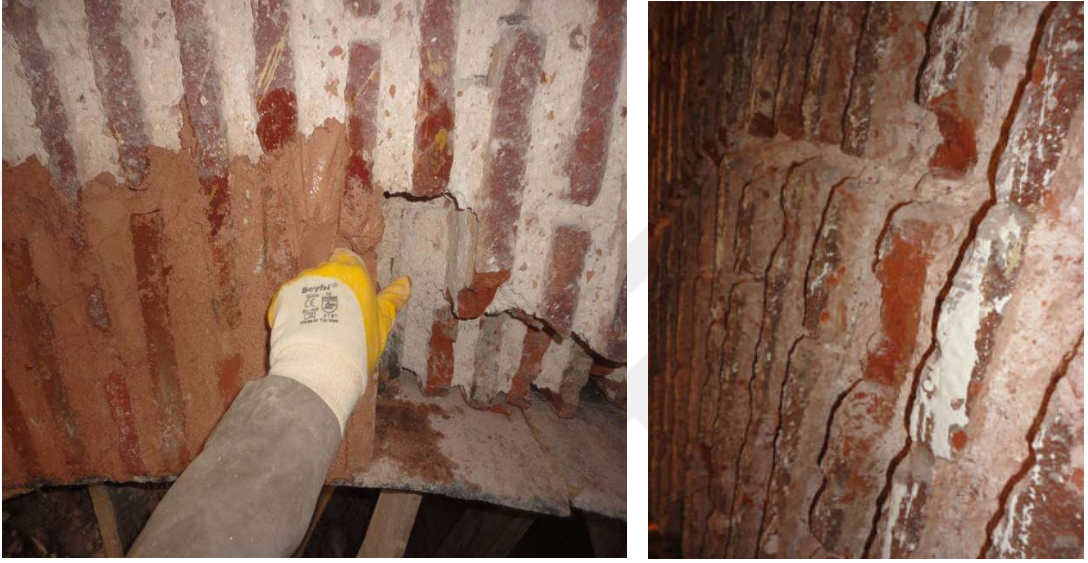
Şekil 5. 73 Fatih Tabhanesi revak kemerleri tuğla tümleme ve derz açılması [Y. Örs, 2011]
