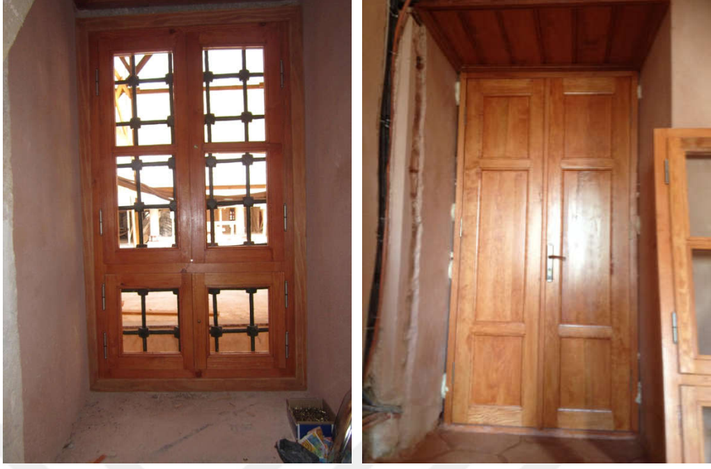
Şekil 5. 81 Fatih Tabhanesi odalarına yeni kapı pencere yapılması [Y. Örs, 2012]
