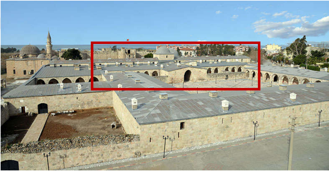
Şekil 4. 67 Payas Sokullu Mehmet Paşa Tabhane batı cephesi [93]
