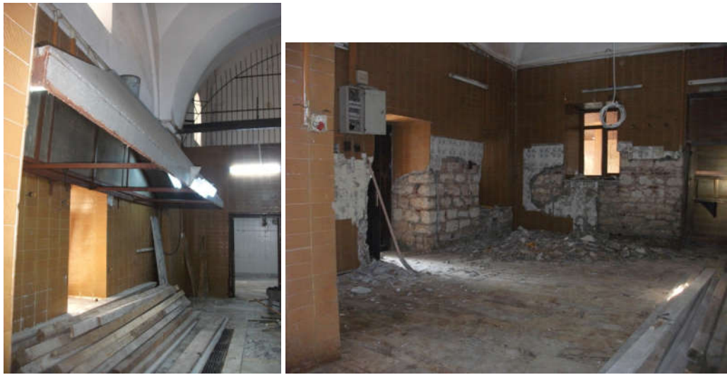
Şekil 5. 65 Fatih Tabhanesi mutfak mekânının niteliksiz ek ve malzemelerden arındırılması [Y. Örs, 2015]
