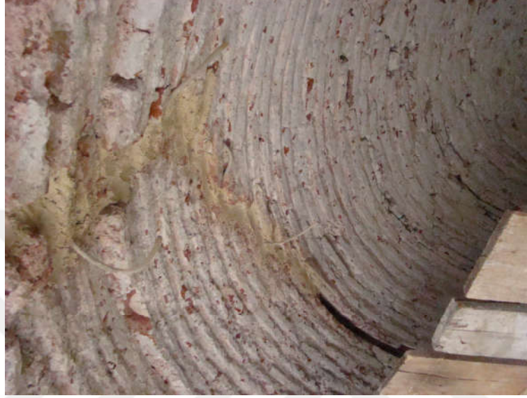
Şekil 5. 54 Fatih Tabhanesi enjeksiyon uygulaması [Y. Örs, 2011]
