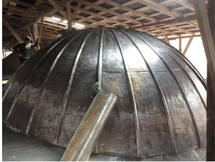
Şekil 5. 58 Fatih Tabhanesi kurşun kaplama yapılması [Y. Örs, 2012]
