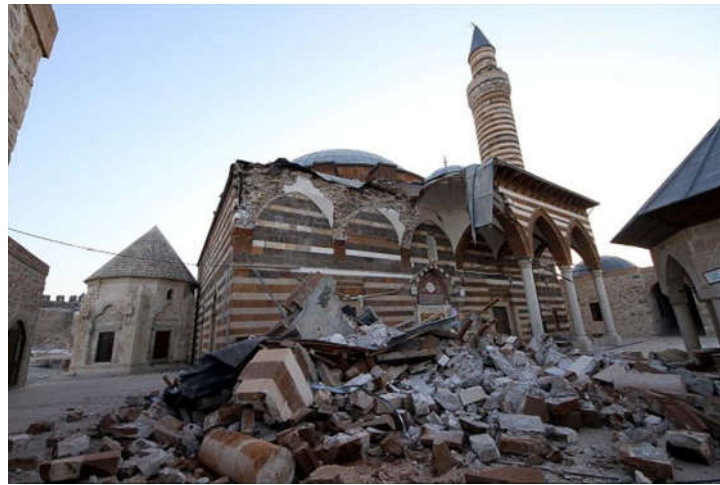
Şekil 5. 1 2011 Van depremi sonrası tarihi caminin uğradığı hasar durumu [100]
