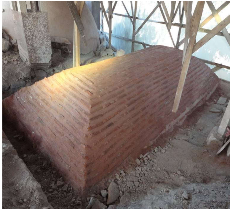
Şekil 5. 71 Fatih Tabhanesi Z18 mekânı tonoz örülmesi [Y. Örs, 2011]
