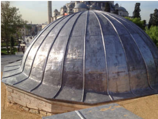
Şekil 5. 83 Fatih Tabhanesi çatısında yer alan kubbelere yönelik uygulamalar [Y. Örs, 2012]
