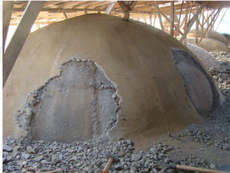
Şekil 5. 48 Fatih Tabhanesi kubbe üzerinde yer alan demirli beton [Y. Örs, 2010]
