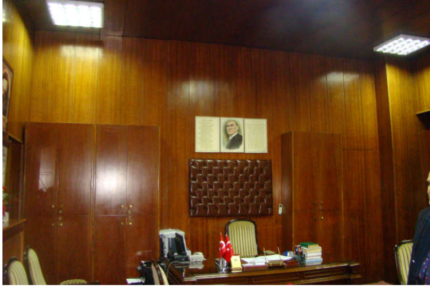
Şekil 5. 40 Fatih Tabhanesi Z19 asma tavan ve duvar kaplamaları [Y. Örs, 2011]
