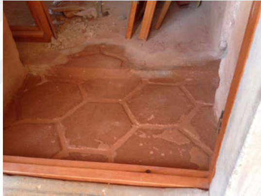
Şekil 5. 77 Fatih Tabhanesi odaların çimentolu sıva ve niteliksiz malzemelerden arındırılması [Y. Örs, 2011]
