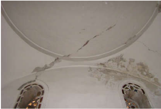
Resim 2. Kubbe ve duvardaki çatlaklar.
