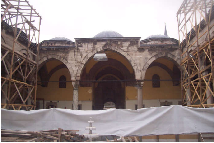
Resim 1. Binanın inceleme tarihindeki görünümü.
