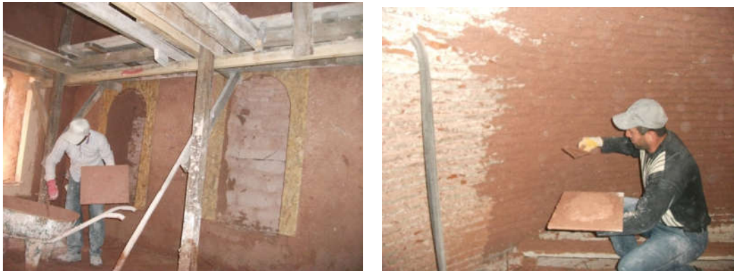
Şekil 5. 79 Fatih Tabhanesi odaların duvar ve kubbelerine sıva yapılması [Y. Örs, 2017]
