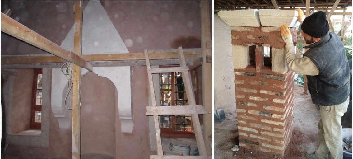
Şekil 5. 66 Fatih Tabhanesi yeniden yapılan yaşmak ve bacalar [Y. Örs, 2017]
