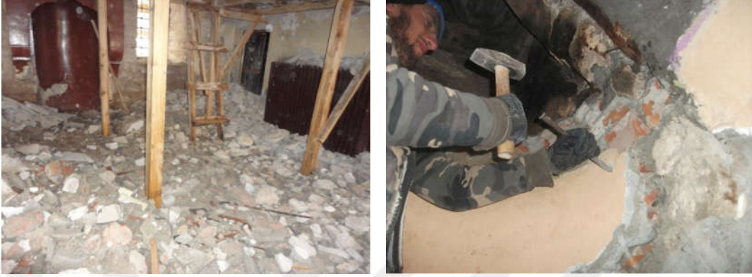
Şekil 5. 77 Fatih Tabhanesi odaların çimentolu sıva ve niteliksiz malzemelerden arındırılması [Y. Örs, 2011]
