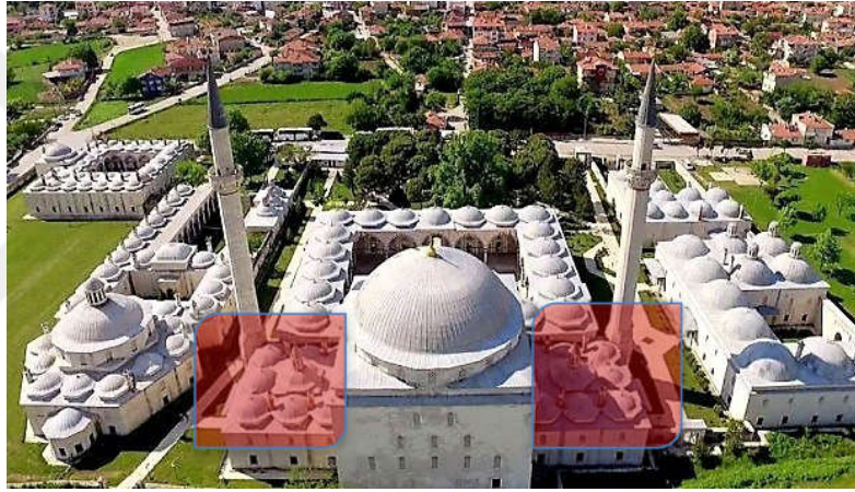
Şekil 2. 23 Edirne II. Beyazid Cami ve Külliyesi [33]
