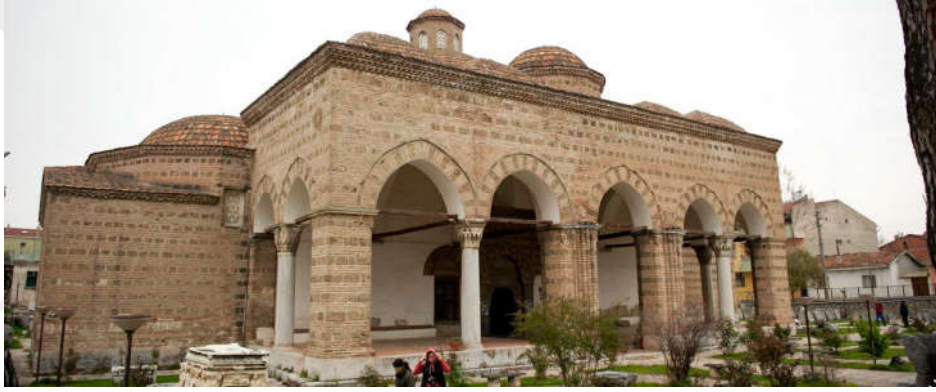
Şekil 3. 2 Nilüfer Hatun İmaretî giriş cephesi [38]
