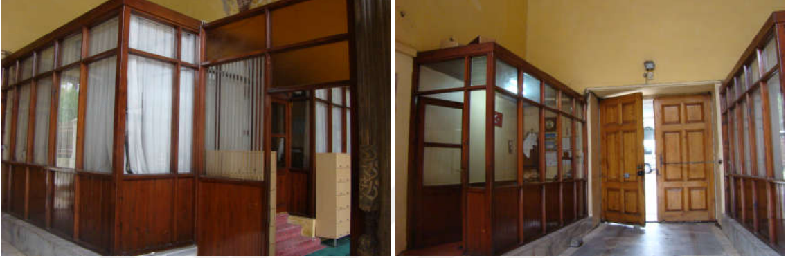
Şekil 5. 41 Fatih Tabhanesi dođu yan eyvan özgün olmayan giriş kapısı ve niteliksiz yapılar [Y. Örs, 2010]
