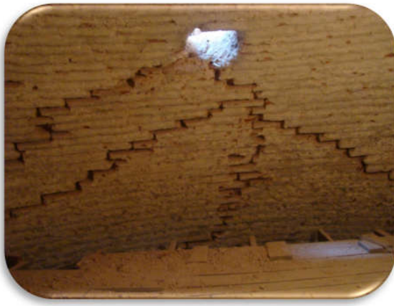
Şekil 5. 13 Fatih Tabhanesi revak kubbeleri ve duvarlarındaki yapısal çatlaklar [Y. Örs, 2011]
