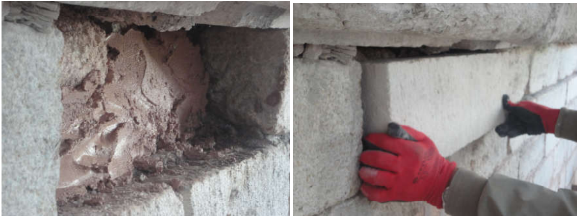
Şekil 5. 59 Fatih Tabhanesi taş çürütülmesi ve yeni taş konulması [Y. Örs, 2012]
