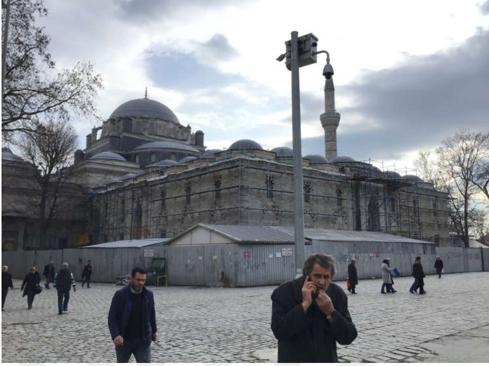
Şekil 3. 42 II. Beyazid Cami avlu giriş cephesi [Y. Örs, 2019]
