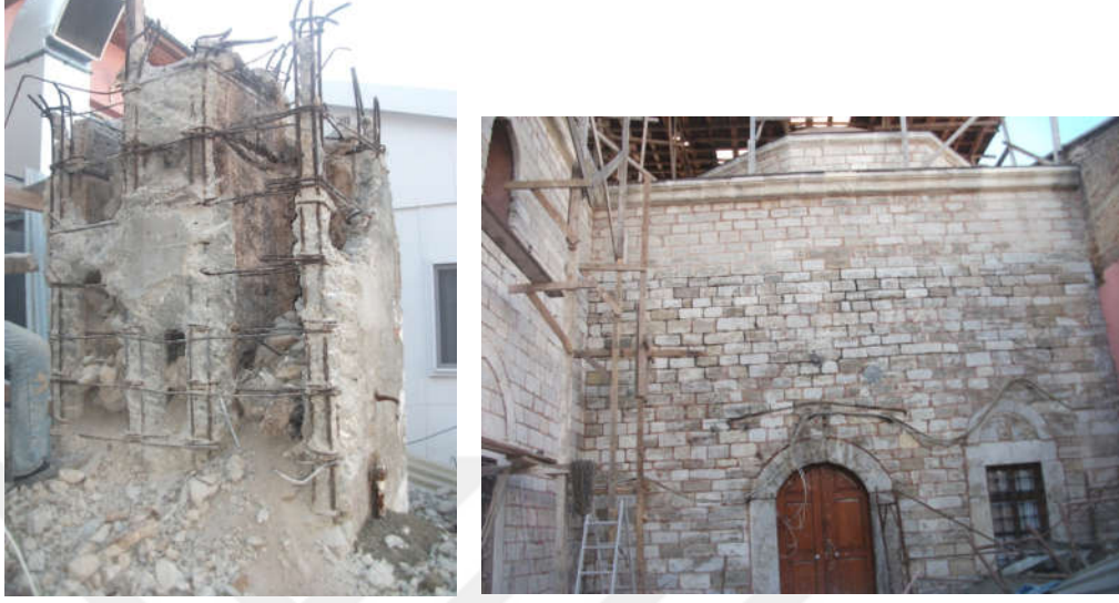
Şekil 5. 64 Fatih Tabhanesi giriş avlusunda yer alan niteliksiz sundurma ve bacanın kaldırılması [Y. Örs, 2017]
