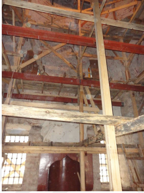
Şekil 5. 72 Fatih Tabhanesi Z19 mekânı asma tavanın kaldırılması [Y. Örs, 2011]
