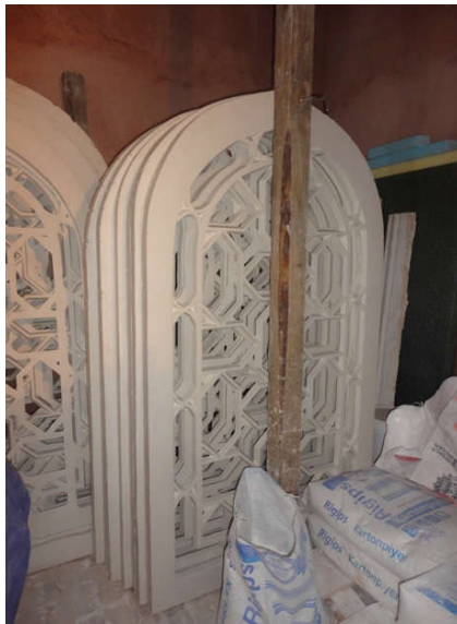
Şekil 5. 80 Fatih Tabhanesi içlik ve dışlık pencere (revzen) yapılması [Y. Örs, 2012]
