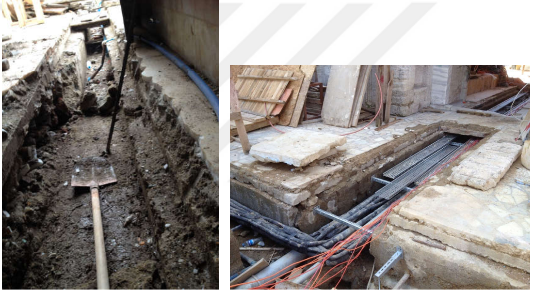
Şekil 5. 88 Fatih Tabhanesi tesisat kanalları kazılması ve borulama sistemi [Y. Örs, 2016]
