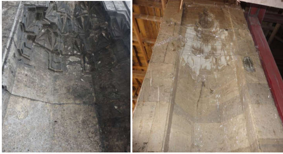
Şekil 5. 86 Fatih Tabhanesi cephelerinde kağıt hamuruyla temizlik yapılması [Y.Örs, 2016]
