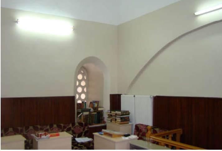
Şekil 5. 32 Fatih Tabhanesi Z17 mahali asma kat lambri duvar kaplaması ve kapatılmış kapı boşluğu [Y. Örs, 2010]
