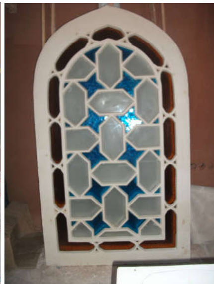
Şekil 5. 80 Fatih Tabhanesi içlik ve dışlık pencere (revzen) yapılması [Y. Örs, 2012]
