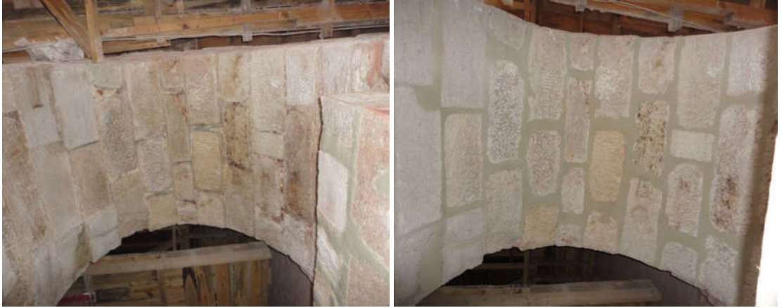
Şekil 5. 74 Fatih Tabhanesi revak kemerleri derz açılması ve yapılması [Y. Örs, 2011]
