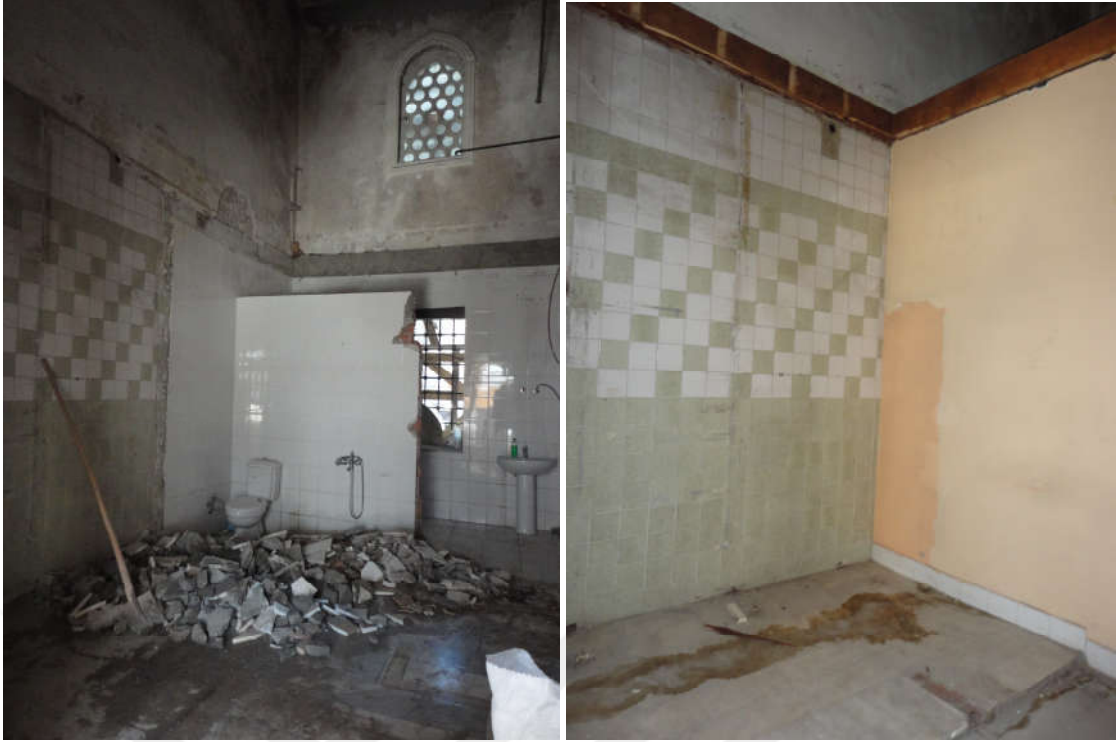
Şekil 5. 39 Fatih Tabhanesi Z18 niteliksiz malzeme ve ekler [Y. Örs, 2010]
