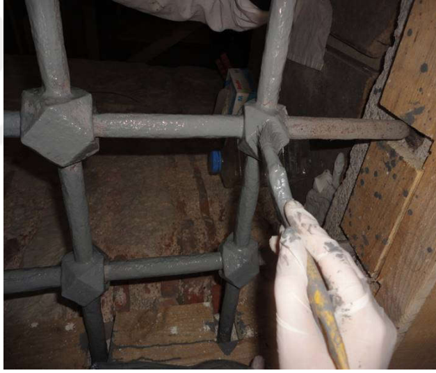
Şekil 5. 82 Fatih Tabhanesi lokmalı demir parmaklıkların konservasyonu [Y. Örs, 2012]
