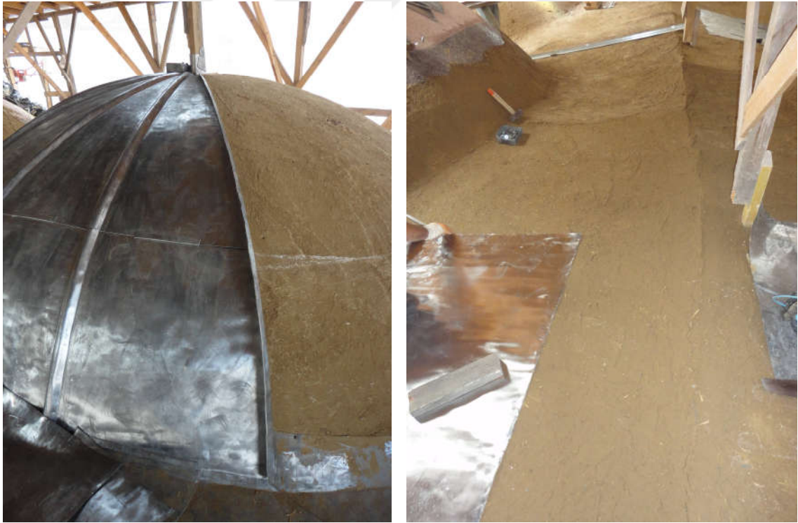
Şekil 5. 57 Fatih Tabhanesi çamur sıva ve kurşun kaplama yapılması [Y. Örs, 2012]
