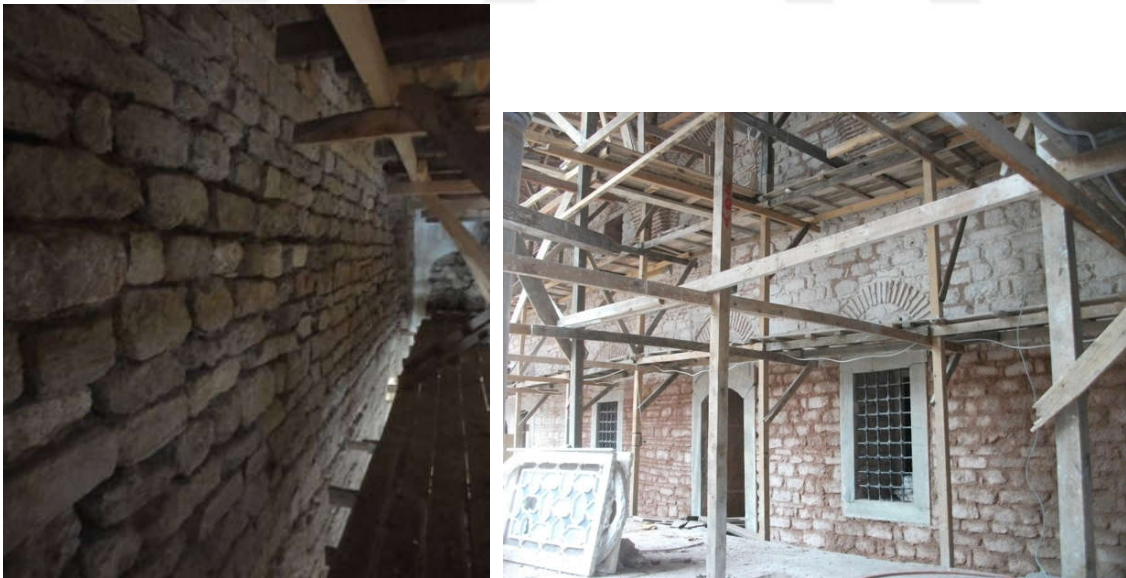
Şekil 5. 84 Fatih Tabhanesi cephelerinde derz açılması [Y. Örs, 2016]
