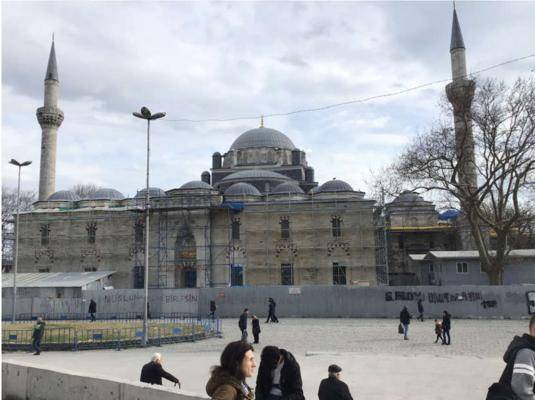
Şekil 3. 41 II. Beyazid Cami avlu giriş cephesi [Y. Örs, 2019]
