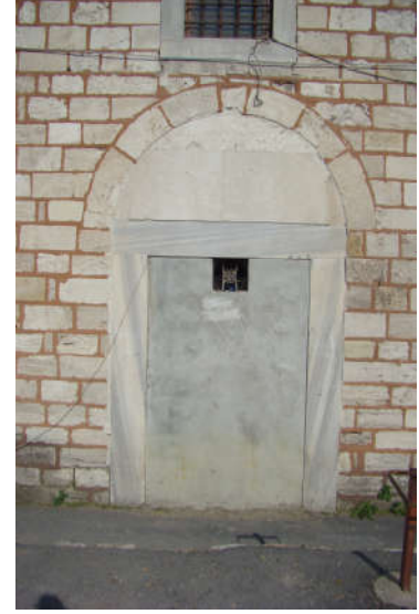
Şekil 5. 32 Fatih Tabhanesi Z17 mahali asma kat lambri duvar kaplaması ve kapatılmış kapı boşluğu [Y. Örs, 2010]
