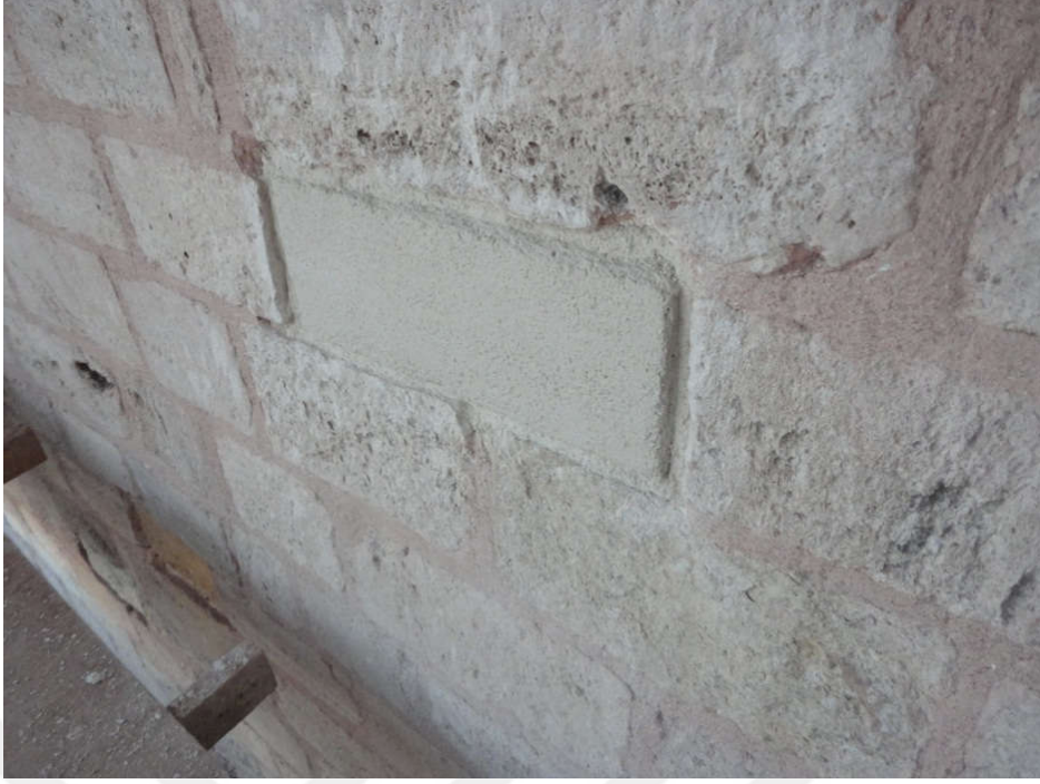
Şekil 5. 60 Fatih Tabhanesi plastik onarım harcı ile yapılan tümleme [Y. Örs, 2012]
