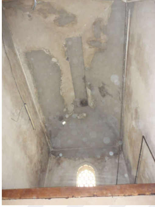
Şekil 5. 10 Doğudaki hizmet mekânının betonarme tonozu [Y. Örs, 2011]
