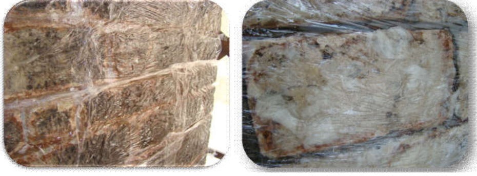
Şekil 5. 61 Fatih Tabhanesi taş yüzeylerin kâğıt hamuru ile temizliği [Y. Örs, 2012]
