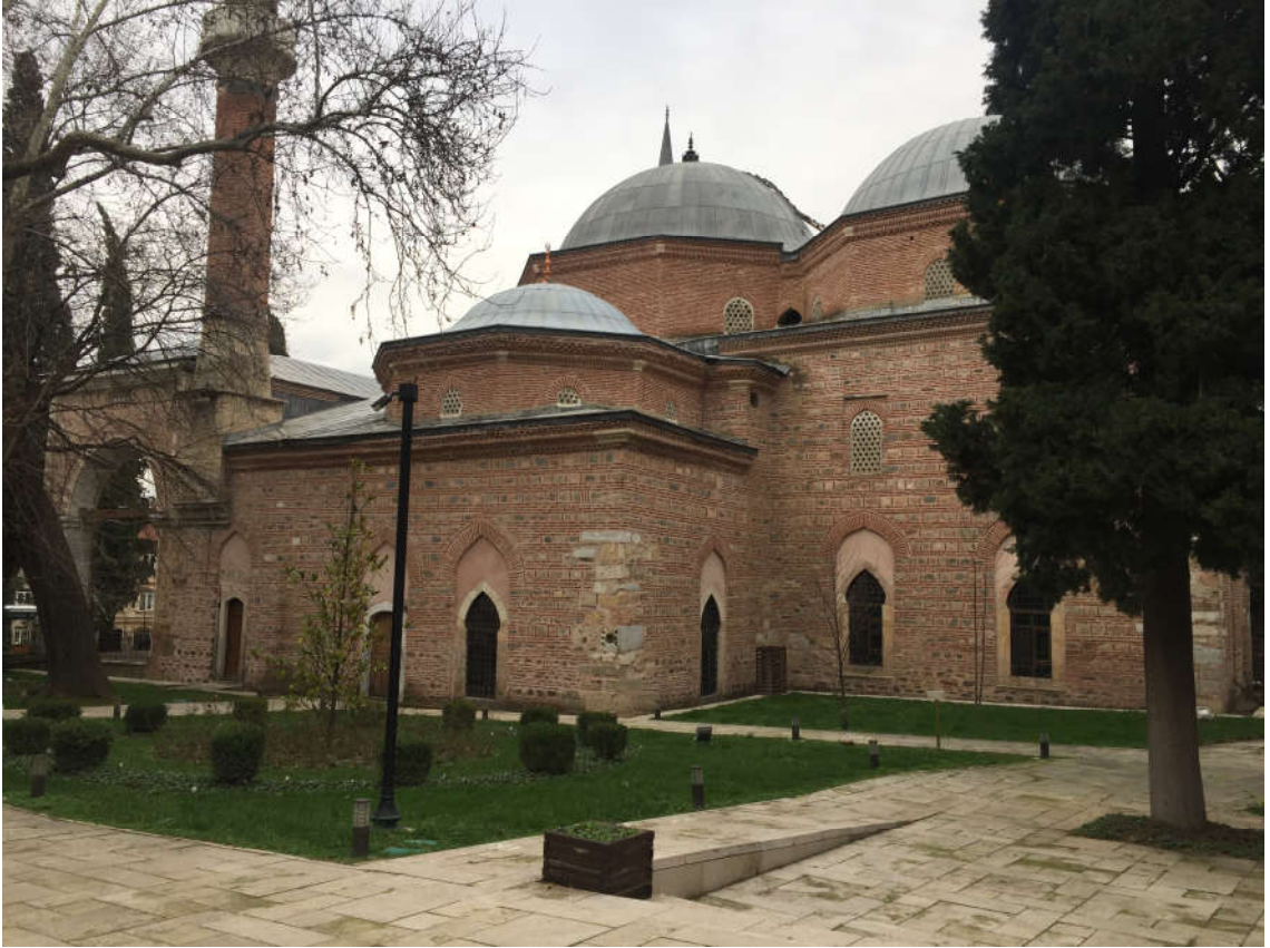
Şekil 3. 21 Muradiye Cami güney cephesi [Y. Örs, 2019]
