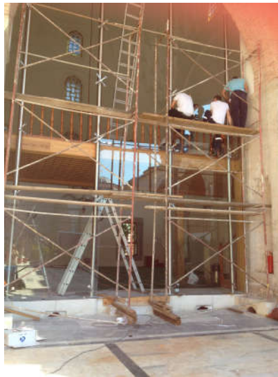
Şekil 5. 70 Fatih Tabhanesi ana eyvan girişinin cam ile kapatılması [Y. Örs, 2017]
