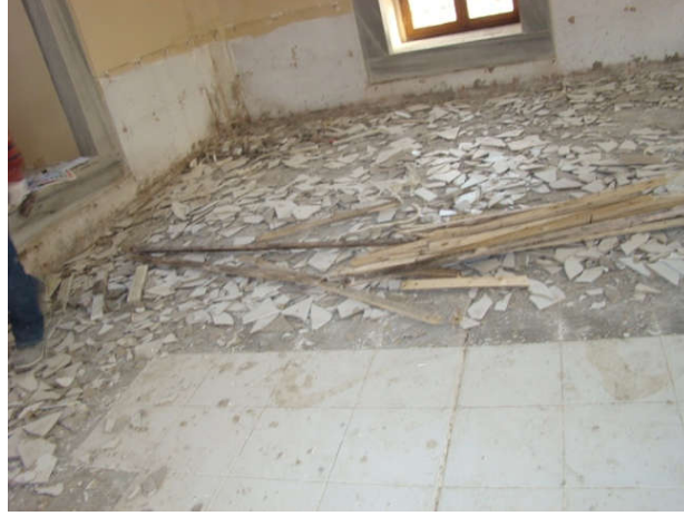
Şekil 5. 68 Fatih Tabhanesi ana eyvan yer niteliksiz döşemesi sökülmesi [Y. Örs, 2011]
