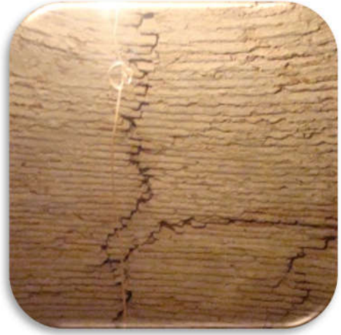
Şekil 5. 13 Fatih Tabhanesi revak kubbeleri ve duvarlarındaki yapısal çatlaklar [Y. Örs, 2011]
