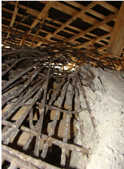
Şekil 5. 9 Ana eyvan betonarme kubbe [Y. Örs, 2011]
