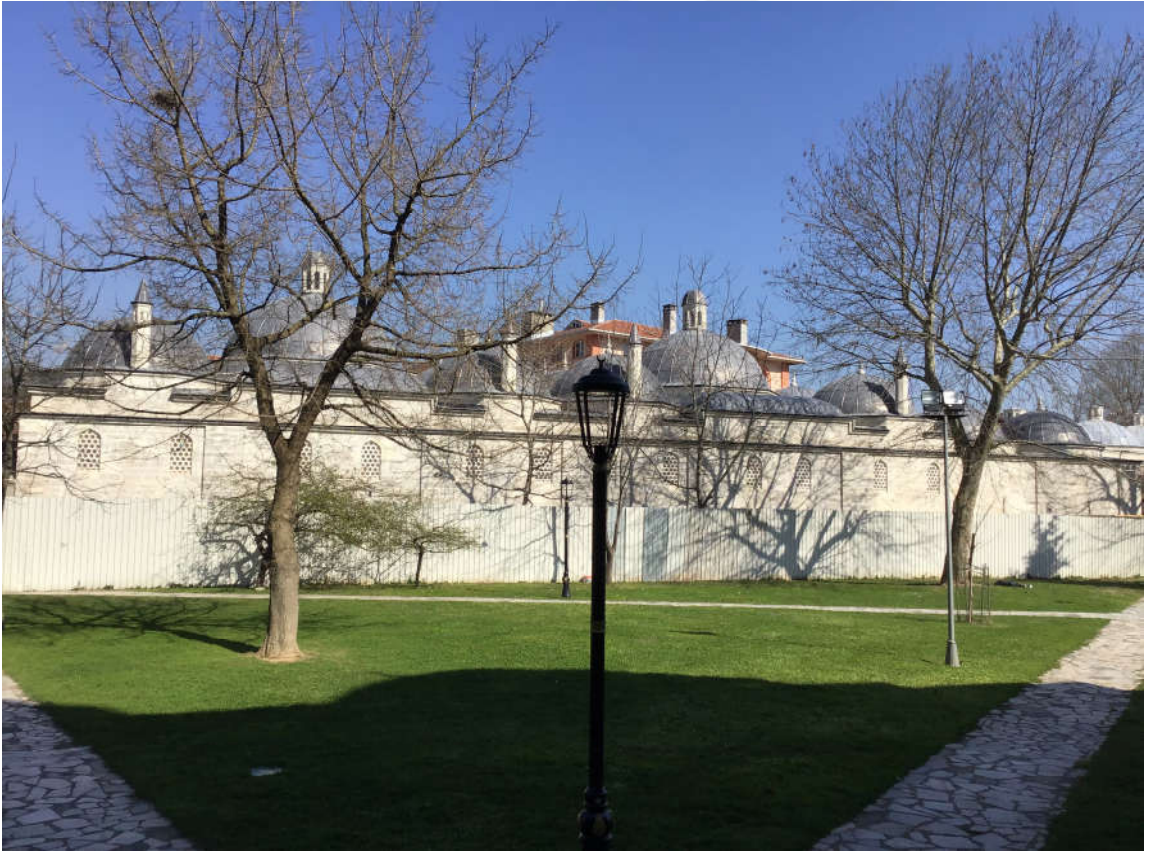
Şekil 4. 41 Şehzade Mehmet Külliyesi Tabhanesi batı cephesi [Y. Örs, 2019]
