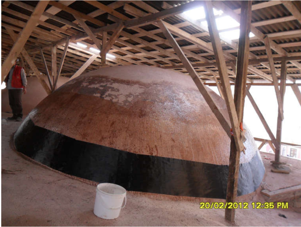
Şekil 5. 56 Fatih Tabhanesi karbon fiber (FRP) uygulaması [Y. Örs, 2012]
