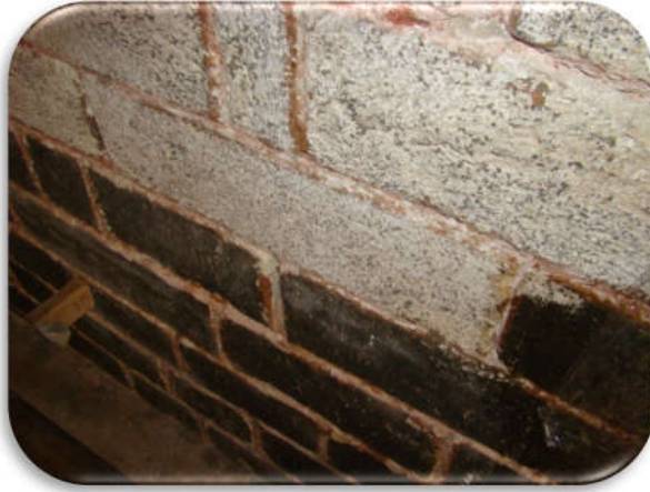
Şekil 5. 62 Fatih Tabhanesi taş yüzeylerin kâğıt hamuru ile temizliği [Y. Örs, 2012]
