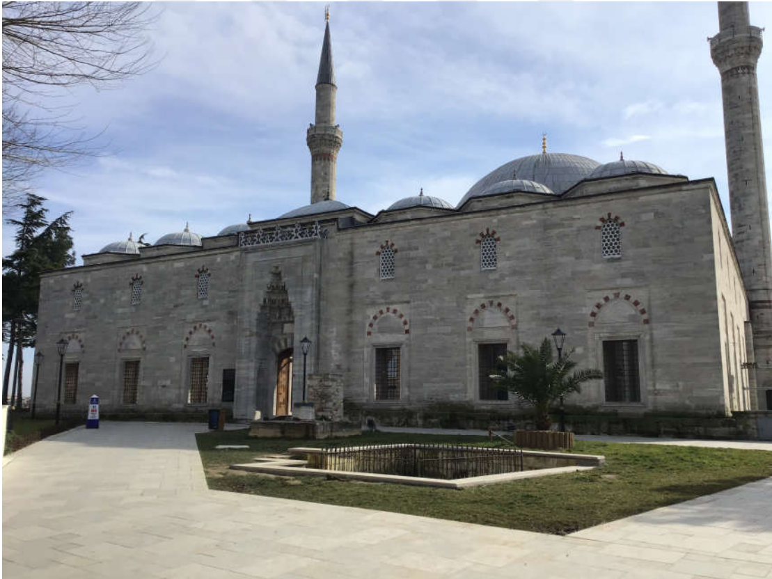
Şekil 3. 45 Yavuz Sultan Selim Camii avlu giriş cephesi [Y. Örs, 2019]
