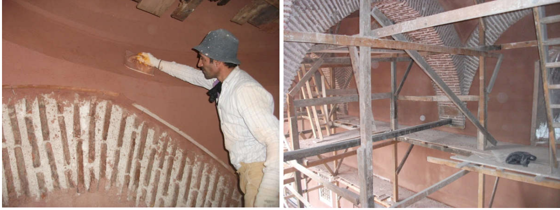
Şekil 5. 75 Fatih Tabhanesi revak duvar ve kubbeleri siva yapılması [Y. Örs, 2011]
