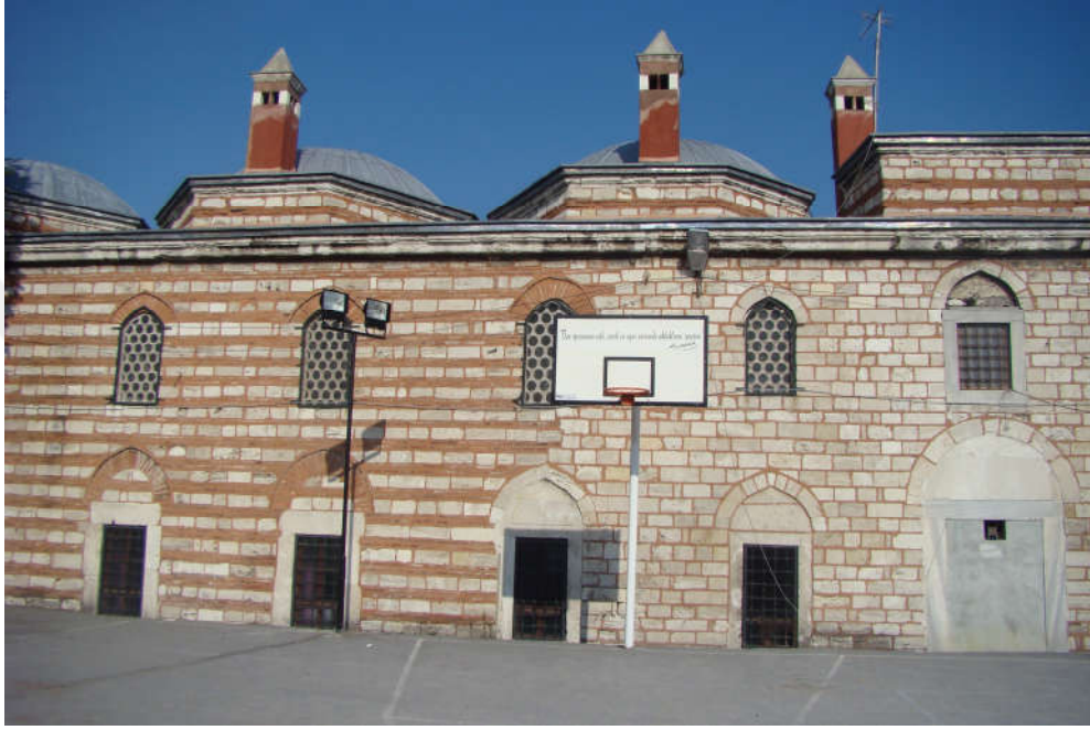
Şekil 5. 12 Fatih Tabhanesi batı cephesi [Y. Örs, 2010]
