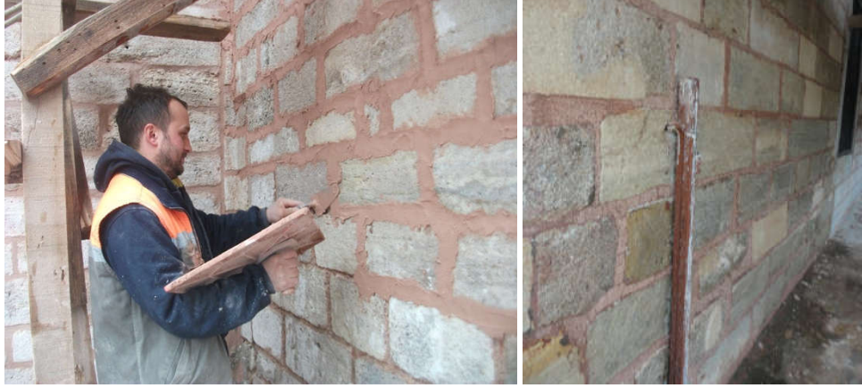
Şekil 5. 85 Fatih Tabhanesi cephelerinde derz yapılıması [Y. Örs, 2016]
