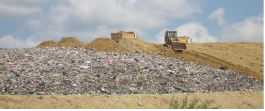
Şekil 2.23 Ara Örtünün Serilmesi
