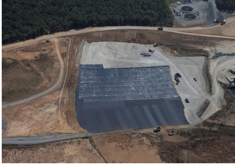
Şekil 2.11 Geotekstil Serimi
