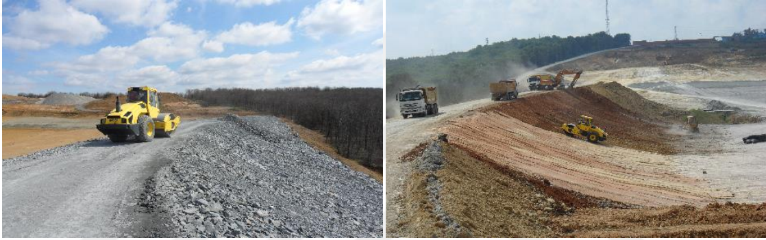
Şekil 2.20 Döküm Platformunun ve Depolama Sahası Hücresinin Oluşturulması
