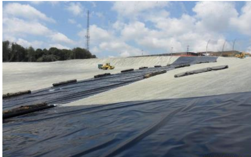
Şekil 2.9 Geomembran Serimi
