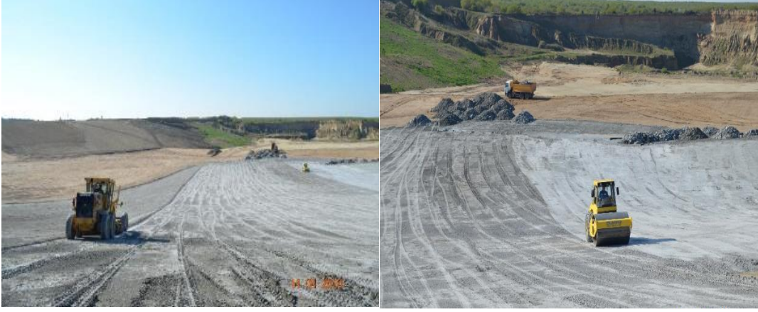
Şekil 2.7 Kil Serimi Çalışmaları
