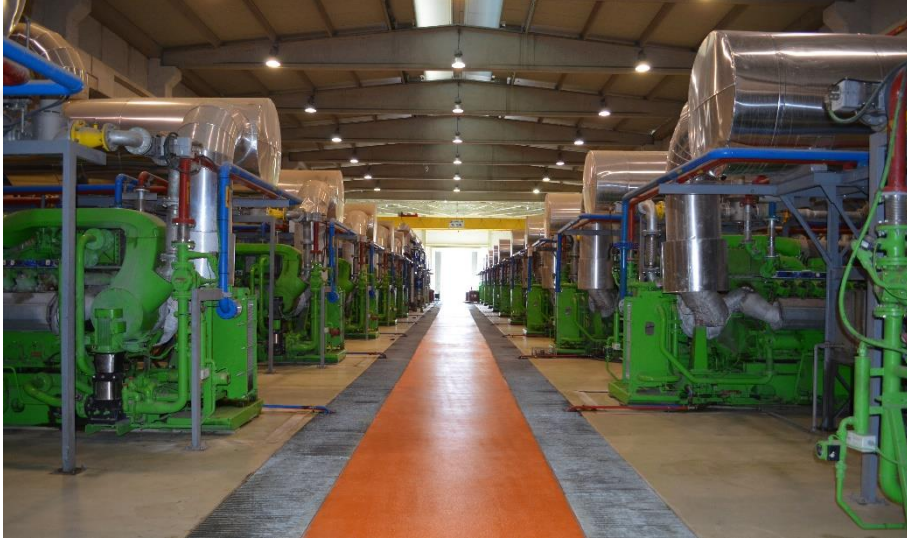
Şekil 2.18 Gaz Motorları
