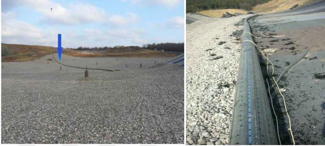
Şekil 2.13 Sızıntı Suyu Borularının Sahaya Yerleştirilmesi
