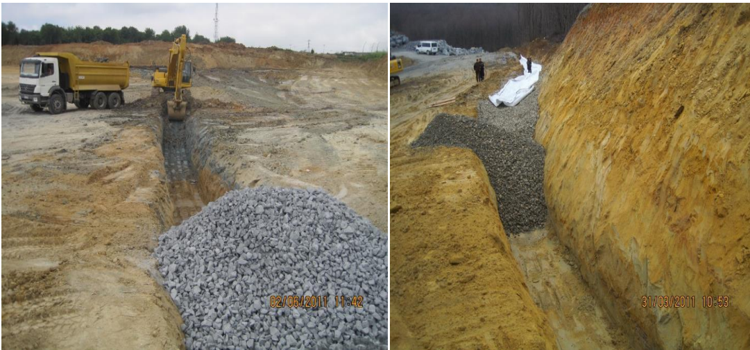
Şekil 2.6 Zemin Sularının Drenajı Çalışmaları
