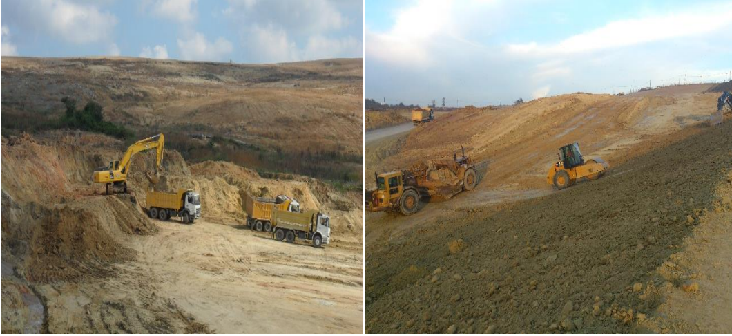
Şekil 2.5 İBB Odayeri Düzenli Dep. Sahası Saha Tesviyesi ve Hafriyat Çalışmaları (2012)
