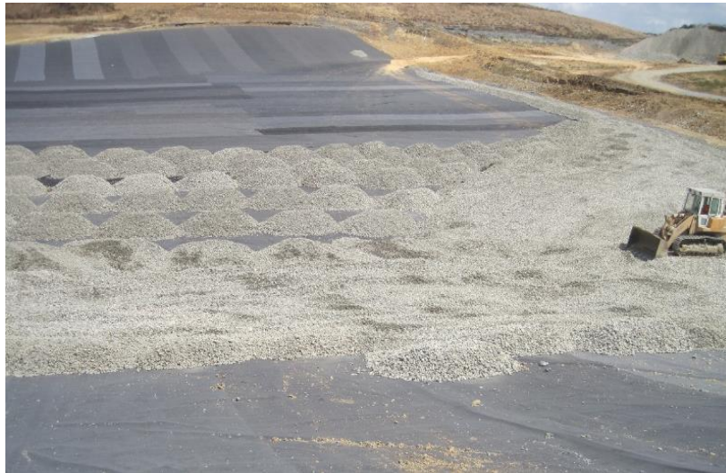
Şekil 2.12 Drenaj Tabakasının Oluşturulması (Alan Drenajı)
