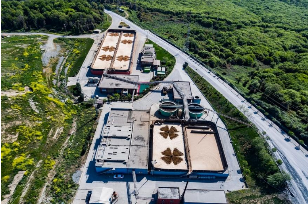
Şekil 2.14 Odayeri Çöp Sızıntı Suyu Arıtma Tesisi
