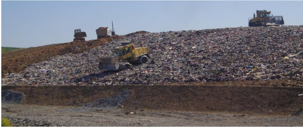
Şekil 2.22 Depolama Sahasında Çöplerin Sıkıştırılması
