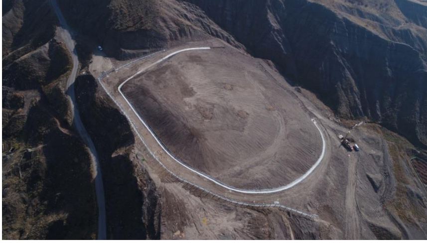
Şekil 2.27 Rehabilit Edilen Vahşi Depolama Sahası
