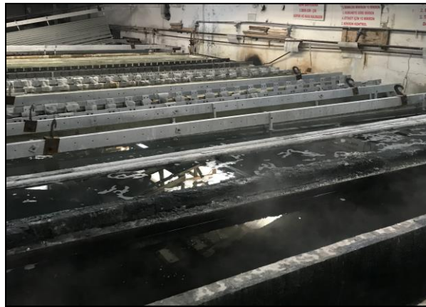
Şekil 2.2 Alüminyum eloksal kaplama tesisi
