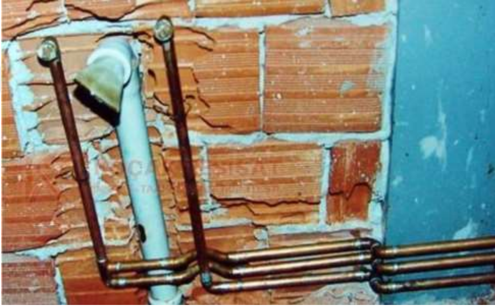
Şekil 2.2 Bakır boru ile ankastre temiz su tesisatı [10]
