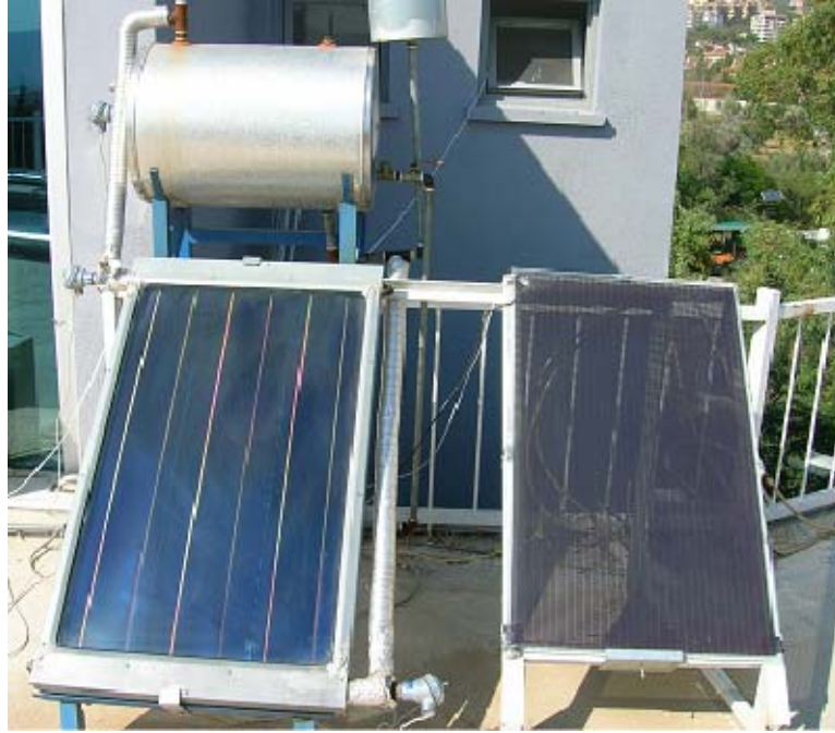
Şekil 4-8 Güneş modülü ve termal toplayıcının ayrı çalıştırılması
