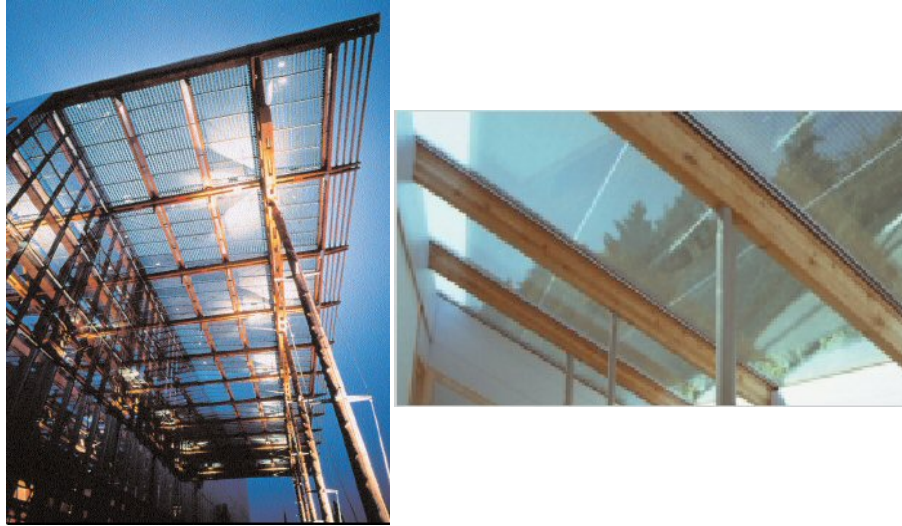
Şekil 3-2 Yarı saydam güneş pillerinin çatı malzemesi olarak kullanımı
