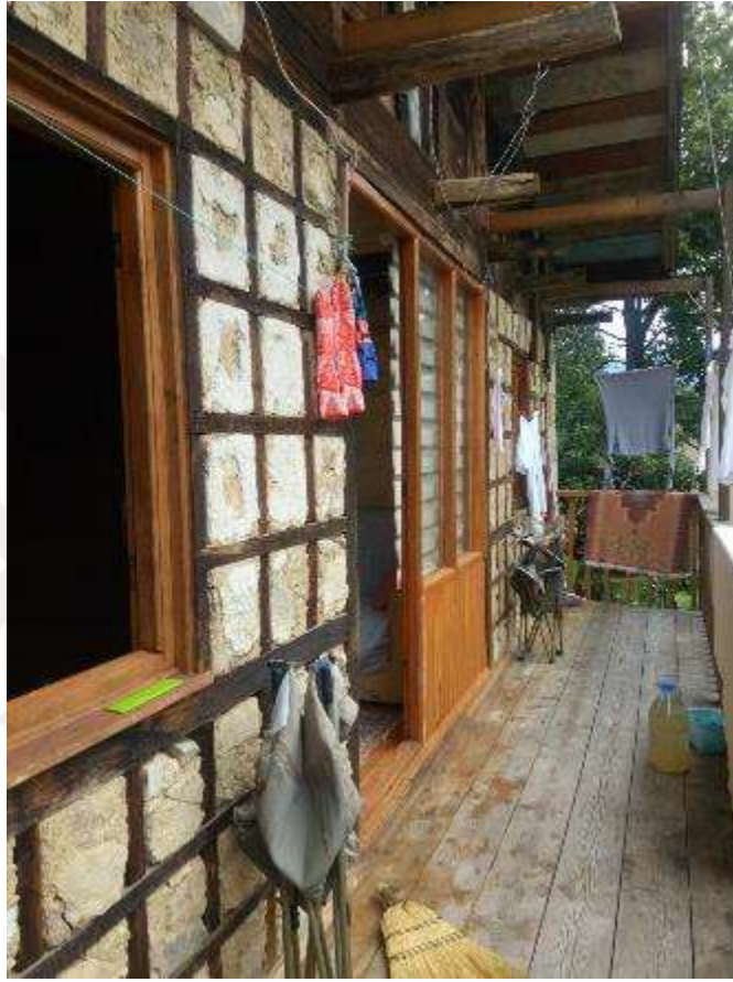
Şekil 3. 48 Göz dolma yapım sistemi, 2018 [11]
