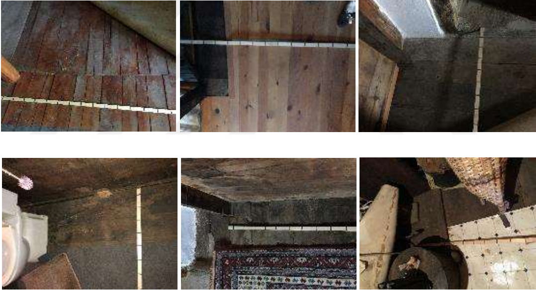
Şekil 4. 40 Yapıda kullanılan döşemeler, 2018 [11]
