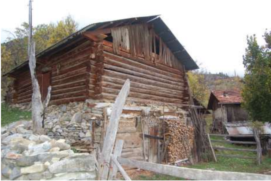
Şekil 3. 9 Ahşap yığma ve taş yığma tekniği kullanılan konut [57]
