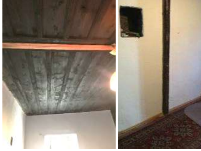
Şekil 4. 19 Özgün duvar hattını gösteren kiriş ve duvardaki kalas, 2018 [11]
