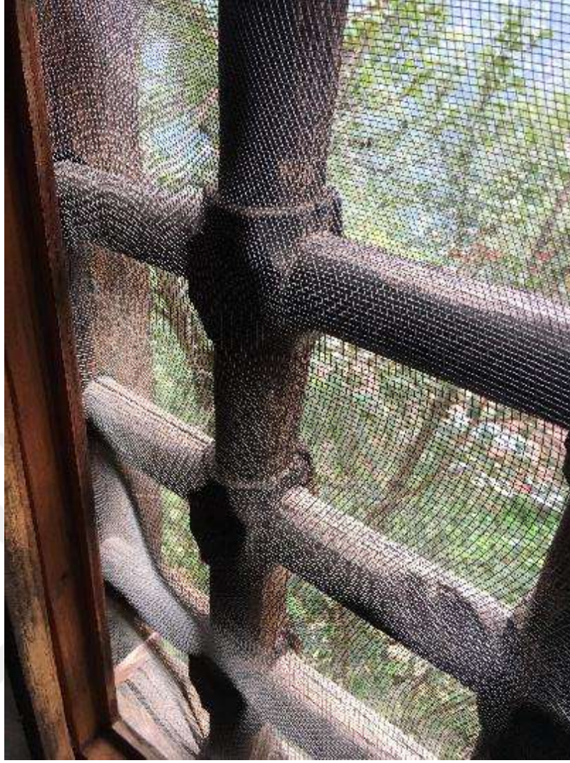
Şekil 4. 46 Düzgün sekizgen ahşap lokmalık parmaklık, 2018 [11]
