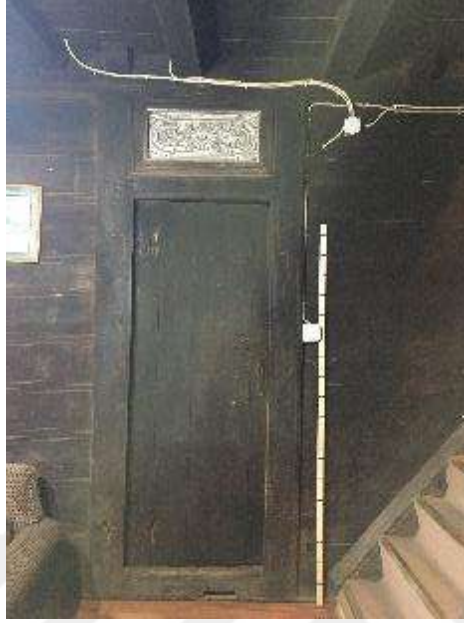
Şekil 4. 53 Bezeme üzerine uygulanan soba boyası, 2018 [11]
