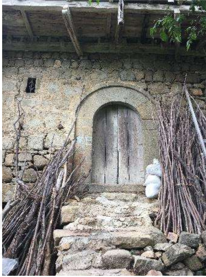
Şekil 3. 7 Kapı kenarında makaralı kemer taş, 2018 [11]
