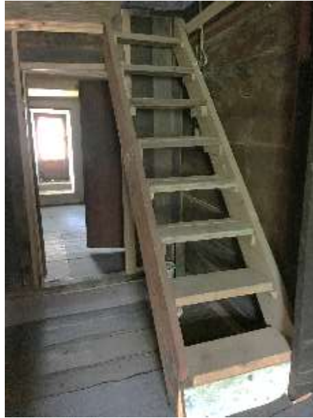
Şekil 4. 52 Kedi merdiveni yerine yapılan merdiven, 2018 [11]
