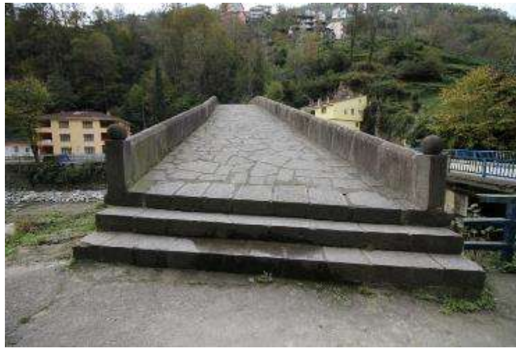
Şekil 2. 29 Güneyce köprüsü Doğu inişi [44]
