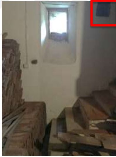
Şekil 4. 7 Aydınlık penceresi ve niş için bırakılan boşluklar, 2018 [11]
