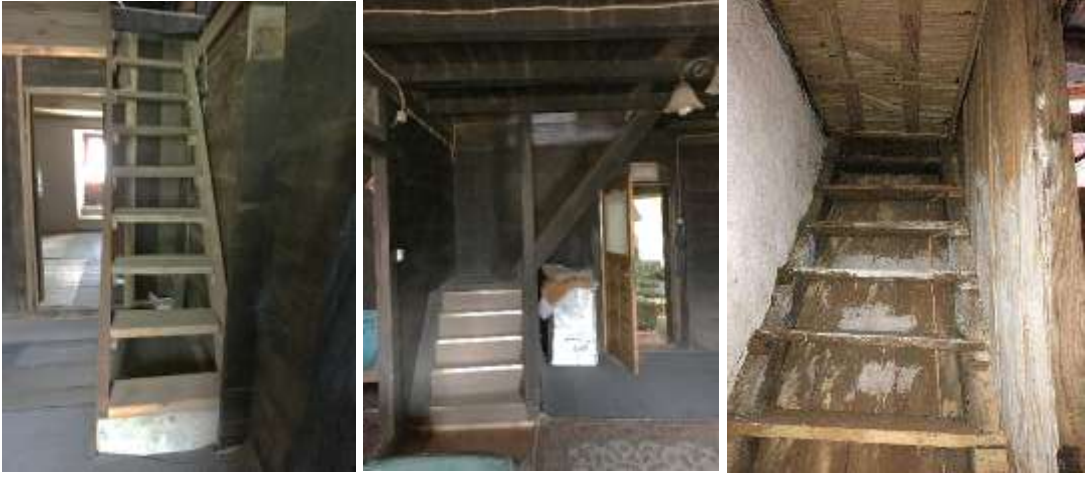
Şekil 4. 47 Yapıda bulunan merdivenler, 2018 [11]
