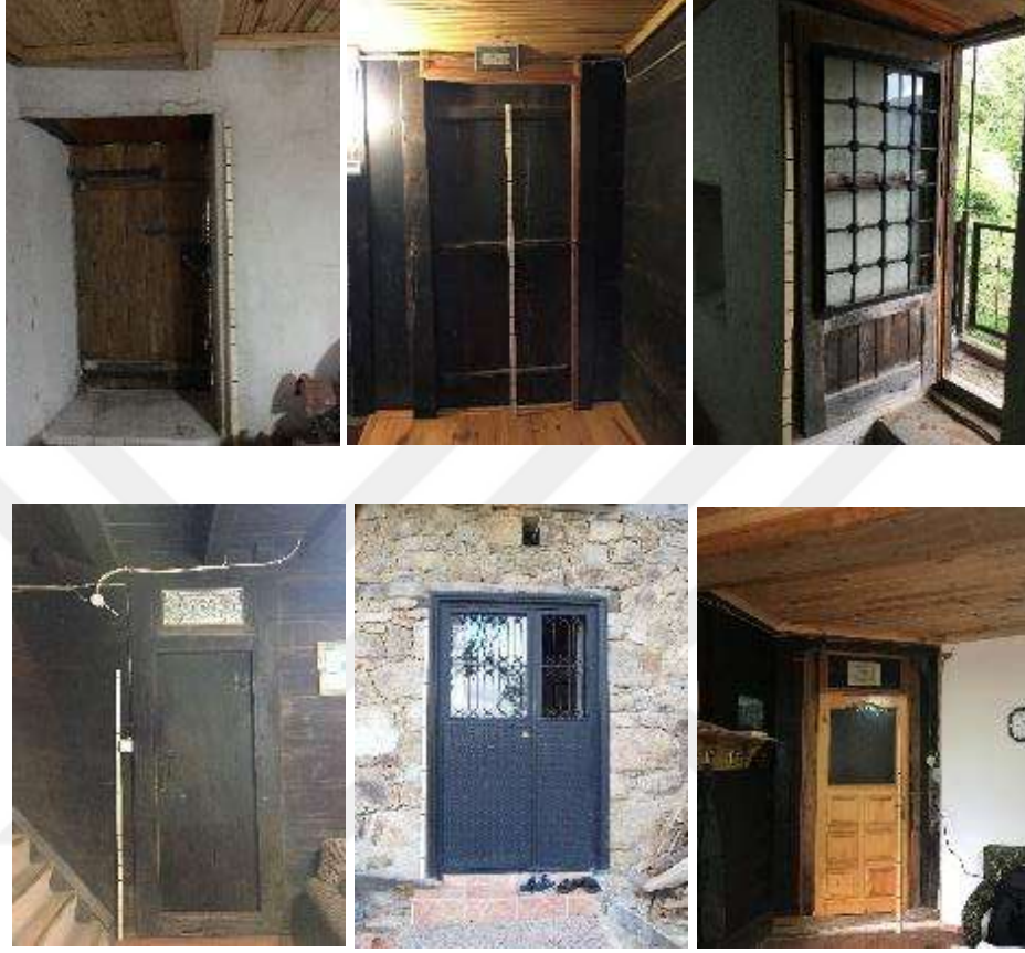
Şekil 4. 43 Yapıda bulunan kapılar, 2018 [11]
