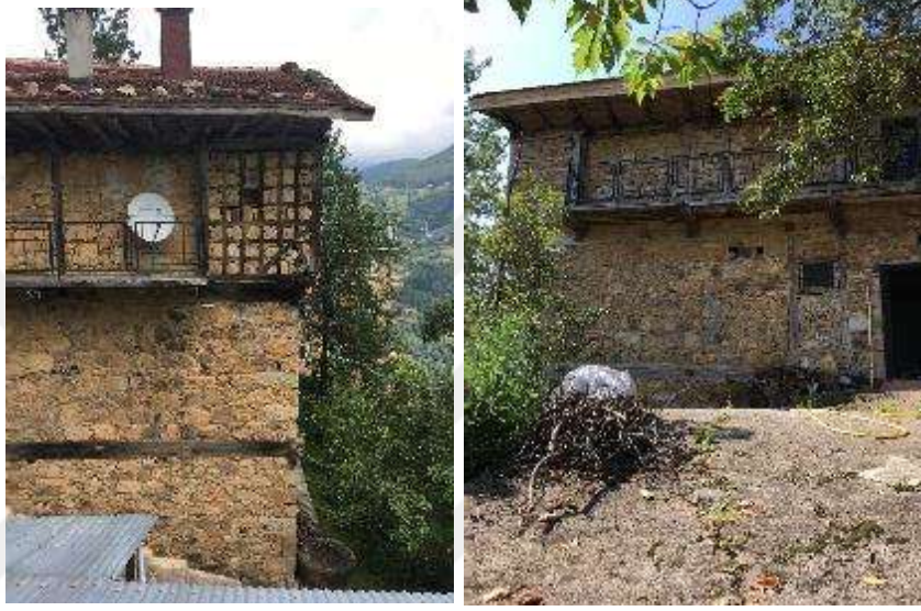
Şekil 4. 38 Göz dolma ve sıra hatıllı moloz taş yapım sistemi, 2018 [11]
