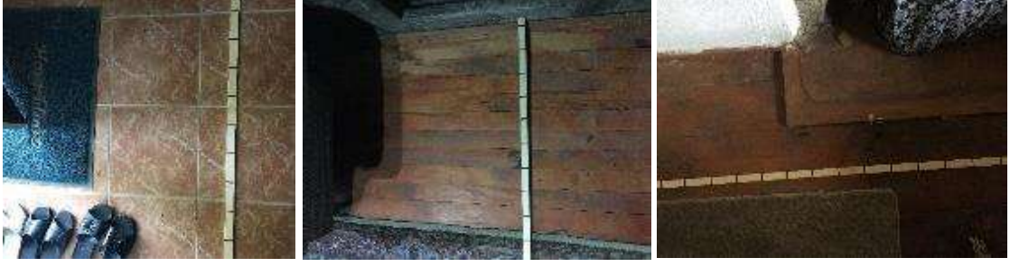
Şekil 4. 41 Yapıda kullanılan döşemeler, 2018 [11]
