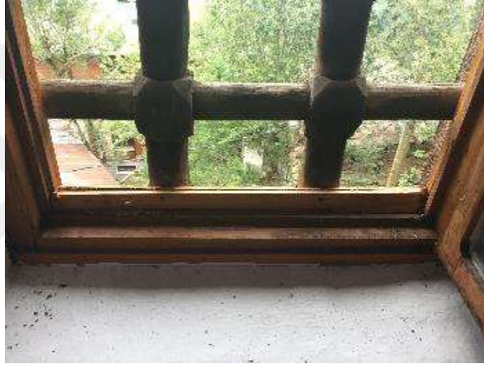
Şekil 5. 8 Özgün ahşap lokmalı parmaklık, 2018 [11]
