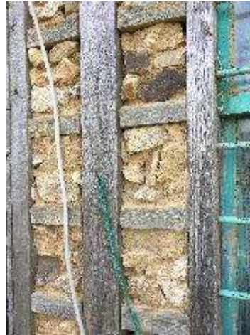
Şekil 3. 18 Göz dolma yapım tekniđi, 2018 [11]
