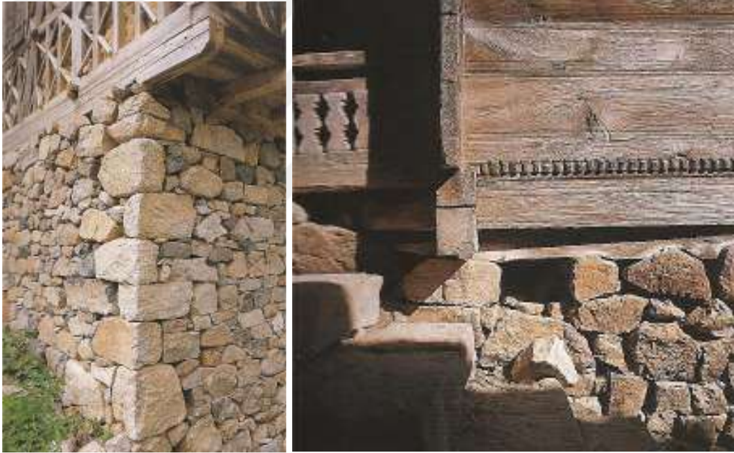
Şekil 3. 14 Temel ve taban kirişi birleşimi [73]
