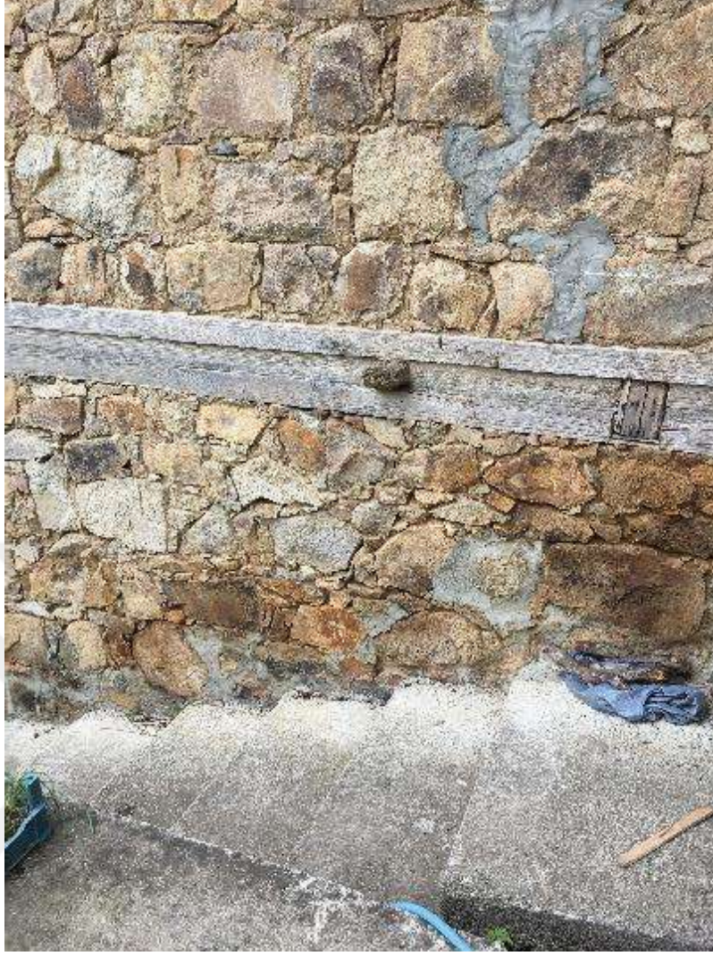
Şekil 4. 48 Beton malzeme ile kaplanan merdivenler, 2018 [11]
