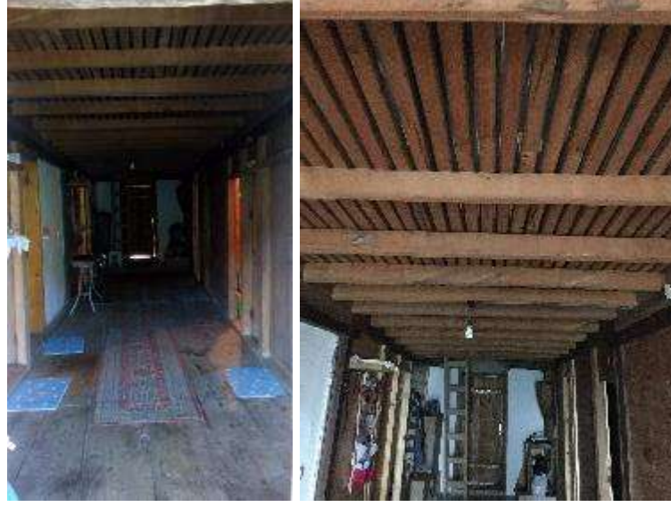
Şekil 3. 58 Aralıklı ahşap döşeme, 2018 [11]
