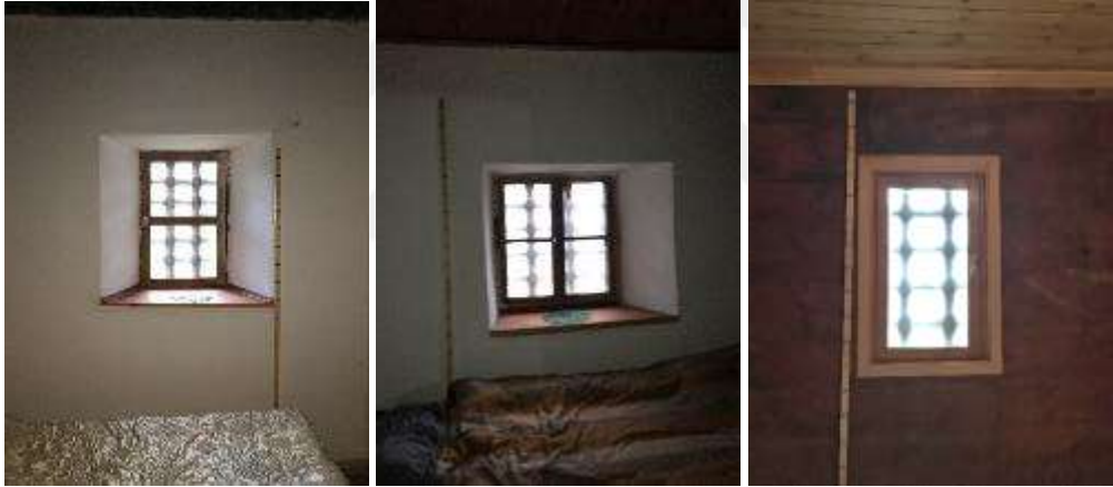
Şekil 4. 45 Yapıda bulunan pencereler, 2018 [11]
