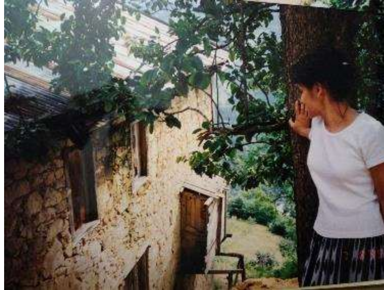
Şekil 3. 32 Yapıya dışardan eklenen tuvalet, Yeşilyurt Mahallesi, 2018 [11]
