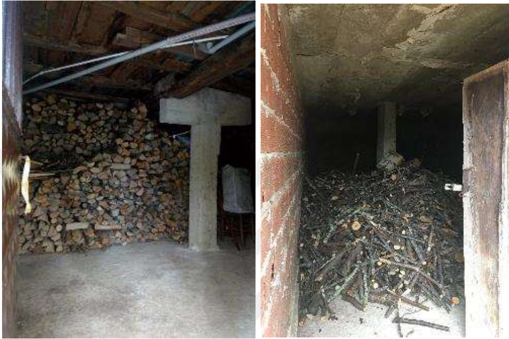
Şekil 3. 46 Ahır mekânı ikiye ayıran tuğla duvar ve betonarme ek kolon, 2018 [11]
