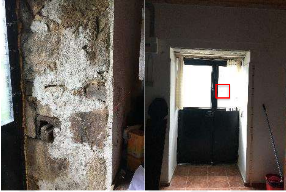
Şekil 4. 44 K1 ve K3 kapı arkalarında bulunan dayak yerleri, 2018 [11]
