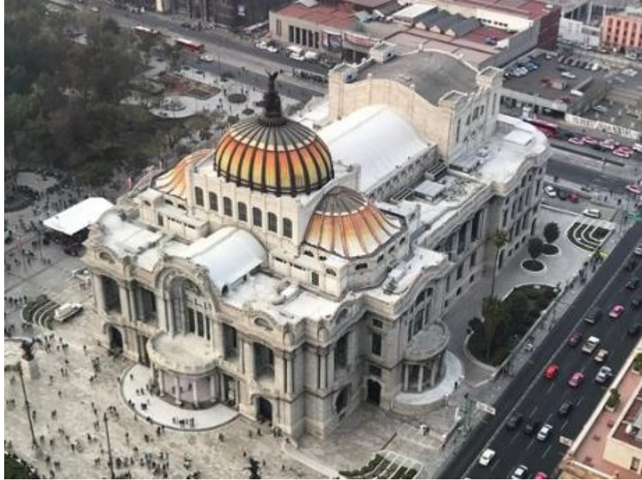
Şekil 2.22 Konsolidasyon oturması sorunu yaşayan bir yapı [71]
