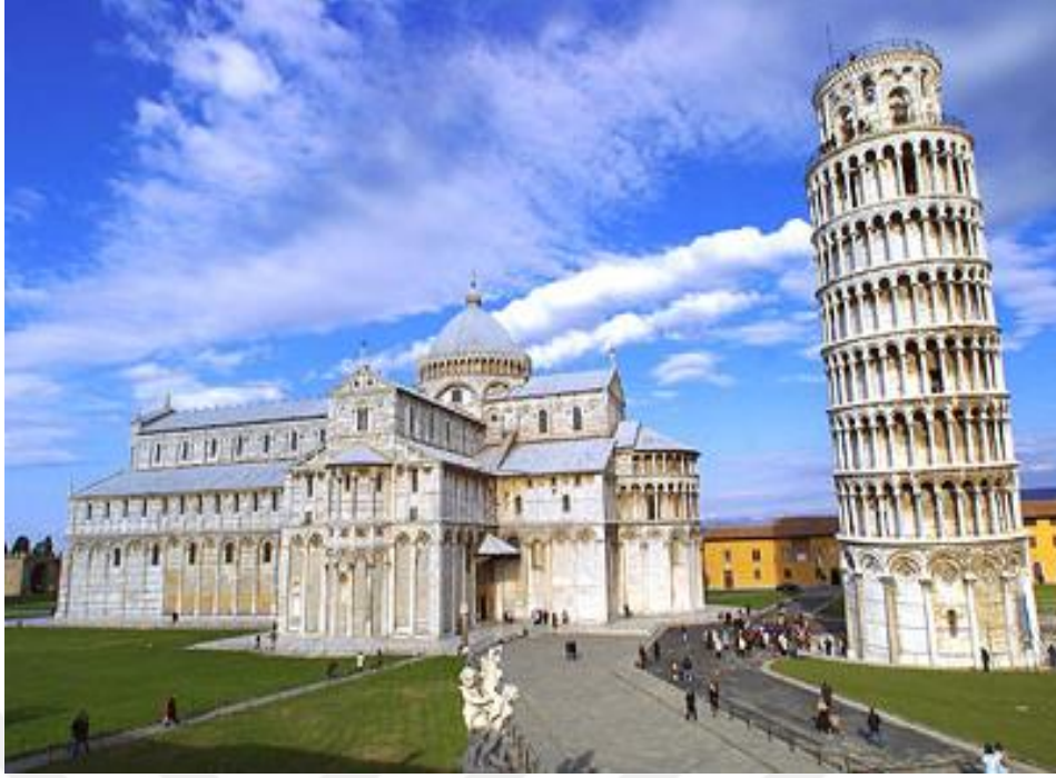
Şekil 2.18 Zayıf zeminlerde yaşanan oturma problemi [69]
