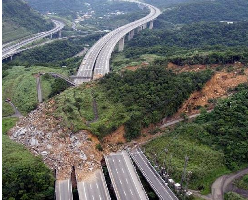
Şekil 2.20 Tayvan’da meydana gelen şev kayması [70]
