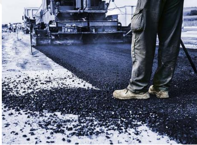
Şekil 2.14 Yol stabilizasyon işlemlerinde bitüm uygulaması [66]
