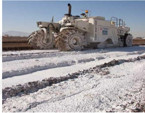
Şekil 2.4 Kireç ile Zemin İyileştirme Uygulaması [37]
