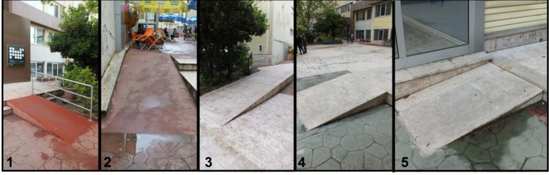
Şekil 4. 23 Kocaeli Üniversitesi Anıtpark Yerleşkesi'nde bulunan rampalar [149]
