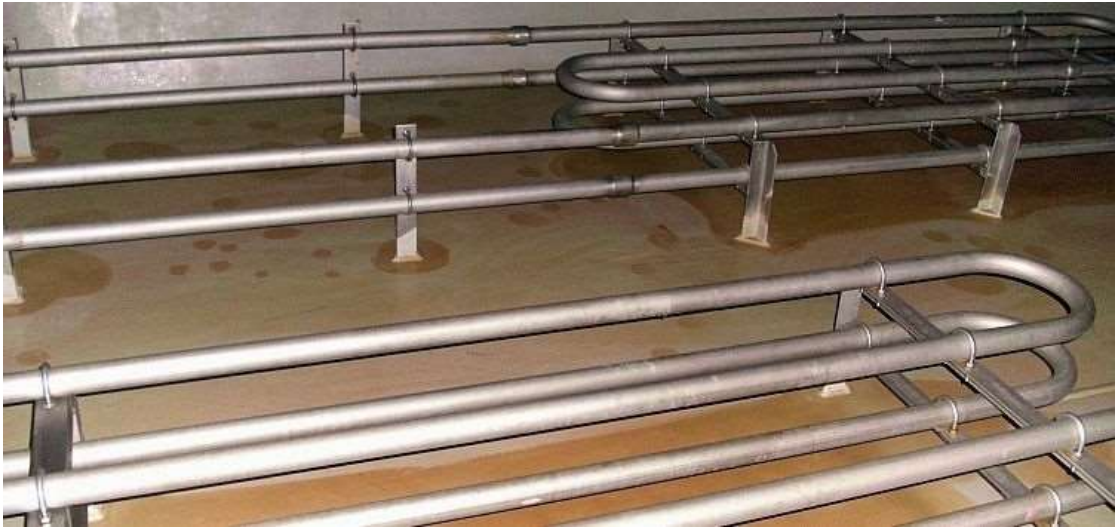
Şekil 5.4 Tank içinde bulunan ısıtma borularının yapısı
