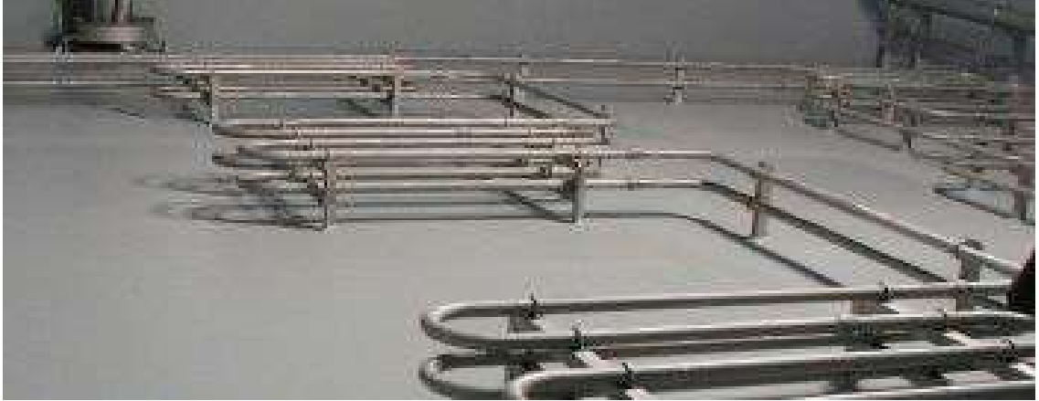
Şekil 5.3 Çinko Silikat Tank Kaplaması
